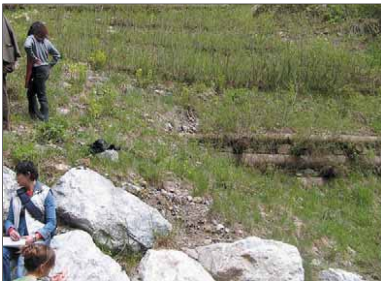
Figura 3.34 - Sistemazione con palificate vive dei versanti del Rio Rufosco, a Paluaro (UD), dopo la frana seguita all'alluvione del 1996.
