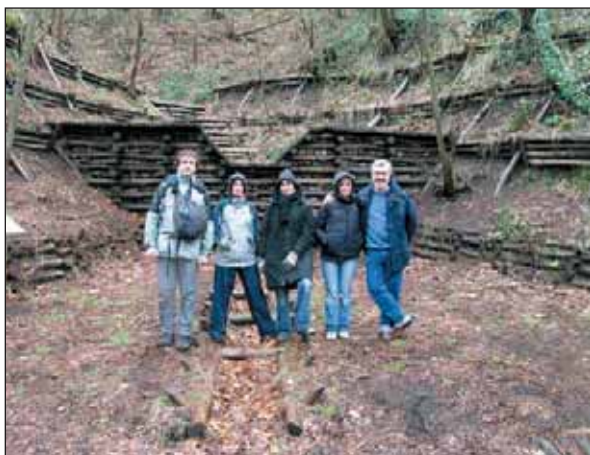
Figura 3.13 – Attività outdoor al sentiero n.3 “Il Monte Somma” Intervento combinato : briglia e canaletta in legname e pietrame, palificata viva doppia, grata viva “Vesuvio”.
