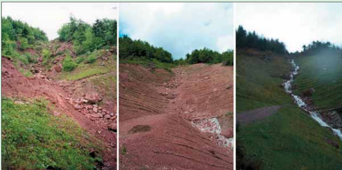
Figura 3.41 - Sistemazione di versanti nel bacino del Torrente Ruat (915 m s.l.m.).
