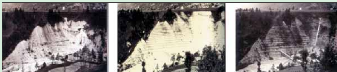
Figura 3.38 - Resia (UD) 1925 -1935: Intervento di sistemazione di un versante in frana dovuto ad erosione al piede ad opera del torrente omonimo.
