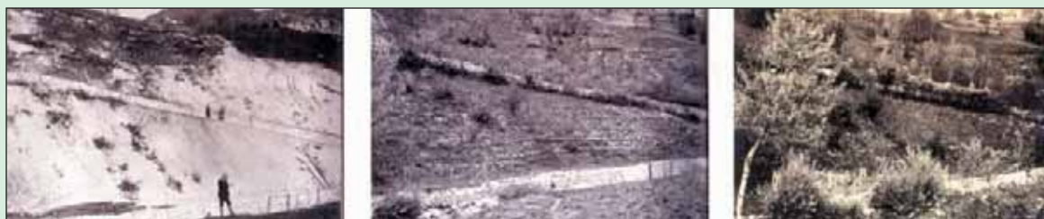
Figura 3.37 - Resia (UD) 1925 -1935: Intervento di sistemazione di un versante in frana.
