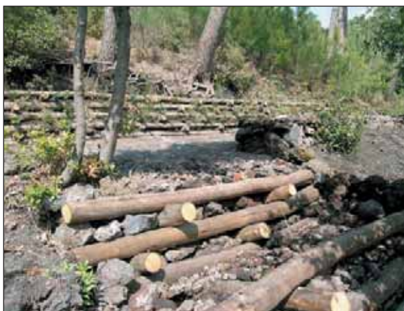
Figura 3.15 – Attività outdoor al sentiero n. 4 “Riserva Tirone”. Messa in sicurezza di un versante in materiale piroclastico.
