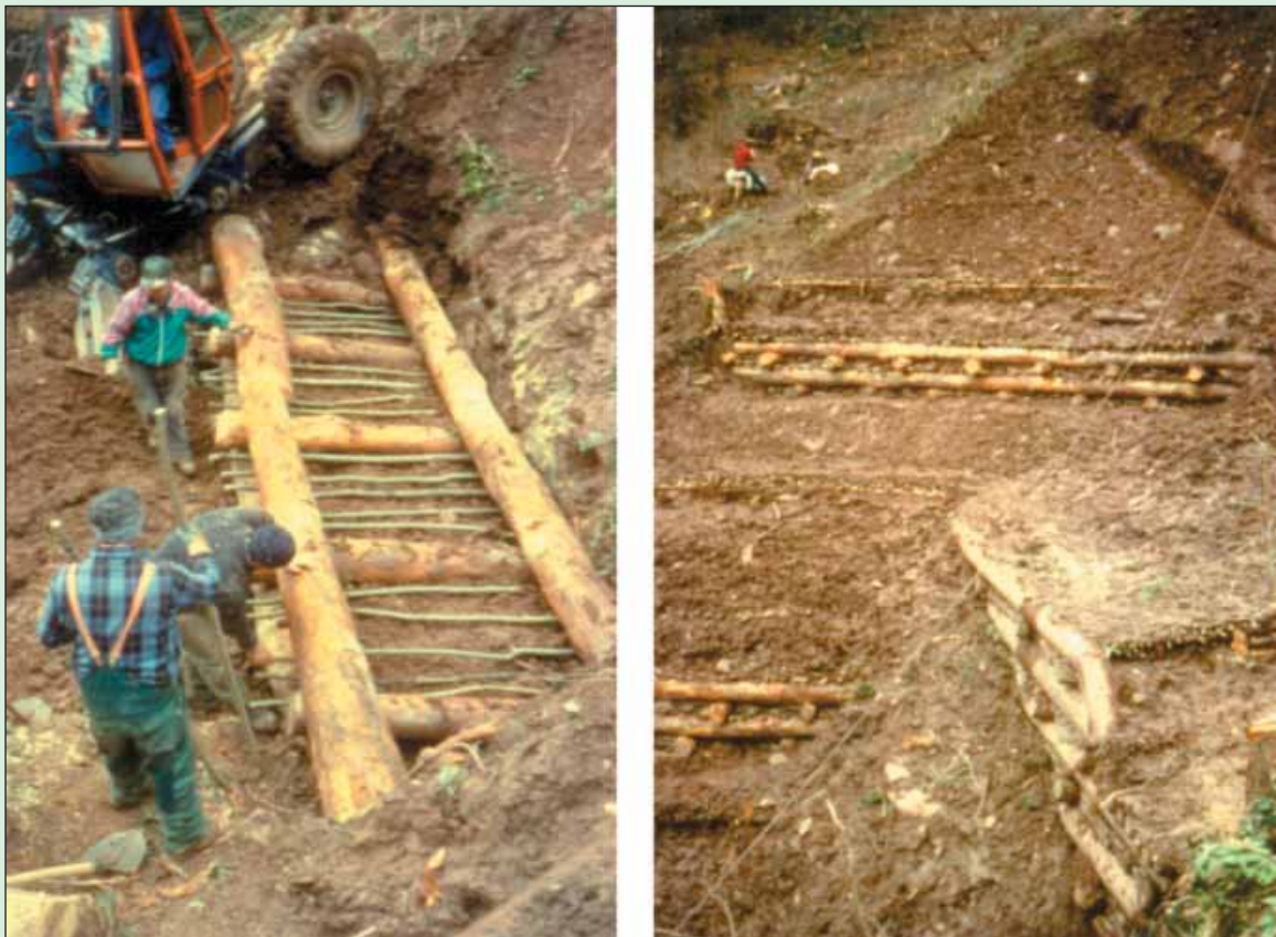
Figura 3.39 - Palificate vive a doppia parete.
