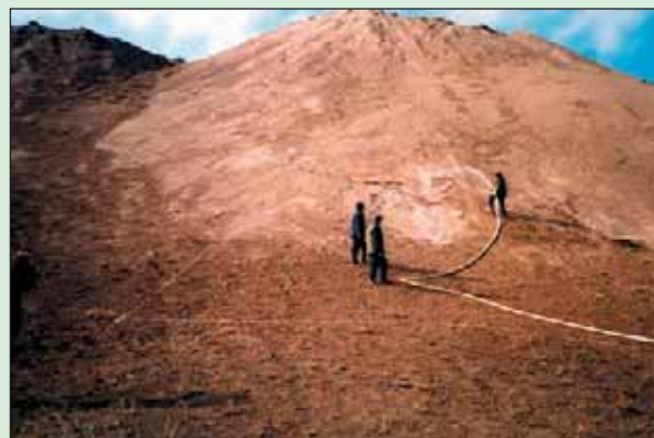
Figura 3.7 - Idrosemina delle parcelle sperimentali.
