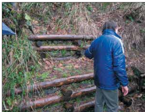
Figura 3.12 - Attività outdoor al sentiero n. 3 “Il Monte Somma” nel Parco Nazionale del Vesuvio: palificata viva a doppia parete 2Vesuvio” sec. Menegazzi
