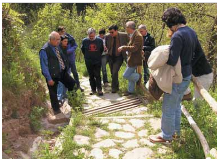
Figura 3.33 - Interventi di sistemazione lungo il sentiero “Generale Rocca” a Tolmezzo, colpita dai nubifragi del 1993 e 1996.
