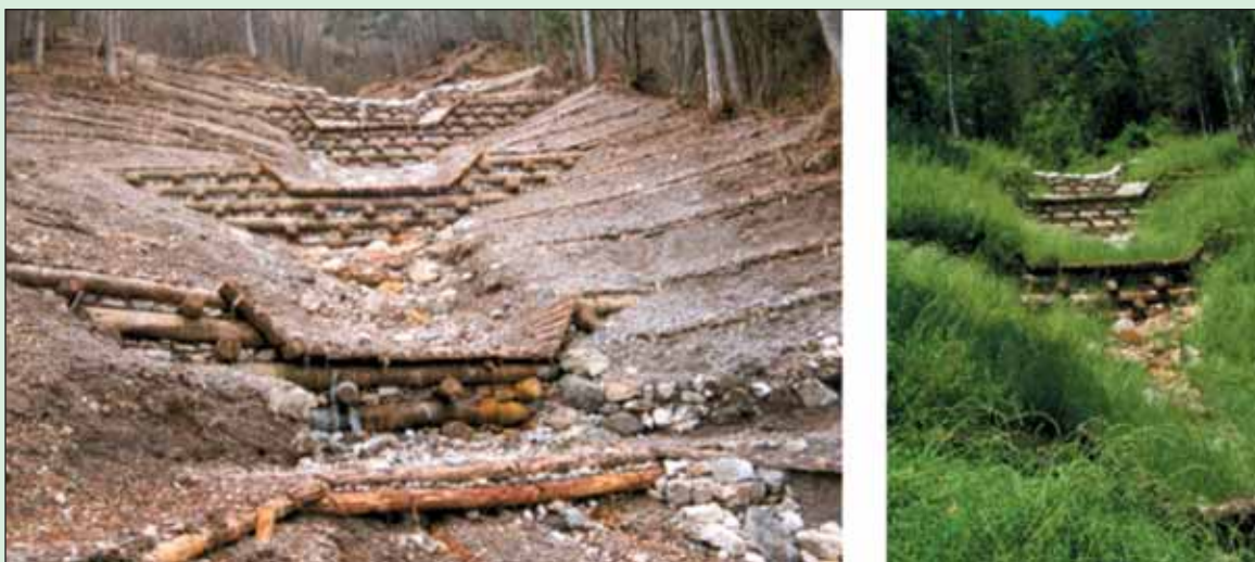
Figura 3.40 - Strada Lago Verzegnis – Strada Tualis (570 m s.l.m.): sistemazione di un versante in frana, con briglie in pietrame e legname, e consolidamento dei versanti con cordone vive.
