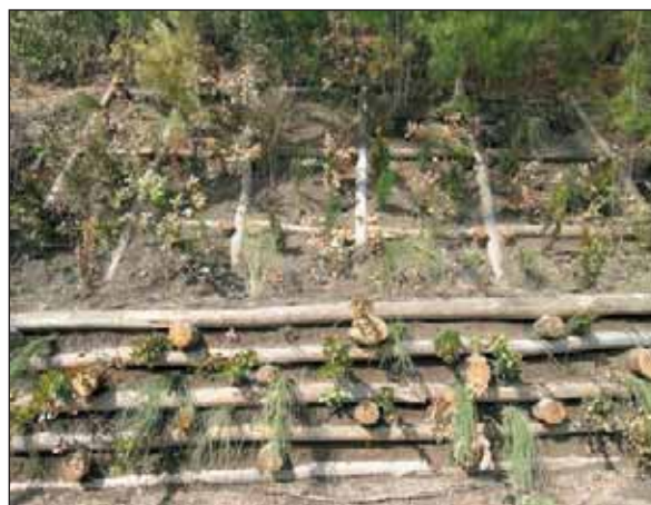
Figura 3.16 – Attività outdoor al sentiero n. 4 “Riserva Tirone”. Palificata viva a doppia parete “Vesuvio” e grata viva “Vesuvio”
