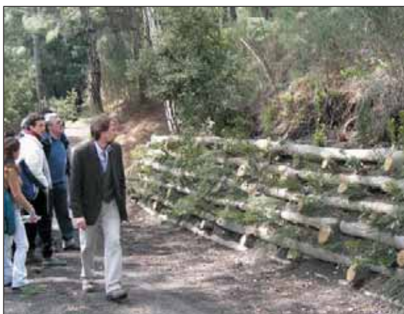
Figura 3.17 - Illustrazione pratica degli interventi realizzati nel Parco Nazionale del Vesuvio, utilizzando esclusivamente piante arbustive e arboree
