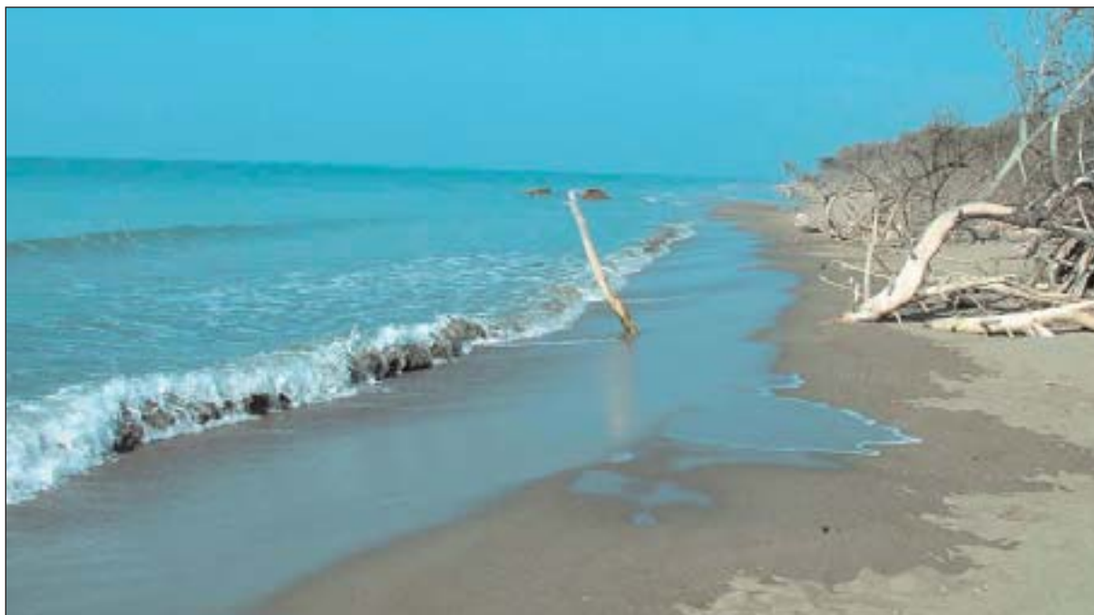
Fig. 5.7 – Gli effetti dell’erosione della spiaggia di Marina di Alberese.
