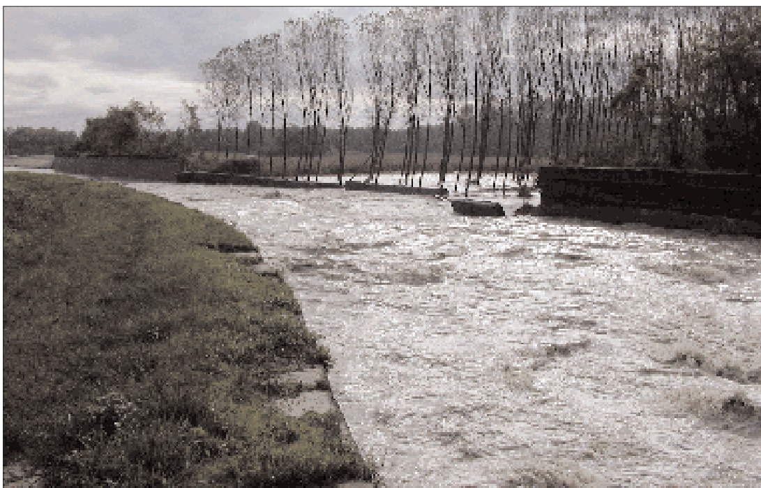
Fig.4.40: Mattina del 17 ottobre. Canale Farini all'altezza della SORIN . Attraverso il punto di rotta (della lunghezza di ca. 80 m) il flusso idrico si riversa in direzione degli stabilimenti.
