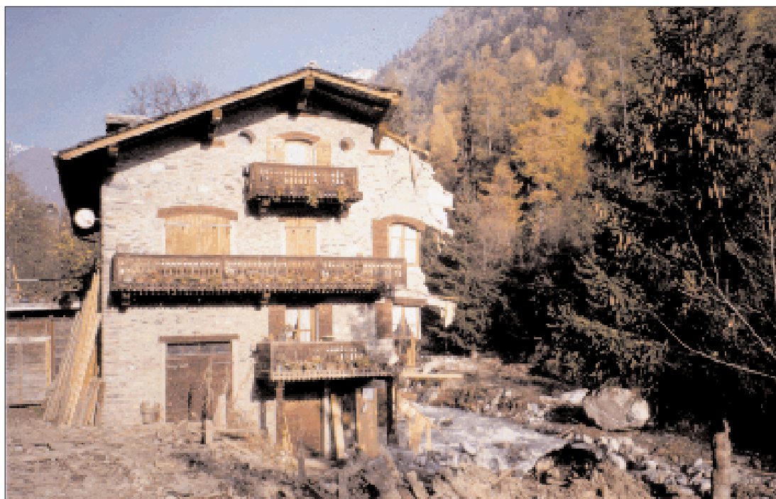
Figura 4.20: L'abitazione distrutta dall'esondazione del torrente S.Barthelemy in località Fabriques.
