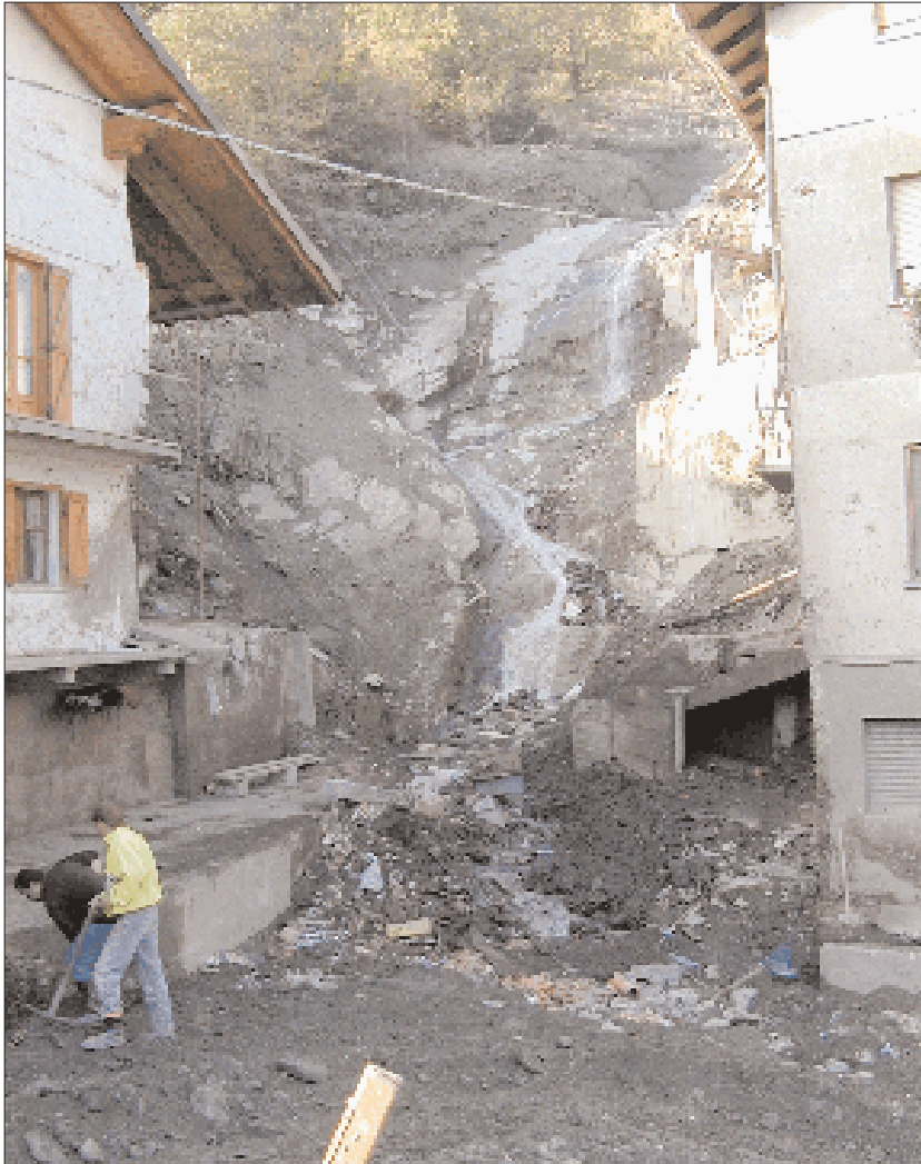
Figura 4.15: Gli effetti disastrosi della colata sugli edifici nel centro abitato di Messigny.
