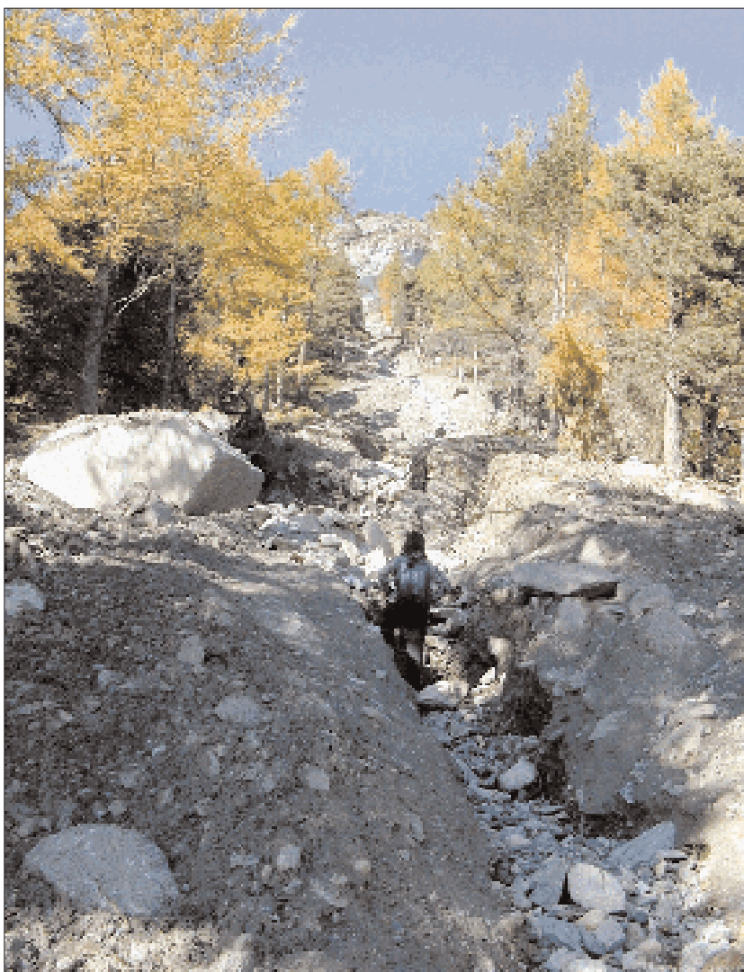
Figura 4.26: Colata di fango, detrito e blocchi innescata in corrispondenza della strada di accesso alla cava.
