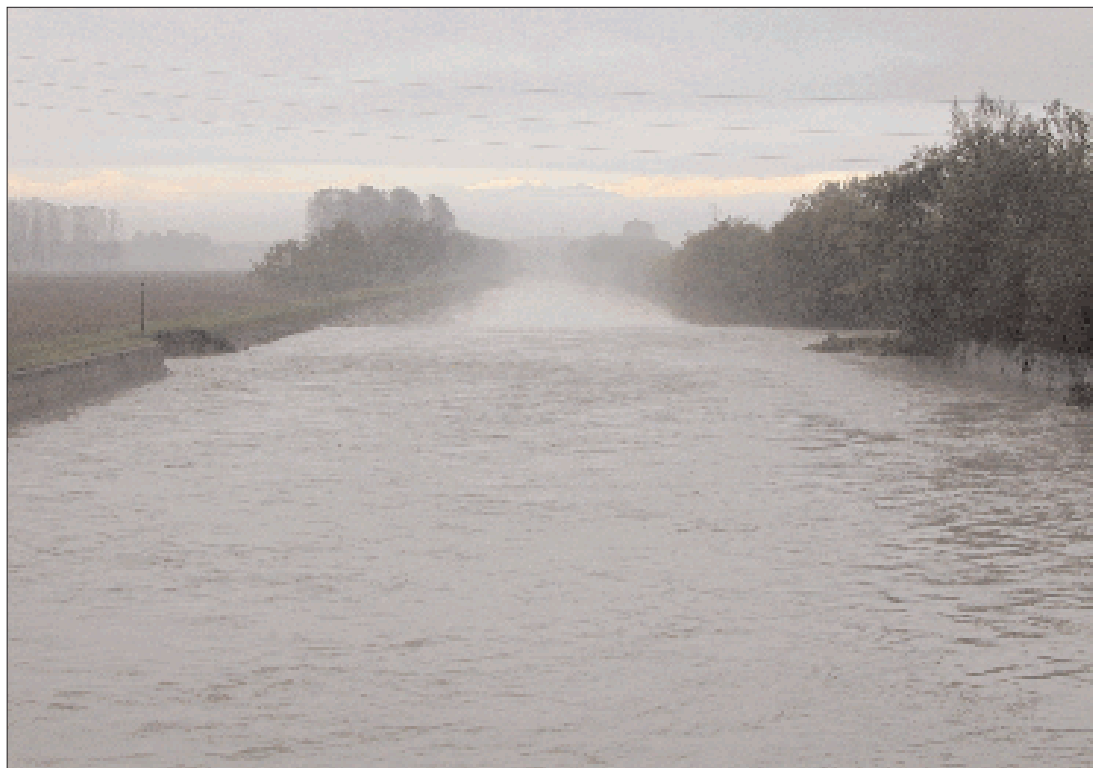
Fig. 4.39 Mattina del 17 ottobre. Punto di rotta del Canale Farini nei pressi di Ponte del Ronco. Il flusso idrico si immette nel canale dal lato destro dell'immagine.
