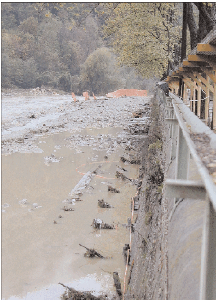
Figura 4.42: Il fiume Bormida di Millesimo visto dal recinto dello stabilimento Acna C.O. Al centro si nota la fila di micropali a sostegno del muro di contenimento. L'alveo di magra del fiume è posto sulla sinistra.
