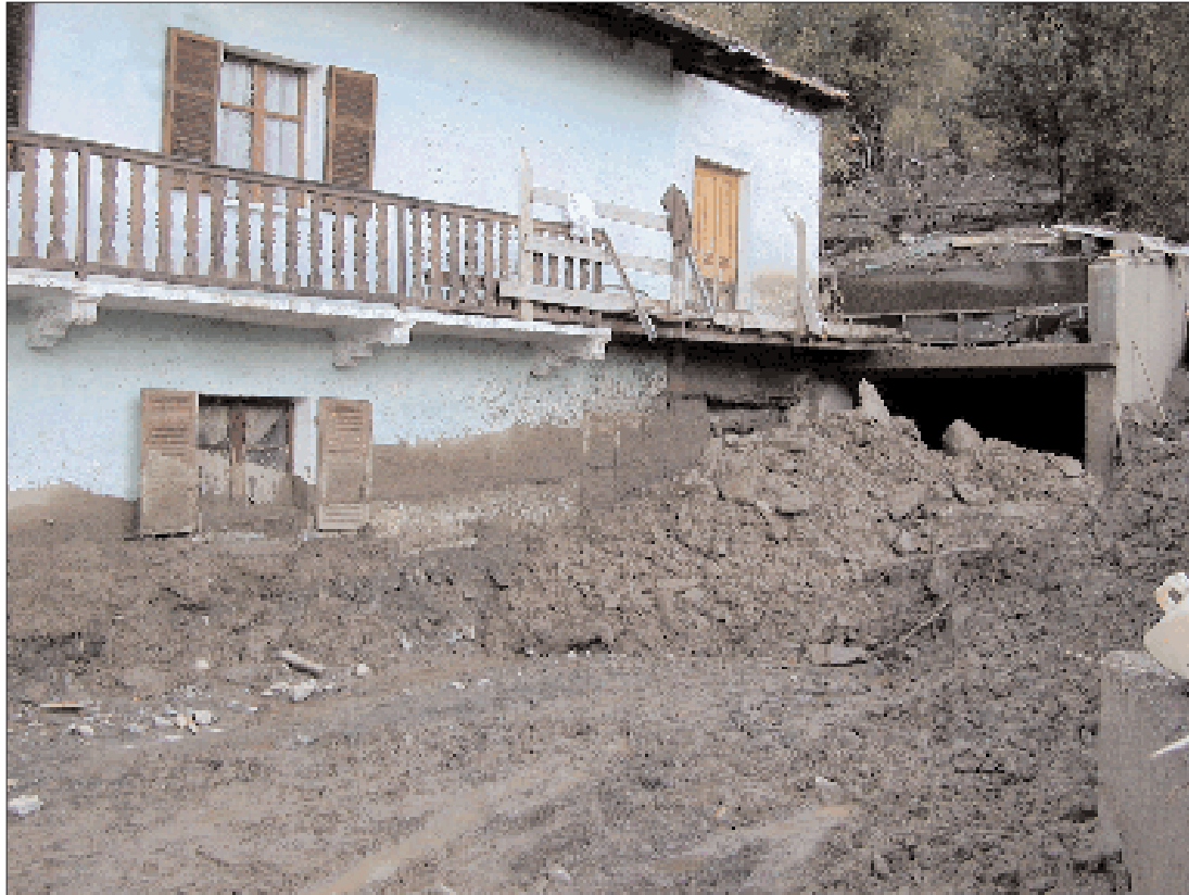
Figura 4.8: Rovarey: immagine indicativa dei danni subiti da molte abitazioni a Fenis: fango e detriti hanno riempito i piani bassi ed i garages, talora provocando anche lesioni alle tamponature e talora a strutture portanti.
