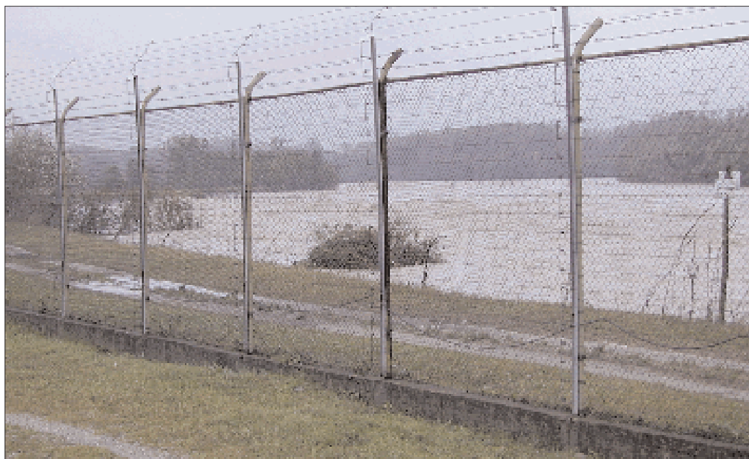
Fig. 4.36: L'alveo della Dora Baltea nel pomeriggio del 16 ottobre in corrispondenza dell'argine e della rete di recinzione dell'impianto EUREX. Il livello dell'acqua si trova alcune decine di centimetri sotto il livello di sfioro.
