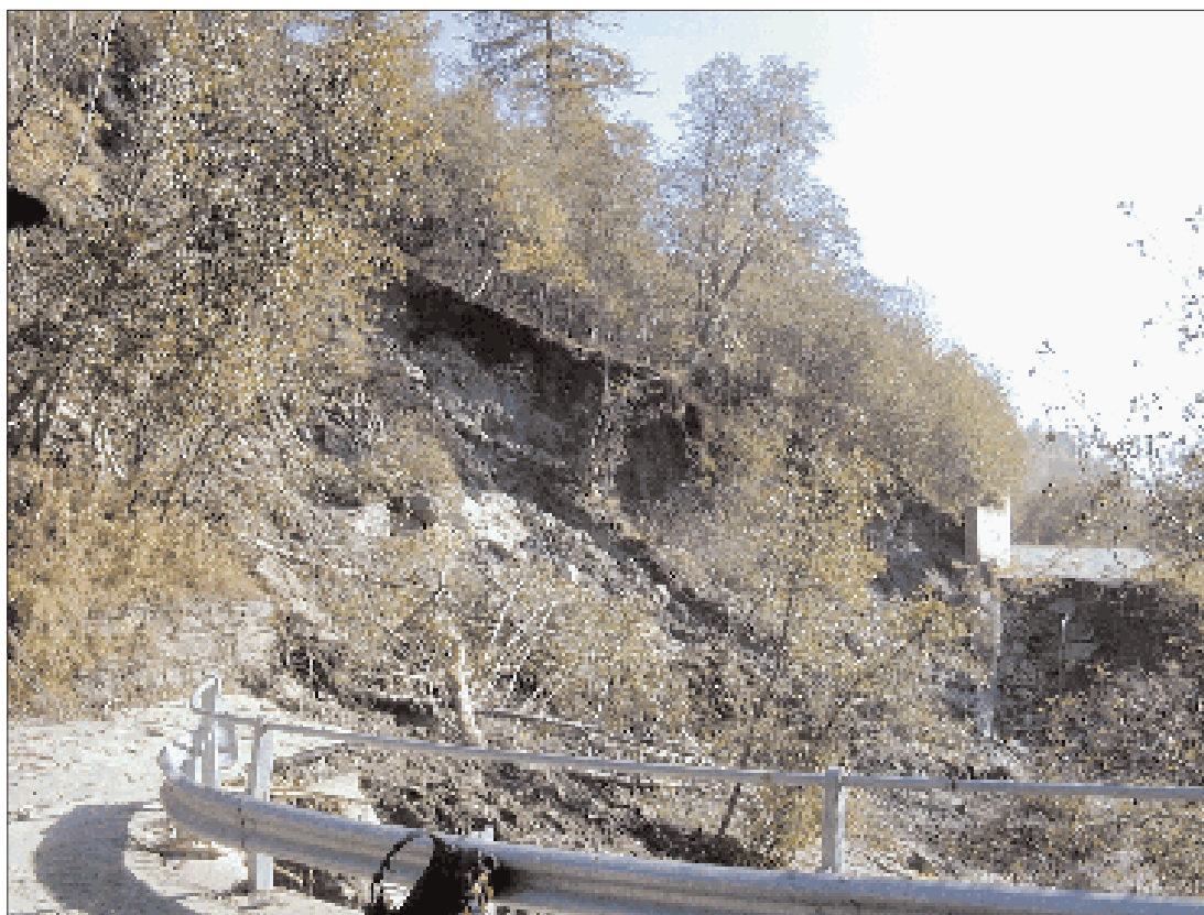
Figura 4.21: Strada interrotta in corrispondenza del ponte sul torrente Chaleby.
