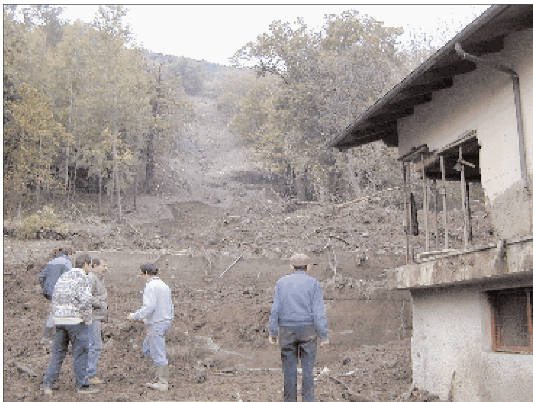
Figura 4.13: Casa lesionata da una frana a Tillier.
