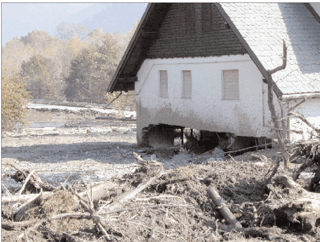
Figura 4.16: L'abitazione nei pressi della Strada Statale della Val d'Aosta investita dalla colata di Messigny.
