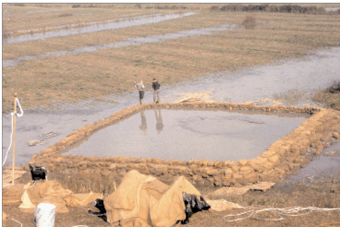
Figura 4.45: Riduzione dei fenomeni di sifonamento di un fontanazzo nel comune di Marcara.
