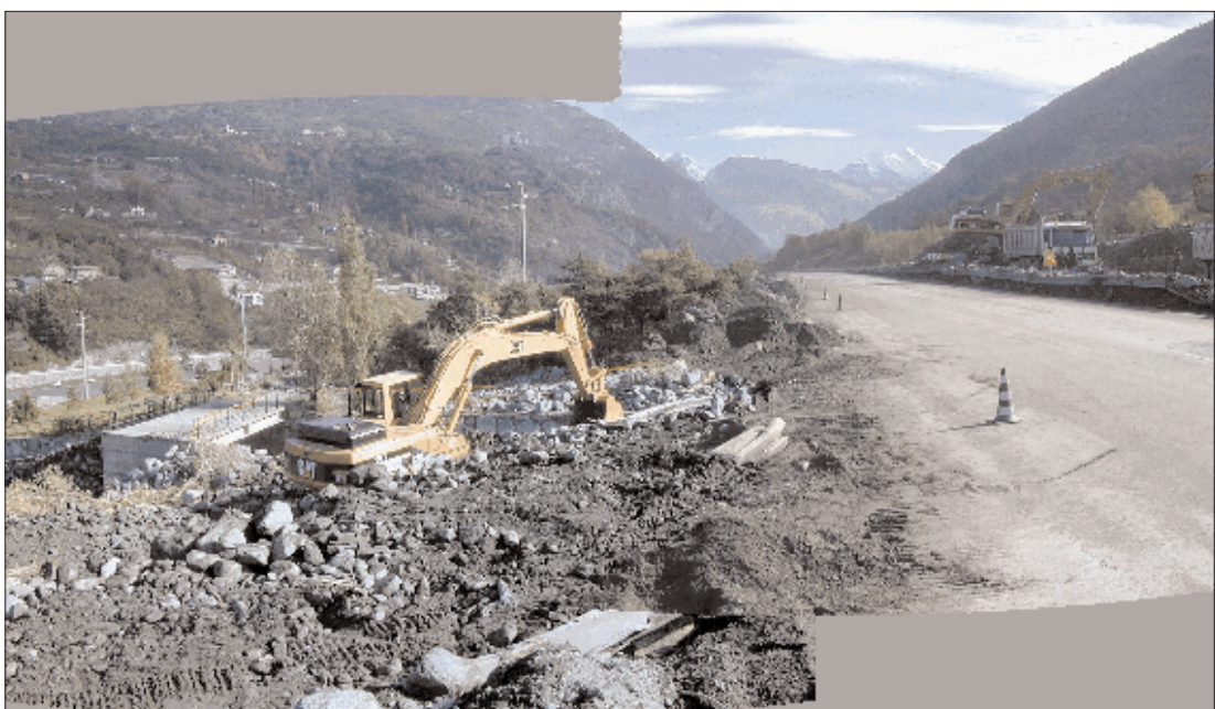
Figura 4.2: Un tratto dell'autostrada Torino-Aosta appena riaperta il giorno 18 ottobre, dopo che un debris flow il giorno 16 aveva ostruito la sede stradale.
