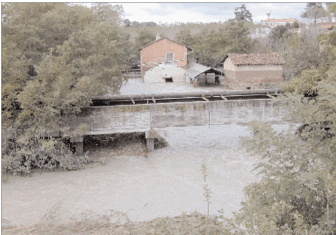
Fig.4.38: Mattina del giorno 17 ottobre. Canale di derivazione in prossimità del tracciato ferroviario della linea Milano-Torino. Nell'immagine è visibile il ponte della ferrovia, utilizzato come linea di drenaggio del bacino formatosi a monte del rilevato. Si noti la discesa di ca. 3 m del livello delle acque rispetto al massimo dell'evento alluvionale.
