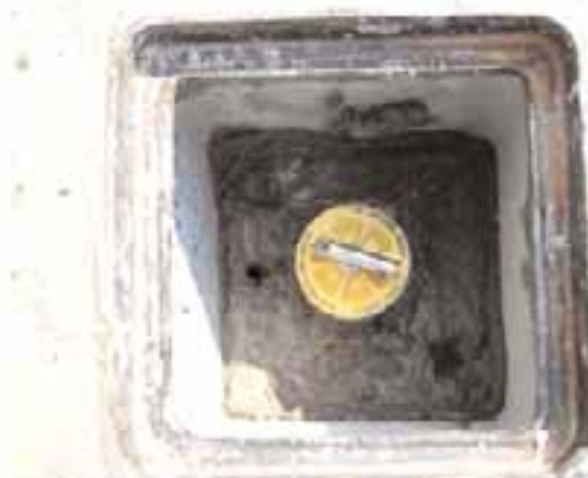
Figura 3.17 (a sinistra) - Testa pozzo racchiusa in chiusino carrabile e dotata di tappo lucchettabile a chiusura ermetica
