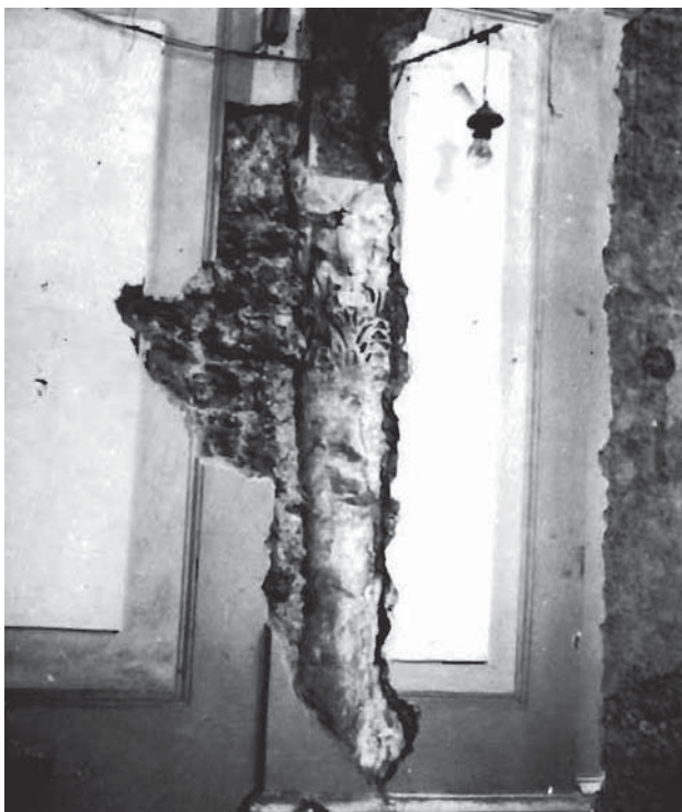
Fig. 7 - Colonna di un tempio di età romana inglobata nelle mura della chiesa di S. Vito (da: Liguori Rossi A., 1990).
