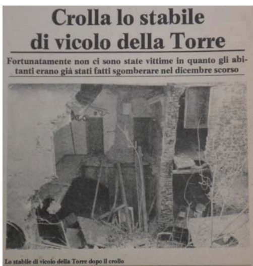
Fig. 6 - Articolo tratto dal settimanale "La Torre" di Velletri (RM) del 19 marzo 1983. Nella foto si osserva parte dell'edificio crollato e la grotta sottostante il fabbricato stesso.
