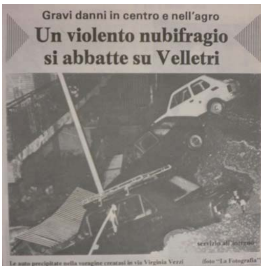
Fig. 7 - Articolo tratto dal settimanale "La Torre" di Velletri (RM) del 02 luglio 1983. Nella foto si notano auto precipitate nella voragine apertasi.
