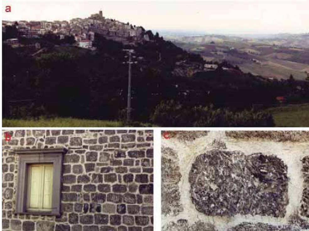
Fig. 5 - a) Vista dell'abitato di Gissi; b) uso edilizio dei gessi; c) particolare del materiale litoide.
