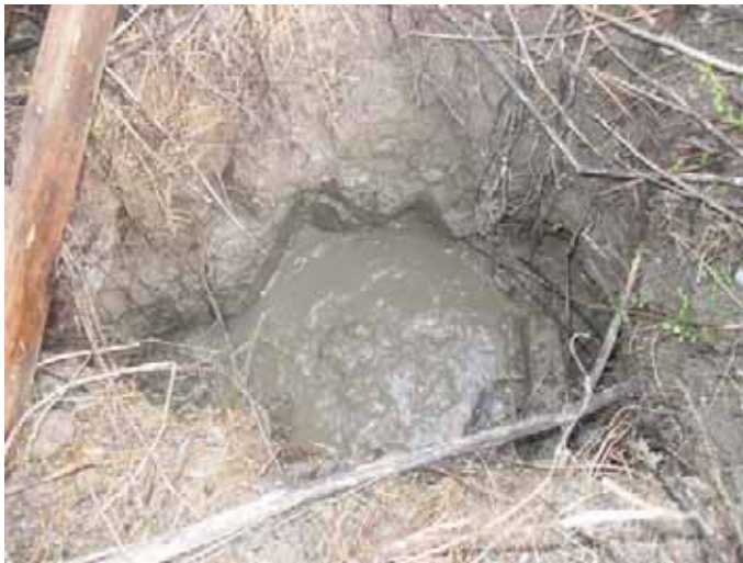
Fig. 7 - Sinkhole recente (aprile 2009) che presenta abbondante fase gassosa libera (gas vent) situato lungo la Strada 38 presso il terzo gruppo di case dall'incrocio con il Canale di Drenaggio.
