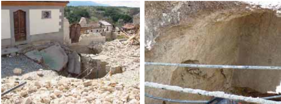
Fig.10 - a e b: Castelnuovo. Sprofondamenti verificatisi a seguito del terremoto del 6.4.2009.
