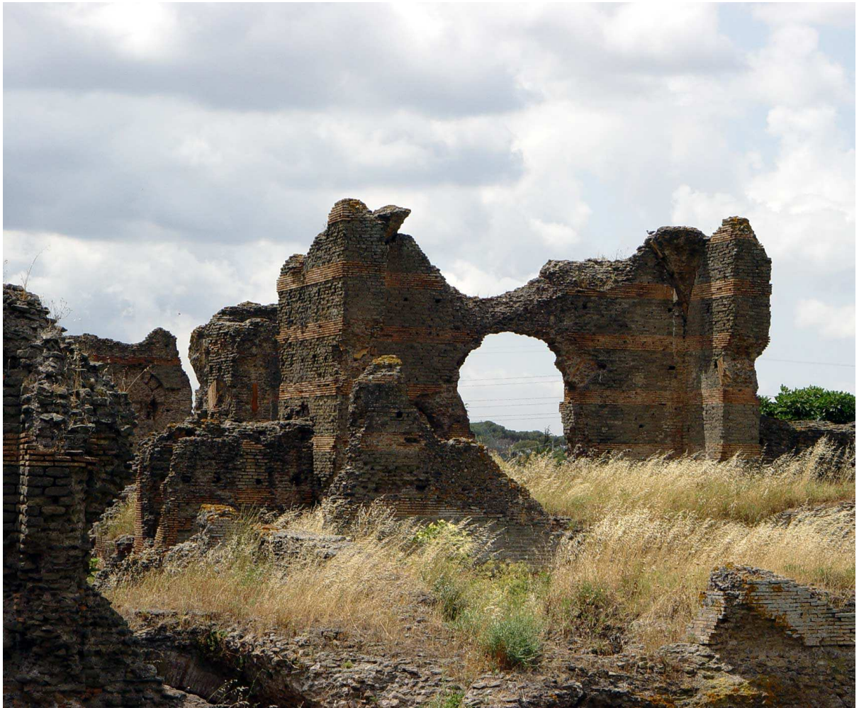
Villa dei Sette Bassi in opera listata, presso l'omonimo acquedotto al parco degli Acquedotto
