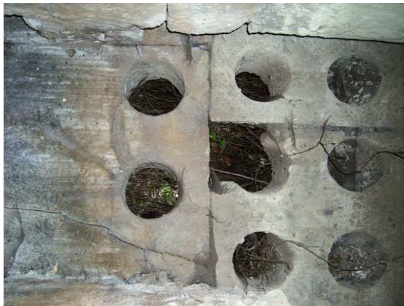
Ciò che rimane delle antiche paratoie per regolare il flusso delle acque
