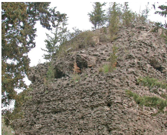
Nucleo in opera cementizia di una tomba sulla via Appia antica a Roma
