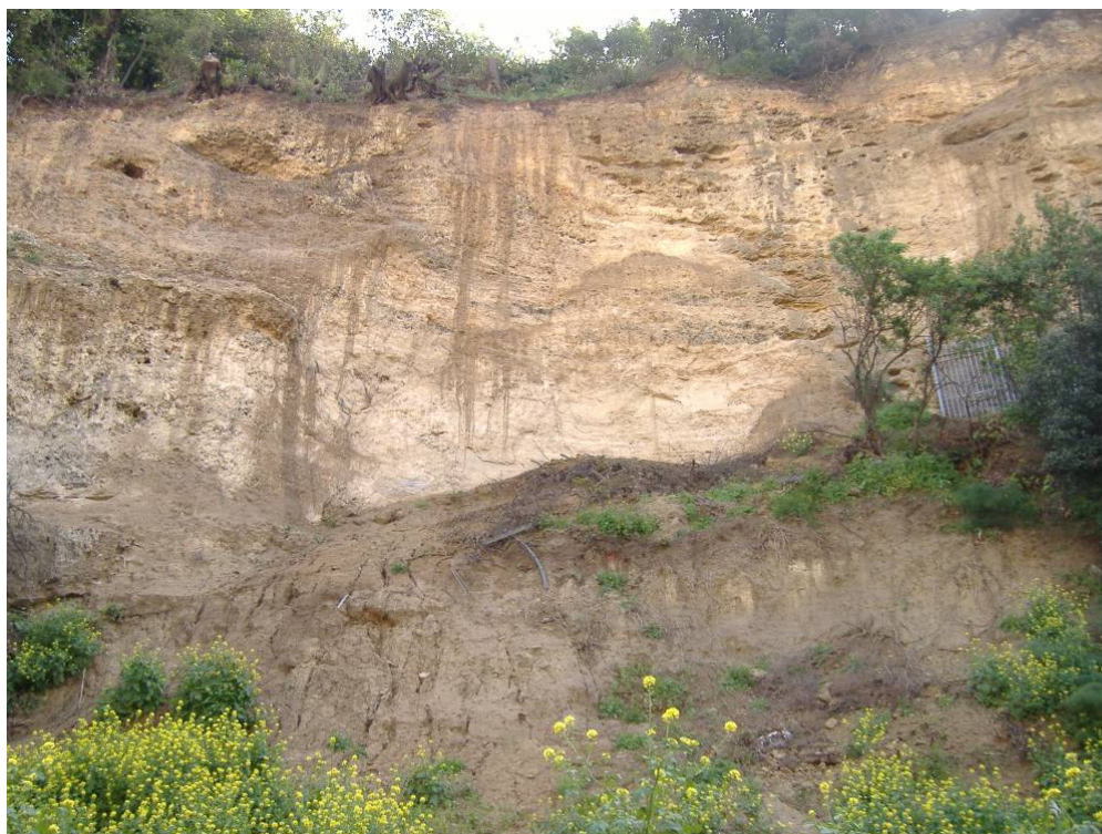
Fig. 5 – Versante della frana sottostante Villa Balestra, dopo i lavori di disgaggio e sistemazione del versante.
