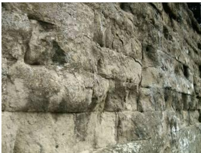
Figura 29: Impiego della tecnica dell' opus quadratum nell'alto muro che fiancheggia la Via del Sole
