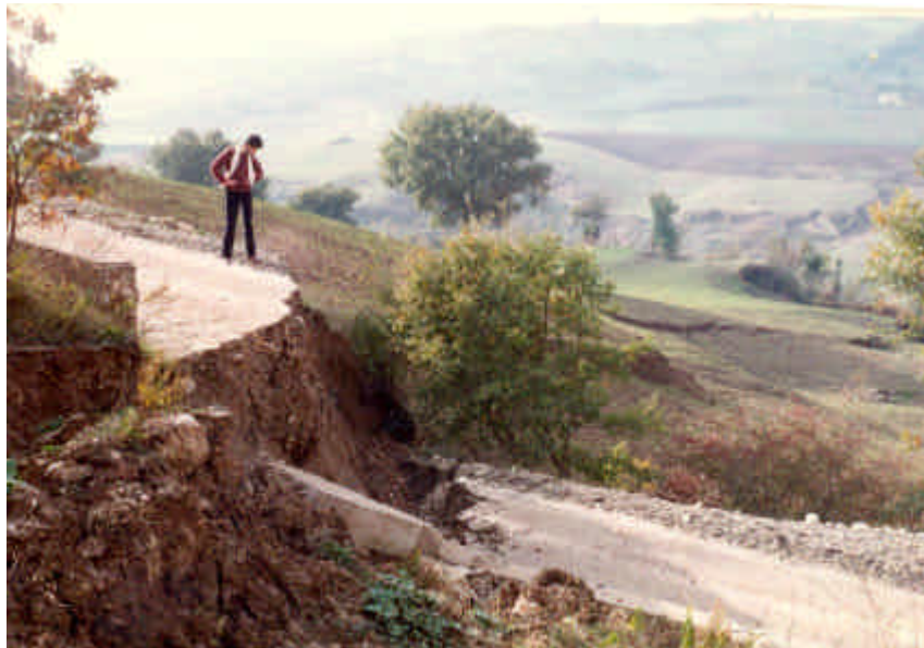
November 23, 1980 Irpinia-Basilicata, Italy earthquake ( M_s = 6.9 ). S. Giorgio La Molara: coseismic reactivation of a landslide. S. Giorgio La Molara: riattivazione cosismica di una frana. Source: Ufficio Tecnico Comune San Giorgio La Molara
