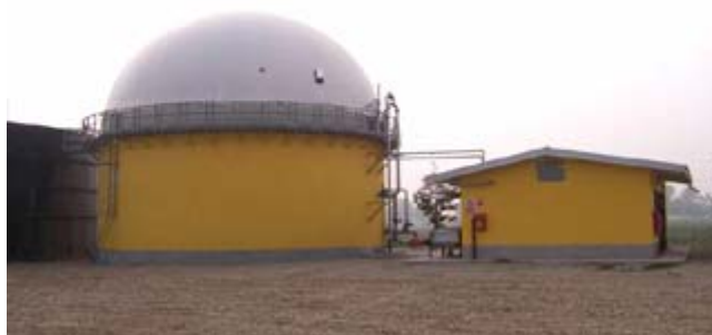
Figura 7. Cupola Gasometrica
