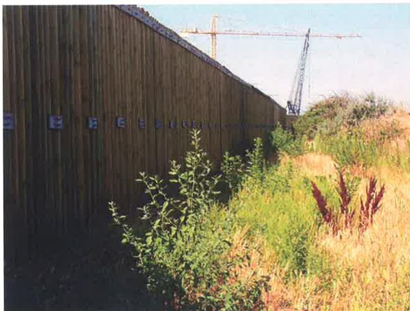
*Figura 5: Barriera fonoassorbente dell'area di cantiere di Ca' Roman vista dall'esterno.*
