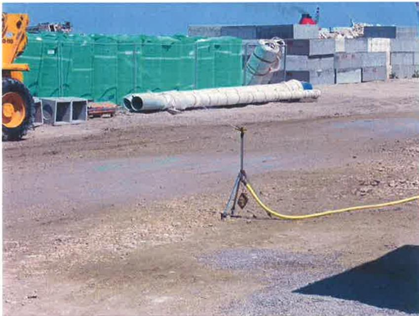
*Figura 13: Pompa da irrigazione utilizzata per la bagnatura delle superfici sterrate dei cantieri a San Nicolò.*
