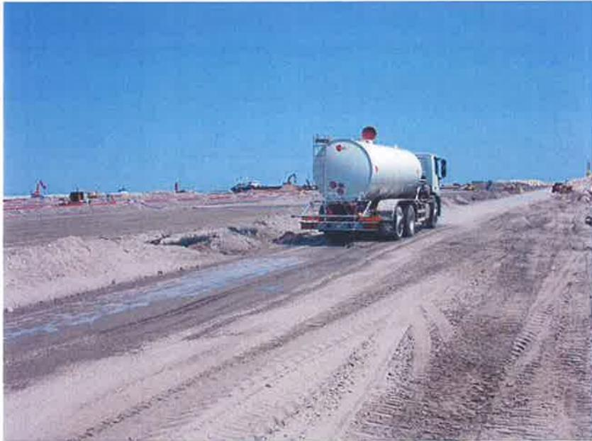
*Figura 12: Bagnatura tramite autocisterna con sistema innaffiante posto sul retro a Malamocco.*
