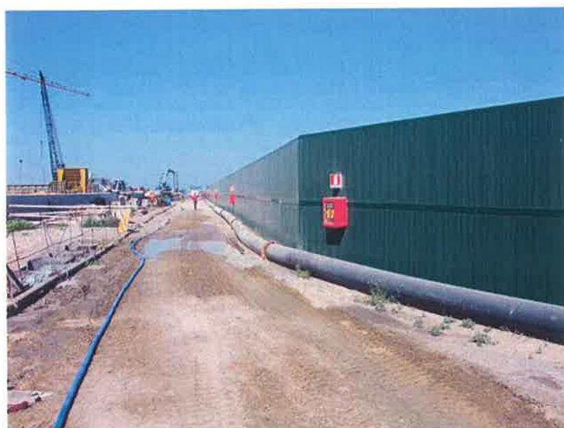
*Figura 6: Barriera fonoassorbente costituita da pannelli modulari, vista dall'interno del cantiere.*
