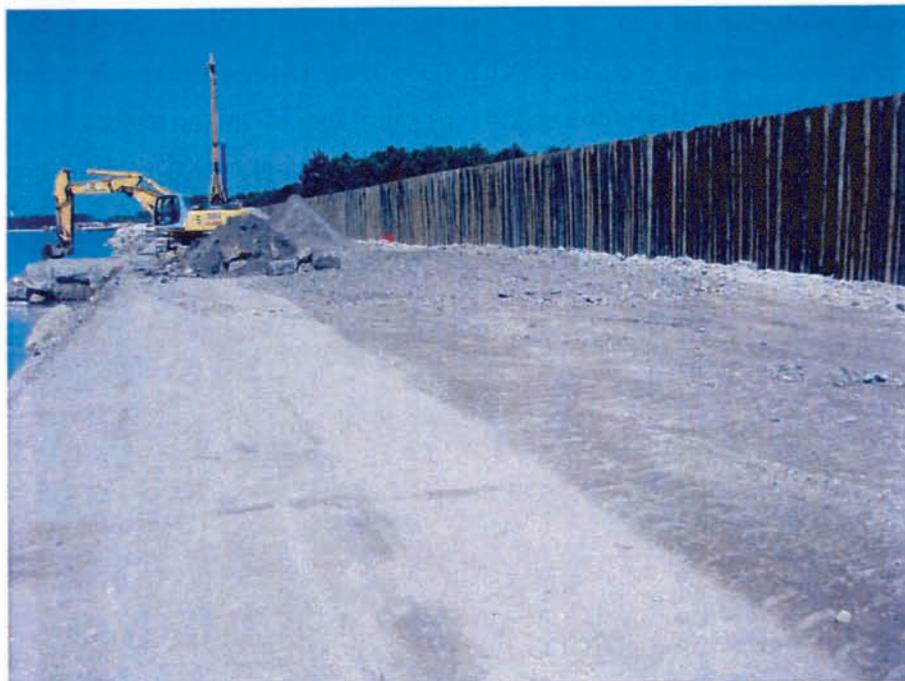
*Figura 4: Barriera in palificata lignea presso il cantiere di Alberoni.*
