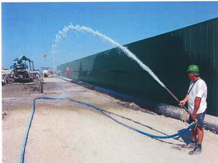
*Figura 11: Sistema di bagnatura manuale presso il cantiere di Ca' Roman.*
