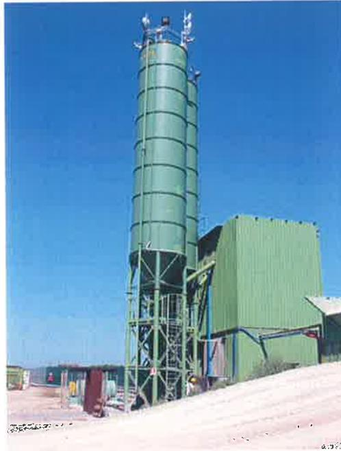
*Figura 7: Impianto di betonaggio rivestito di lamiera grecata con all'interno pannelli coibentati.*
