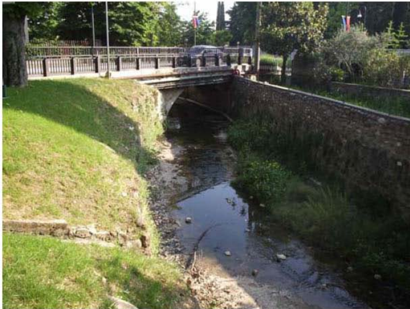
Ponte della Chiesa visto da monte
