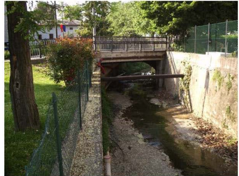
Ponte della Chiesa visto da valle
