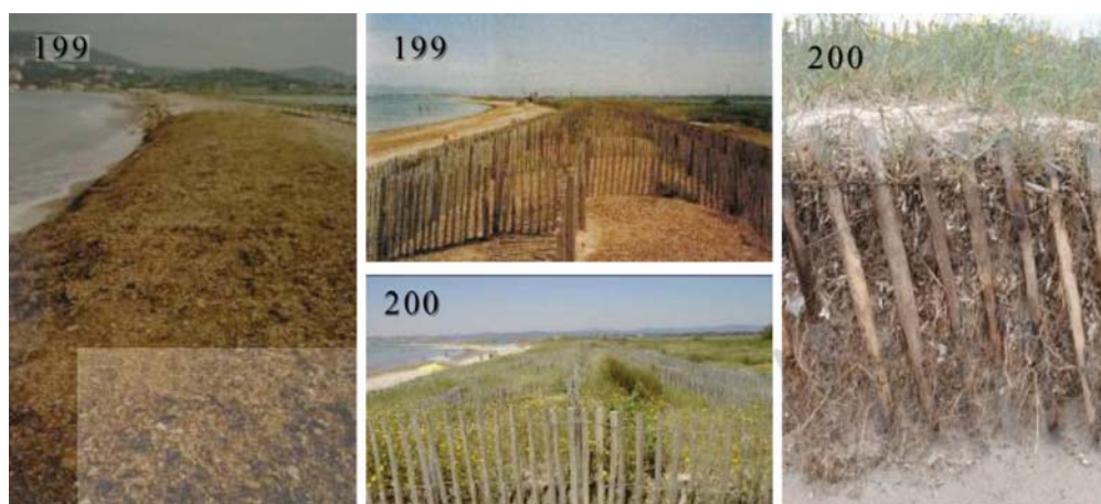
Figura 3.2.1 – Esempio di ricostruzione di una duna mediante l'utilizzo di resti di Posidonia oceanica e l'impianto di vegetazione (Tombolo de Giens, France) (Foto: E. Pallottini).
