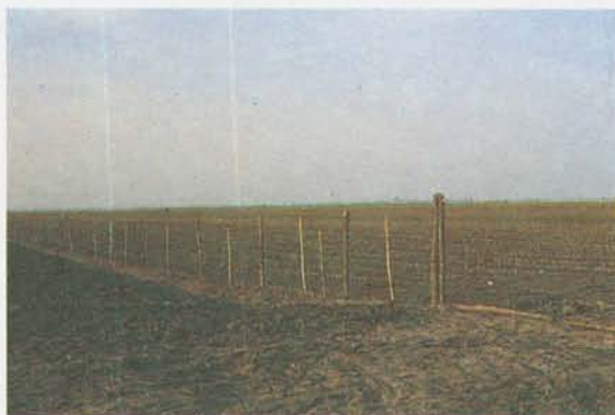
Recinzione totale di un vivaio per mezzo di rete metallica leggera.
