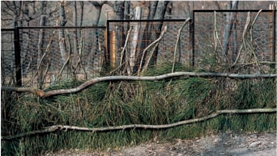
Fig. 11 - Rivestimento del chiusino con fascine di ginestra.
