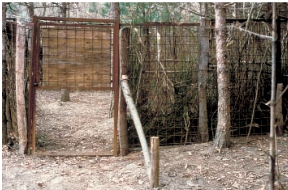
Fig. 5 - Ancoraggio dei pannelli agli alberi circostanti.
