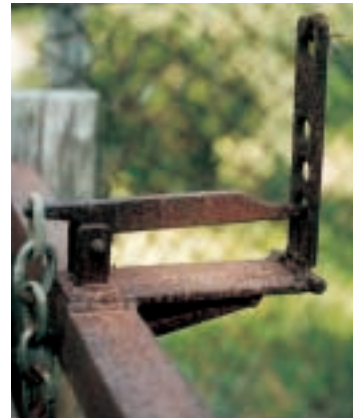
Fig. 8 - Meccanismo di sgancio della porta.
