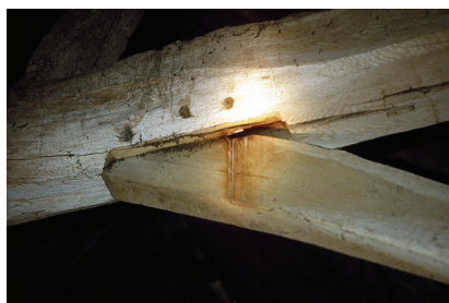
Figura 2.7 - Particolari delle congiunzioni di due travi in legno in un fienile col sistema tenone-mortasa, che forma una piccola cavità adatta al rifugio di chiroterri (da Briggs, 2004).
