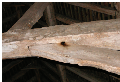
Figura 2.7 - Particolari delle congiunzioni di due travi in legno in un fienile col sistema tenone-mortasa, che forma una piccola cavità adatta al rifugio di chiroterri (da Briggs, 2004).
