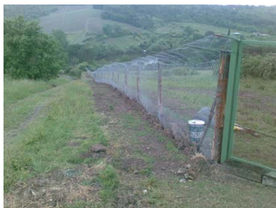
Figura 2.2.5.2: Recinzione esterna adatta a diversi tipi di allevamento.
