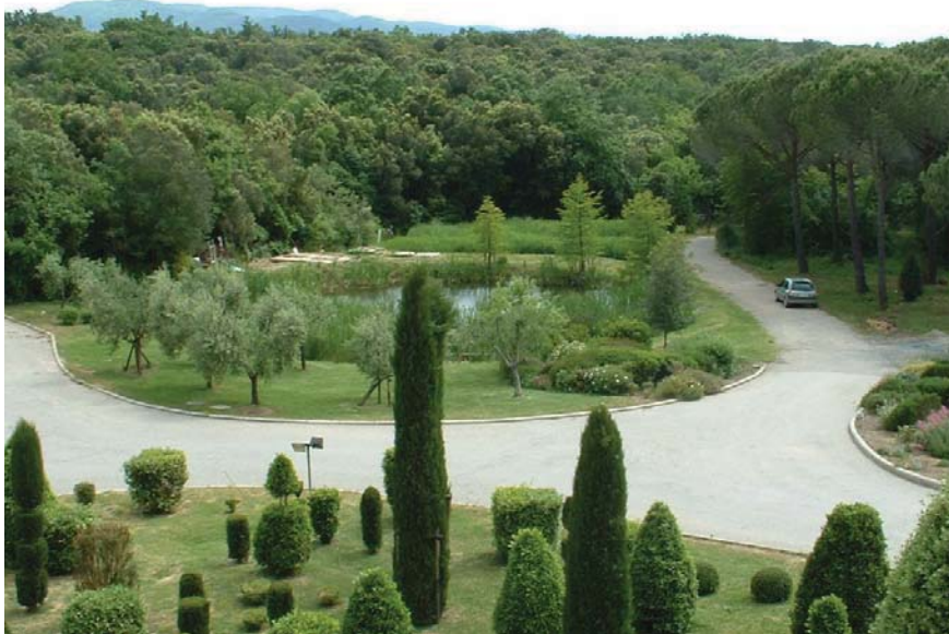
Figura 2.4.5.2 Impianto di fitodepurazione al servizio della Cantina Ornellaia, Bolgheri (design by IRIDRA Srl)
