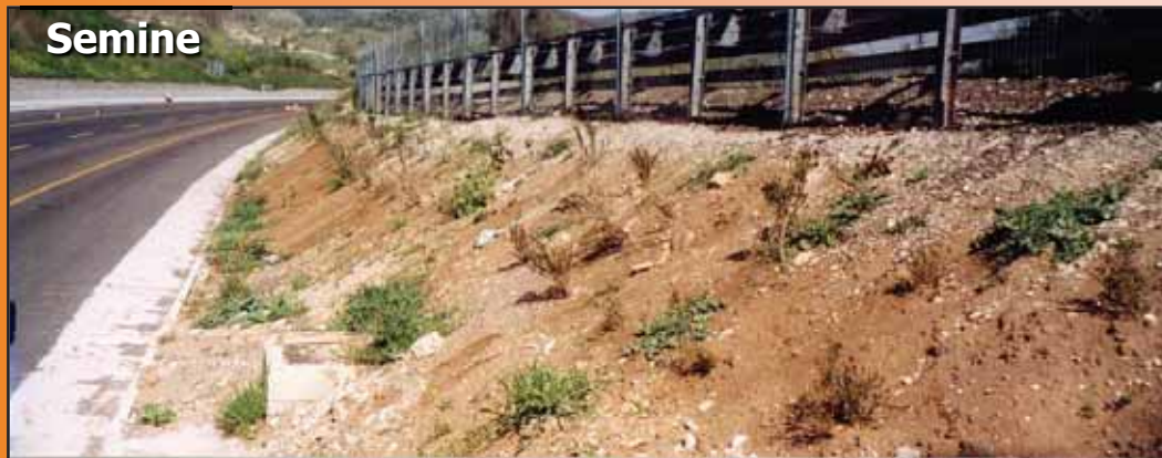
Foto 15 – Evidente carenza di suolo organico premessa negativa sia per le semine che per la crescita di arbusti. (3° corsia Fiano – Orte)
