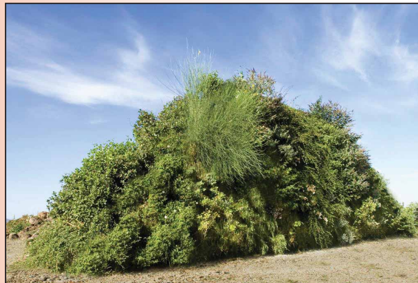
Foto 78 – Barriera antirumore vegetata ad arbusti in terrapieno compresso in struttura metallica. Campione di recente realizzazione con cura particolare per il suolo di riempimento (suolo tecnogenico) ed evidente successo dello sviluppo della vegetazione
