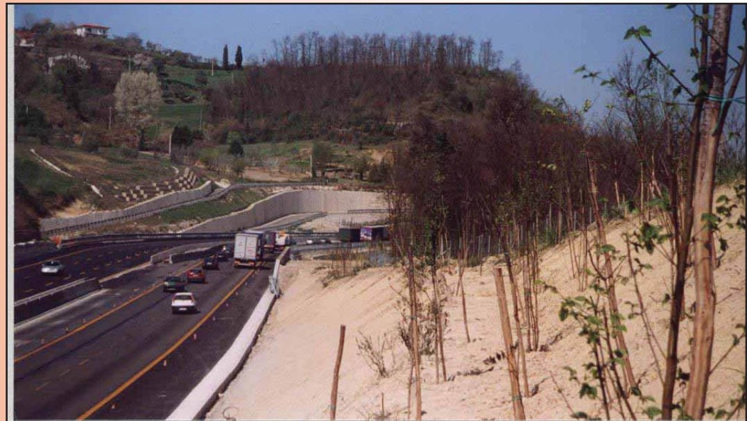
Foto 24 - Autostrada Fiano –Orte – Scarpate in trincea in argilla minerale – Piantagione di arbusti ed alberi
