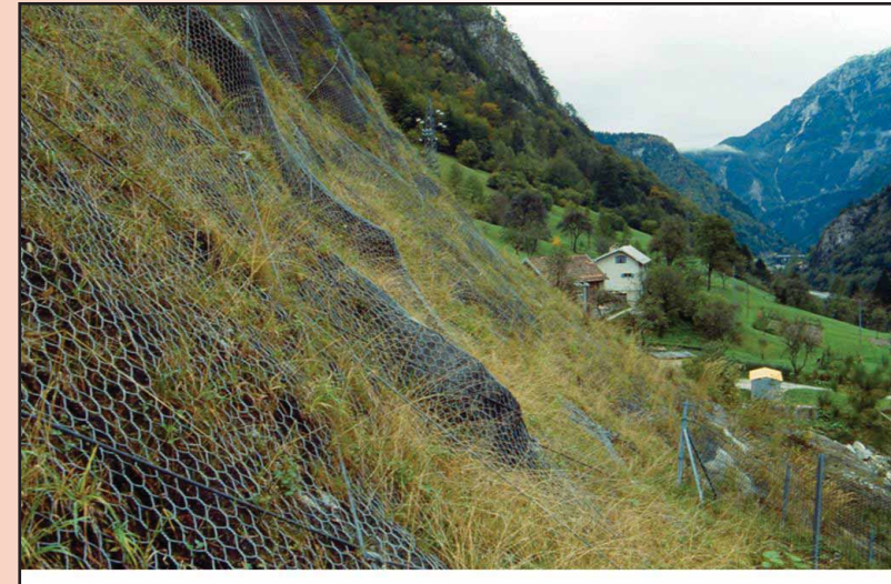
Foto 48 - Rivestimento vegetativo in geostuoia tridimensionale e rete zincata inerbita su scarpate in scavo in litologia sciolta su detrito di falda (Autostrada Carnia -Tarvisio – Foto G. Sauli ottobre 1987)
