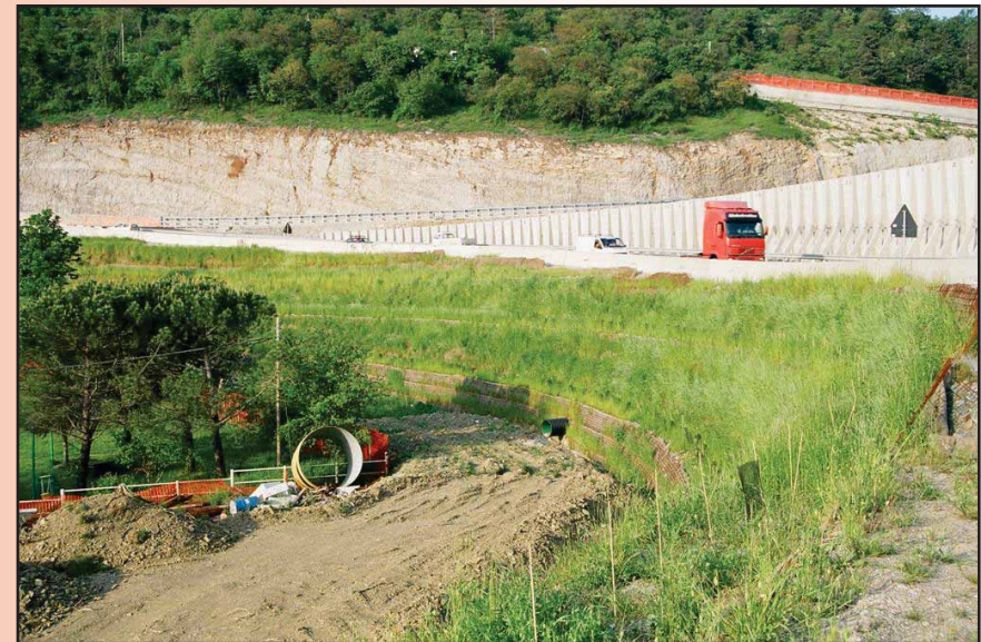
Foto 14 - Esempio di prerinverdimento: costruzione e rinverdimento di terre rinforzate verdi (GVT – curva di Cattinara TS)
