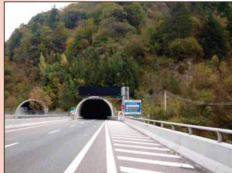
(Autostrada A 23 galleria di Pontebba) novembre 2010
