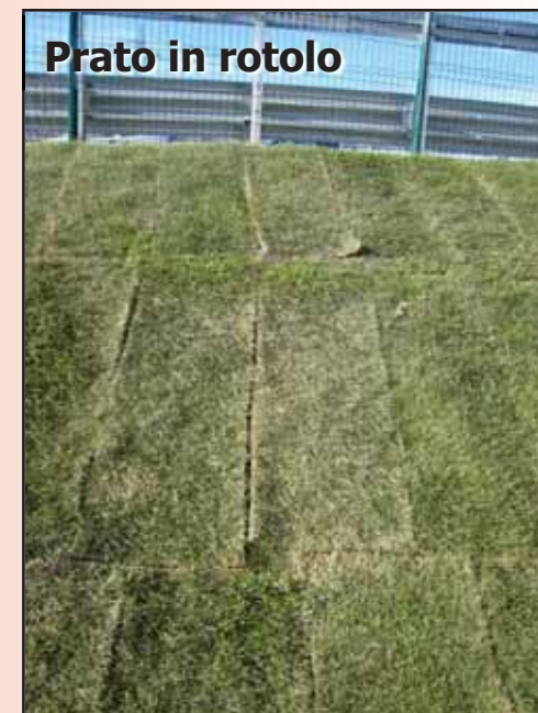
Foto 14 - Esempio di prerinverdimento: costruzione e rinverdimento di terre rinforzate verdi (GVT – curva di Cattinara TS)
