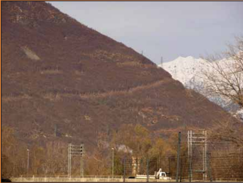
Taglio raso sotto le linee per possibili interferenze dei rami con i conduttori
