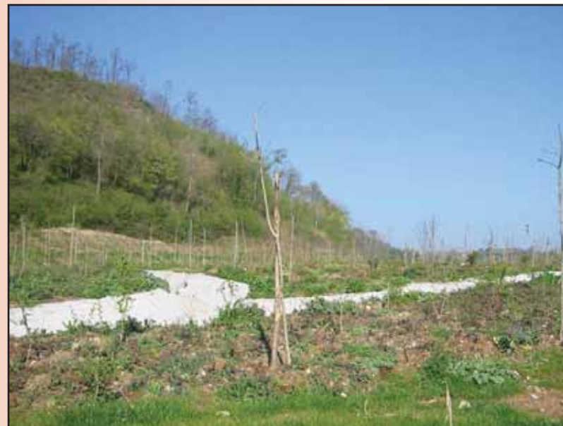
Foto 34 - Rivegetazione area boscata rilevato galleria Pileggi (3a corsia Autostrada Orte-Fiano fine anni '90). Visibile un fosso di guardia realizzato in cls
