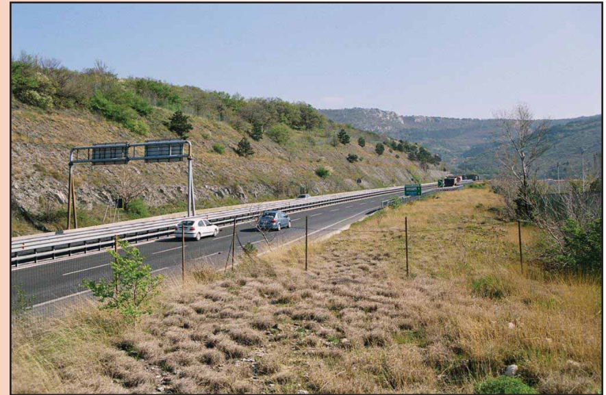
Foto 46 - Scarpate in rocce marnoso-arenacee rivestite con sola rete metallica. Lo sviluppo spontaneo della vegetazione è legato alla presenza di piccole berme su cui si è accumulato materiale terroso fine. (GVT svincolo Grandi motori – TS)
