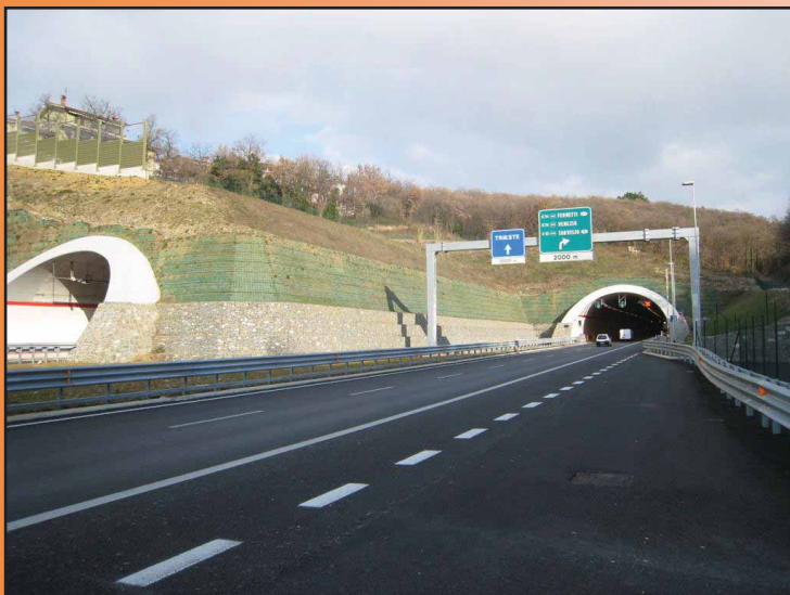
Foto 51 - L'uso di feltri sintetici come antierosivo nelle TRV non consente la crescita del cotico erboso (Galleria Rabuiese GVT-TS)
