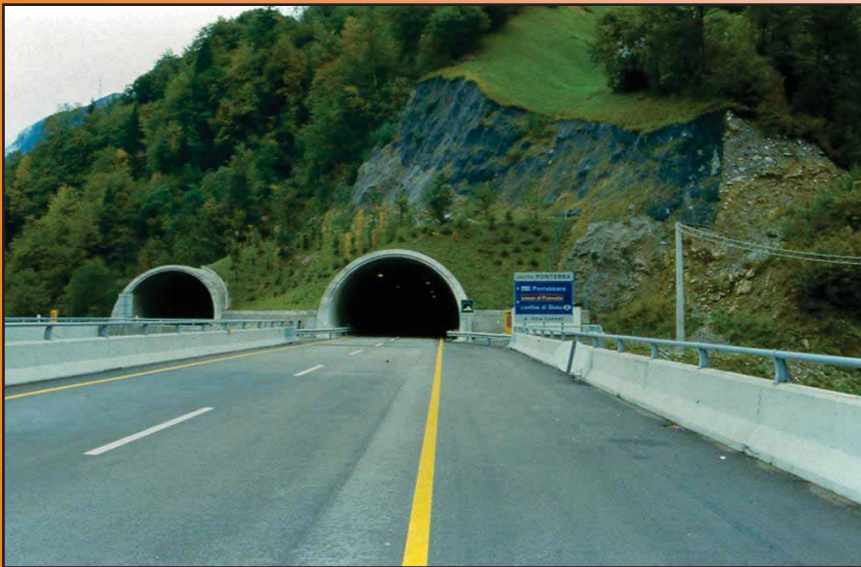
Foto 7 - Prolungamenti in galleria artificiale con rilevati rivegetati ad alberi locali (Autostrada A 23 galleria di Pontebba)
