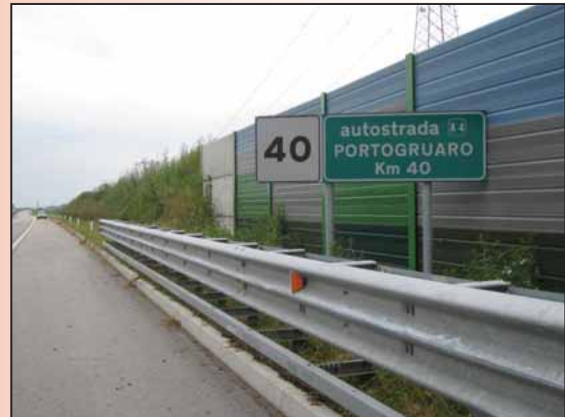
Foto 70 – Terrapieno vegetato antirumore (Autostrada A28 - 2010)
