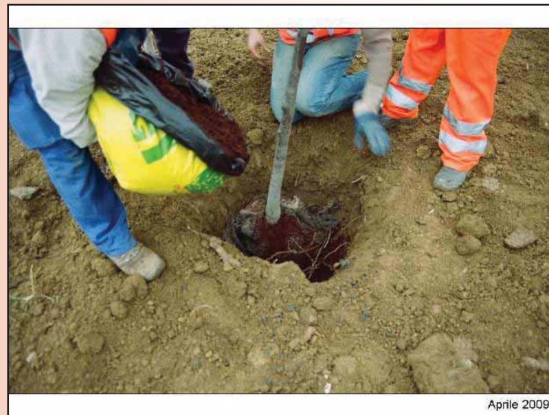
Foto 18 – Messa a dimora di albero in zolla con rincalzo di torba e terreno vegetale
