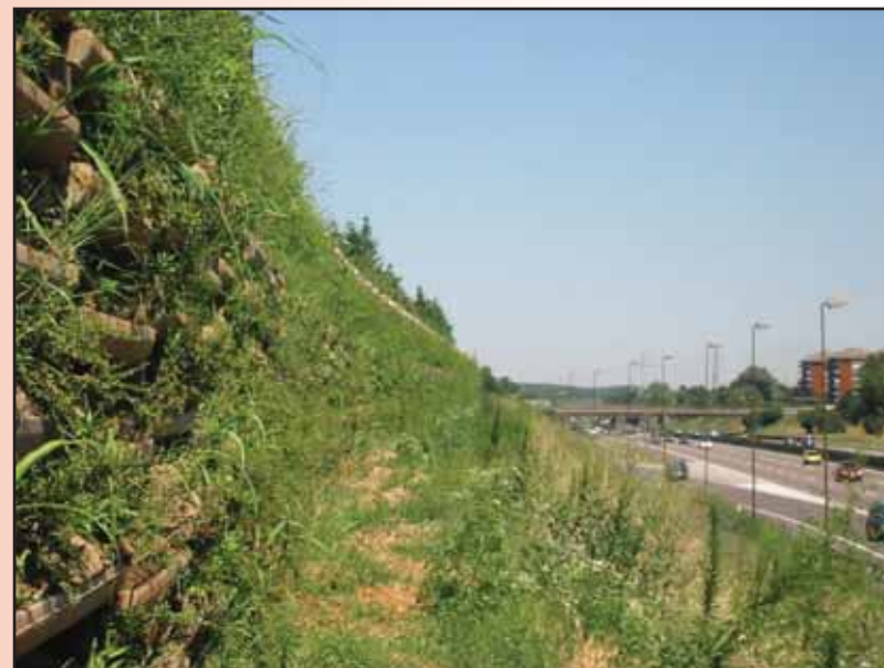
Foto 76 - Barriera antirumore in cls vegetata (Tangenziale di Torino)
