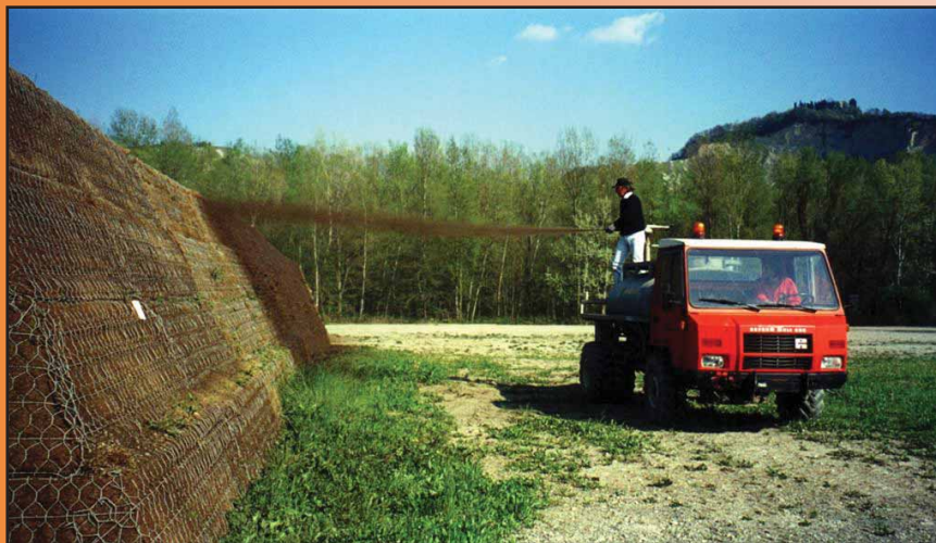
Foto 83 – idem idrosemina a spessore
