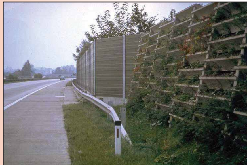
Foto 74 – Barriera antirumore in terrapieno compresso in cls vegetata (Austria anni '80).
