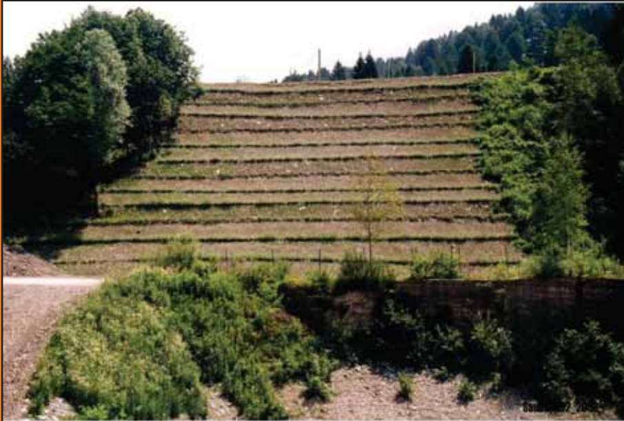
Metanodotto Malborghetto-Bordano giugno 2003 Gradonate vive, canaletta con graticciata
