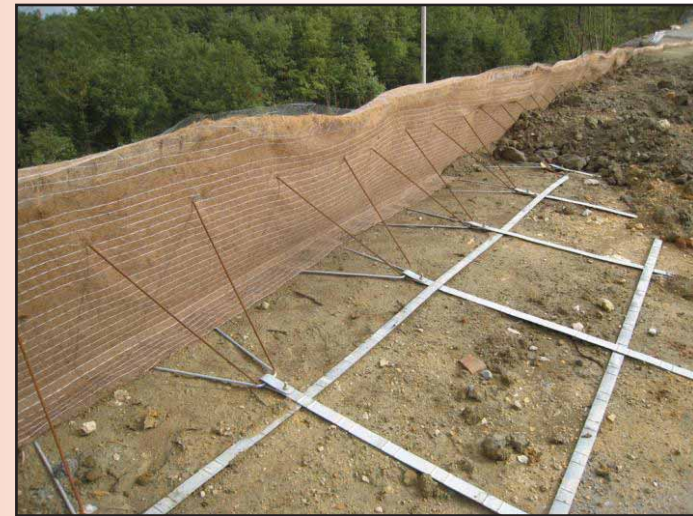
Foto 52 - TRV con rinforzi orizzontali in armature metalliche e stuoie in cocco come antiersivo. Si noti la terra vegetale appressata alle stuoie e reti esterne. (SP 73 Siena, 2009)
