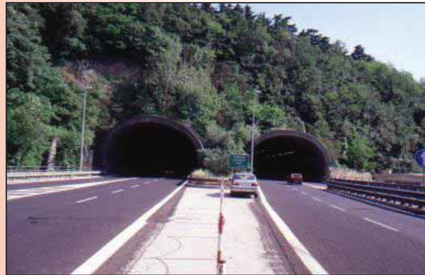
Foto 12 - GVT Galleria di Servola (TS) – dopo 10 anni
