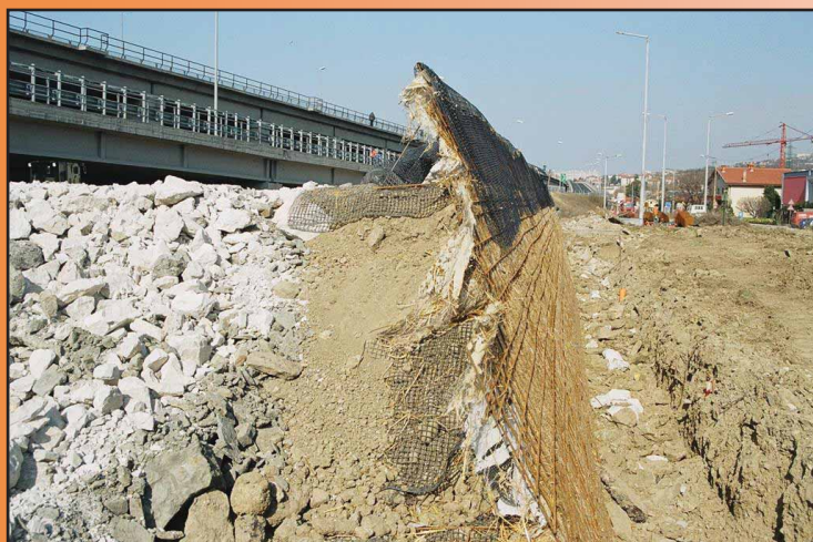
Foto 55 - TRV con armatura orizzontale in reti sintetiche e casseri esterni in griglie metalliche, reti sintetiche e stuoie organiche. Si noti la terra vegetale addossata alle stuoie e reti esterne (GVT loc. Domio, 2008)
