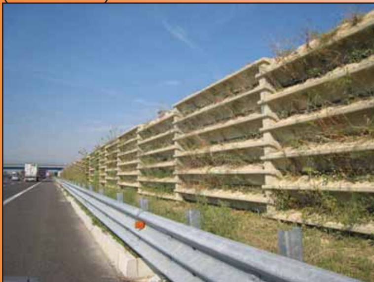
Foto 75 - Barriera antirumore in terrapieno compresso in cls vegetata (Passante di Mestre).
