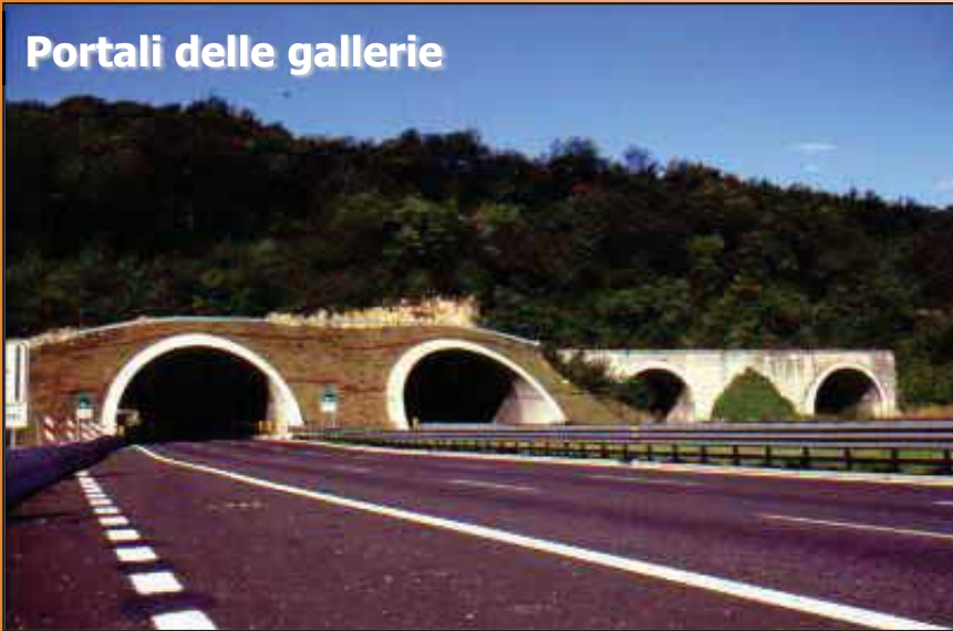
Foto 5 - a destra vecchio portale in cls, a sin nuova tipologia rivegetabile con semine e vimate
