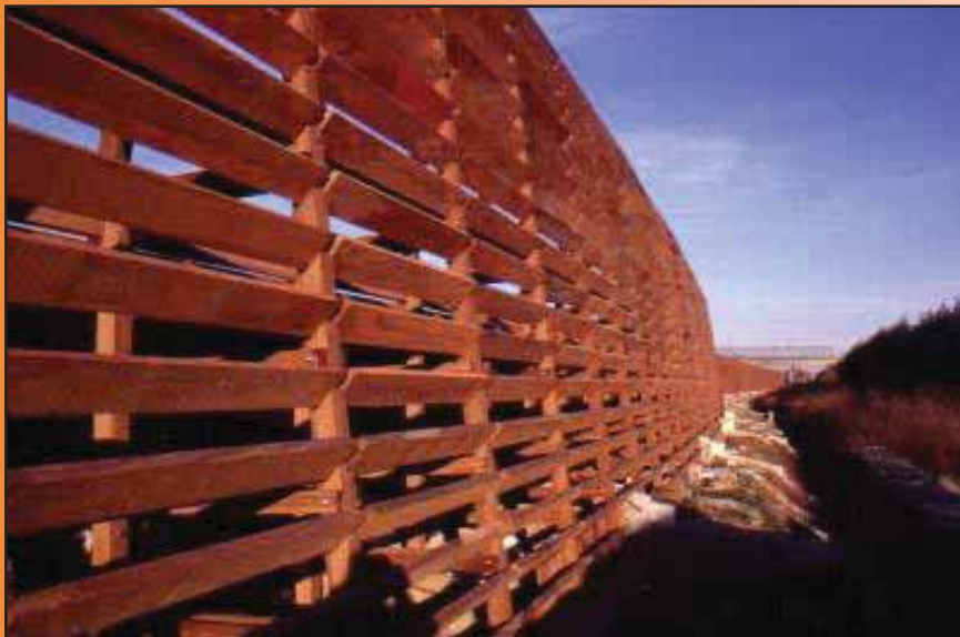
Foto 73 – Barriera antirumore in legno in costruzione (Autobrennero).
