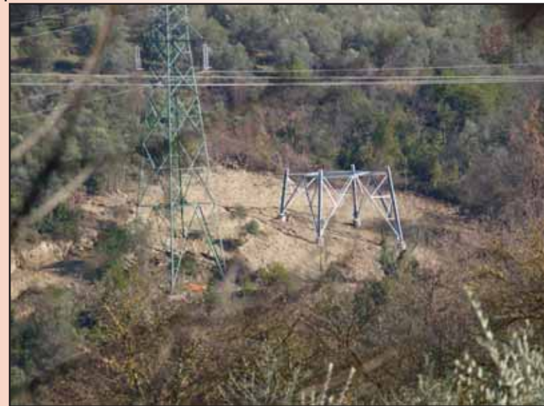
Demolizione e nuova costruzione
