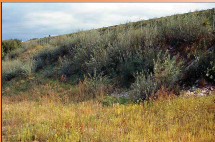
Foto 22 - Piantazione di arbusti autoctoni e talee di salici arbustivi pionieri ( Salix elaeagnos , S. purpurea ) a gradonata su rilevato autostradale su ghiaie calcaree da scavi privo di suolo vegetale Carso triestino Loc. Aurisina
