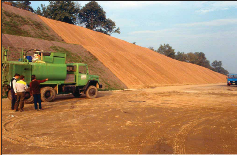
Autostrada dei trafori - ottobre 1988 Stuoia in cocco
