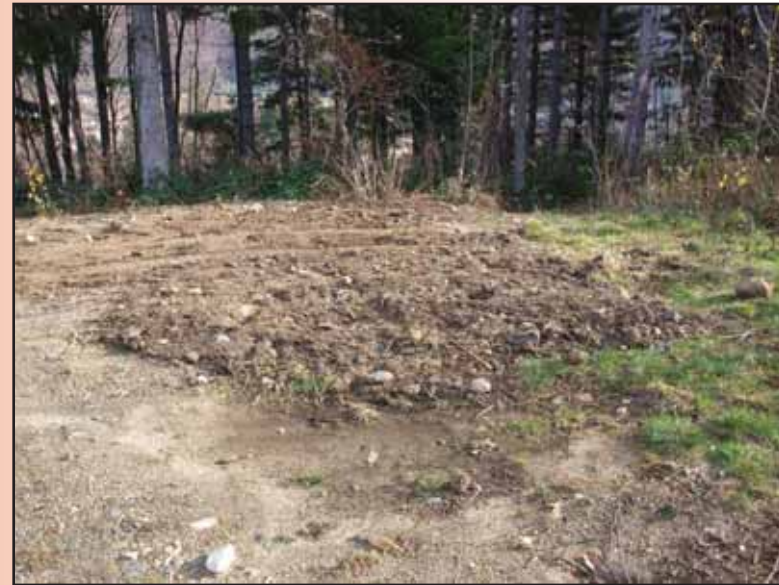
Base traliccio demolito-ricomposizione suolo
