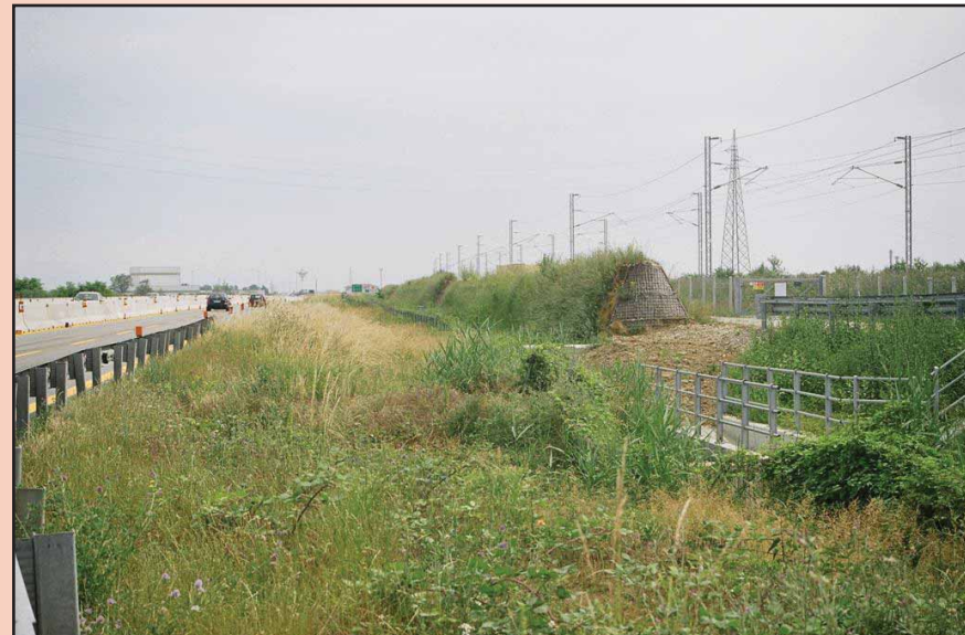
Foto 84 – idem a lavoro e rinverdimento ultimato. Separazione tra Autostrada ed AV TO – NO
