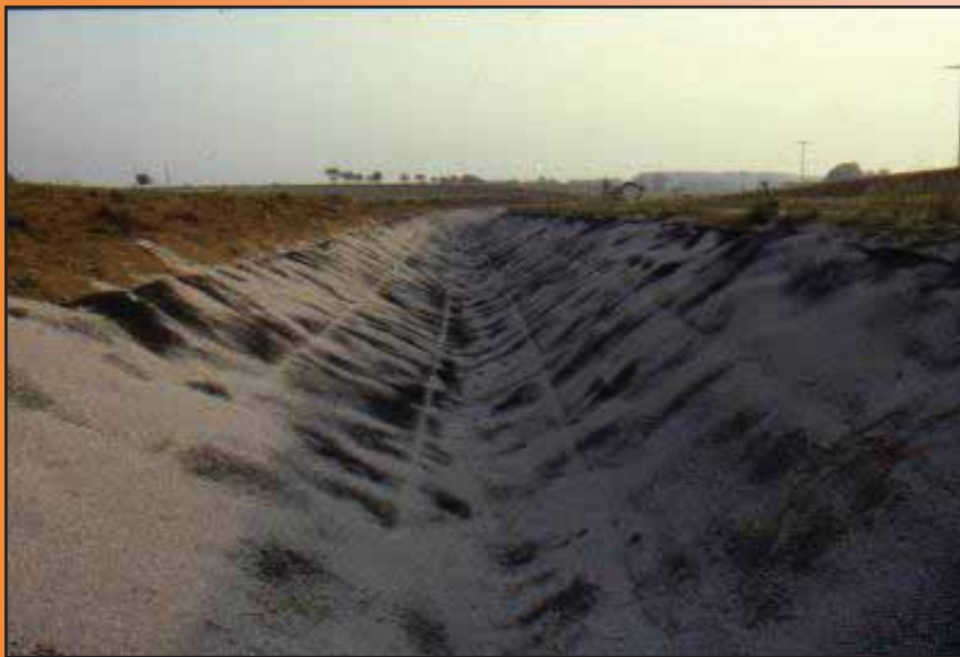
Foto 31- Canale autostradale in geostuoia tridimensionale sintetica seminata, intasata di ghiaino e bitumata in loco. Oltre che funzioni di scorrimento tali strutture verdi assolvono anche funzioni di infiltrazione con effetti benefici di filtrazione del particolato e ripascimento delle falde
