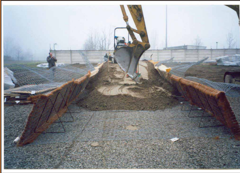
Foto 81 – Barriera antisvio in doppia terra rinforzata verde in fase di costruzione
