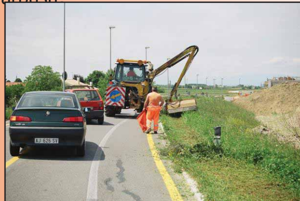
idem manutenzioni con barra rotante
