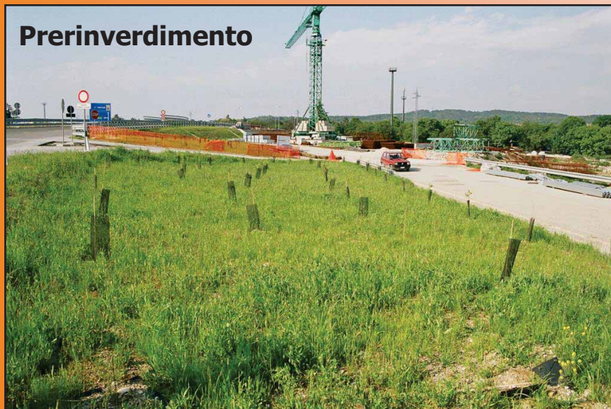
Foto 13 - Esempio di prerinverdimento di scarpate stradali si notino le reticelle antifauna a protezione degli arbusti (GVT Loc. Padriciano TS)
