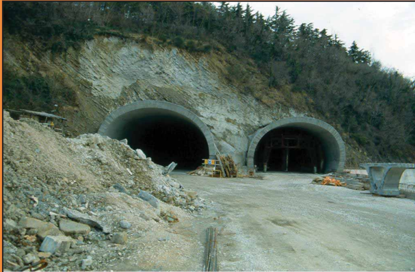
Galleria via Svevo (Ts) - 28/03/86
