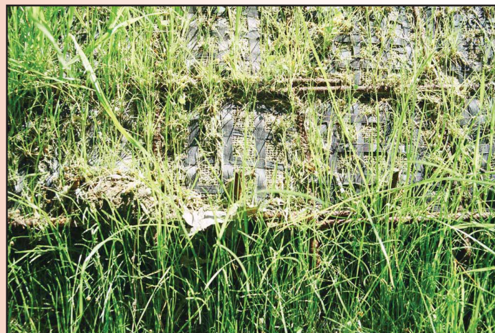
Foto 56 - Messa a dimora di talee di salice su TRV con griglie metalliche, reti sintetiche e stuoie nella sequenza dall'esterno verso l'interno (GVT - Foto G. Sauli 2009)
