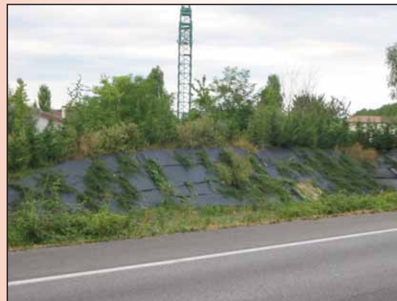
Foto 20 – Impiego di teli pacciamanti a protezione di specie arbustive
