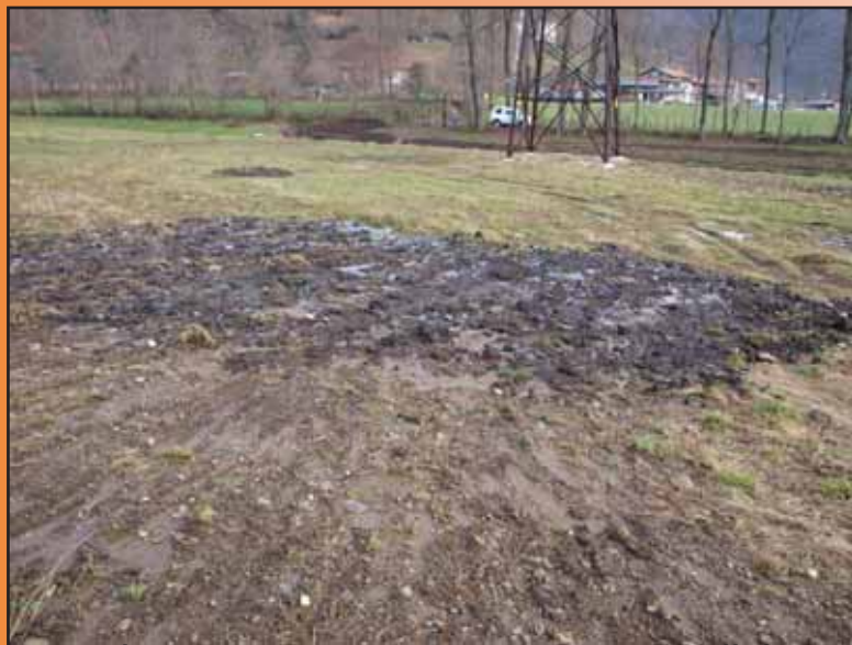
Demolizioni e nuove costruzioni in parallelo, con ricomposizione del suolo
