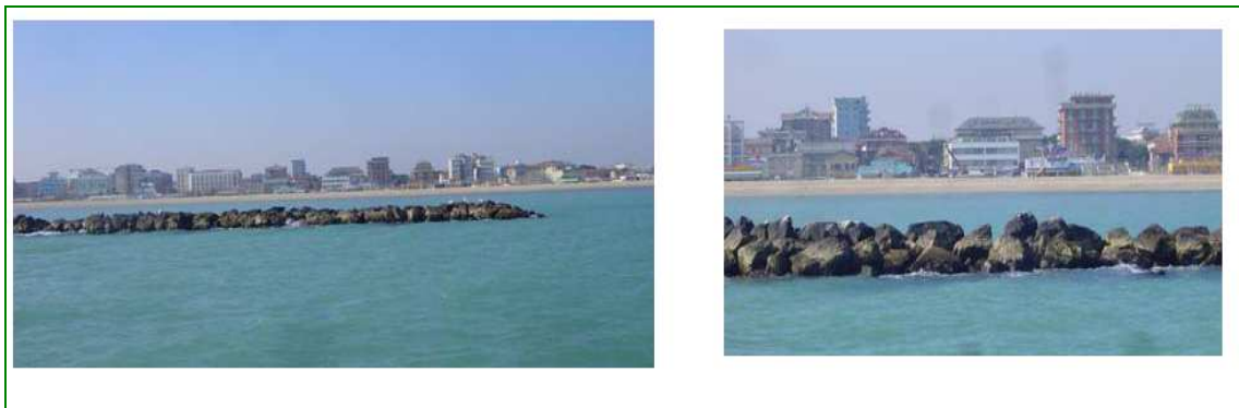
Figure 5.2 e 5.3 - Barriere frangiflutto presenti lungo la fascia costiera ove sono stati effettuati i campionamenti
