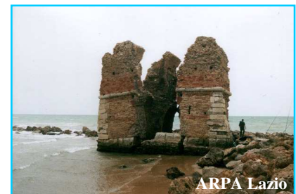
Figura 7.7 - Castel S. Gallo Nettuno
