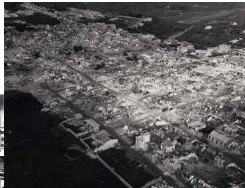
1968 Terremoto del Belice
