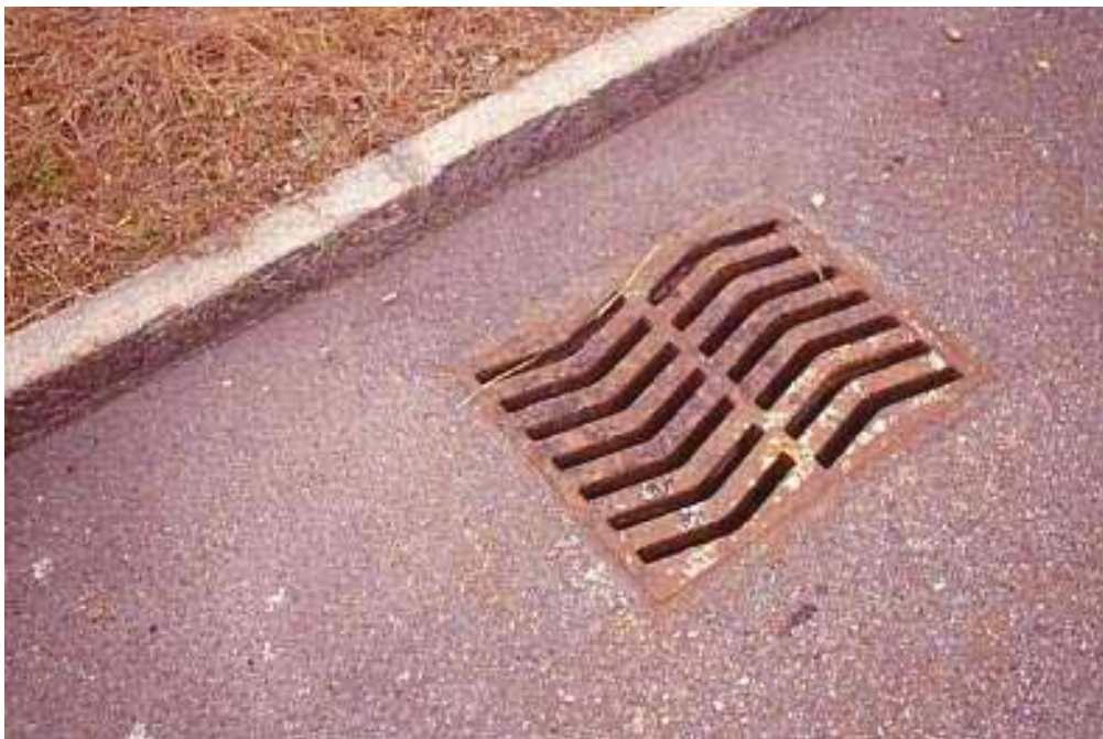
Foto di un chiusino arretrato rispetto al cordolo in modo tale che gli anfibi, muovendosi lungo il cordolo stesso, non lo intercettino (M. Dinetti)
