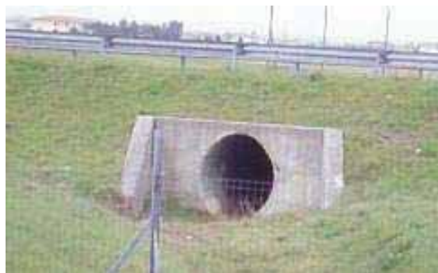
Foto di un tunnel di drenaggio delle acque che può svolgere anche funzione di attraversamento faunistico (M. Dinetti)
