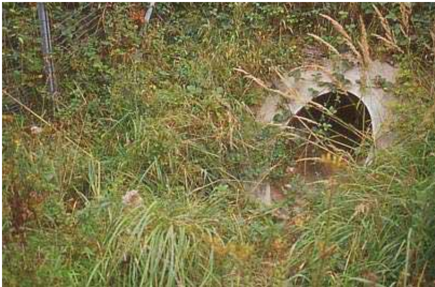
Foto di un tunnel per Anfibi (M. Dinetti)
