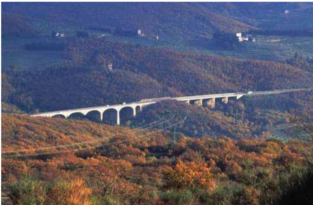
Viadotto dell'Autostrada del Sole A1 in località Calenzano (FI) (M. Bacci).
