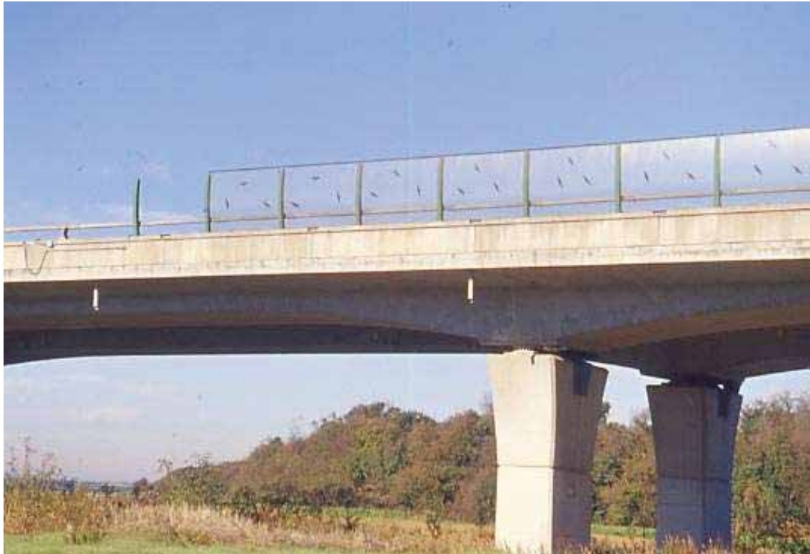
Foto di pannelli fonoassorbenti trasparenti dotati di sagome anticollisione volatili (M. Dinetti)
