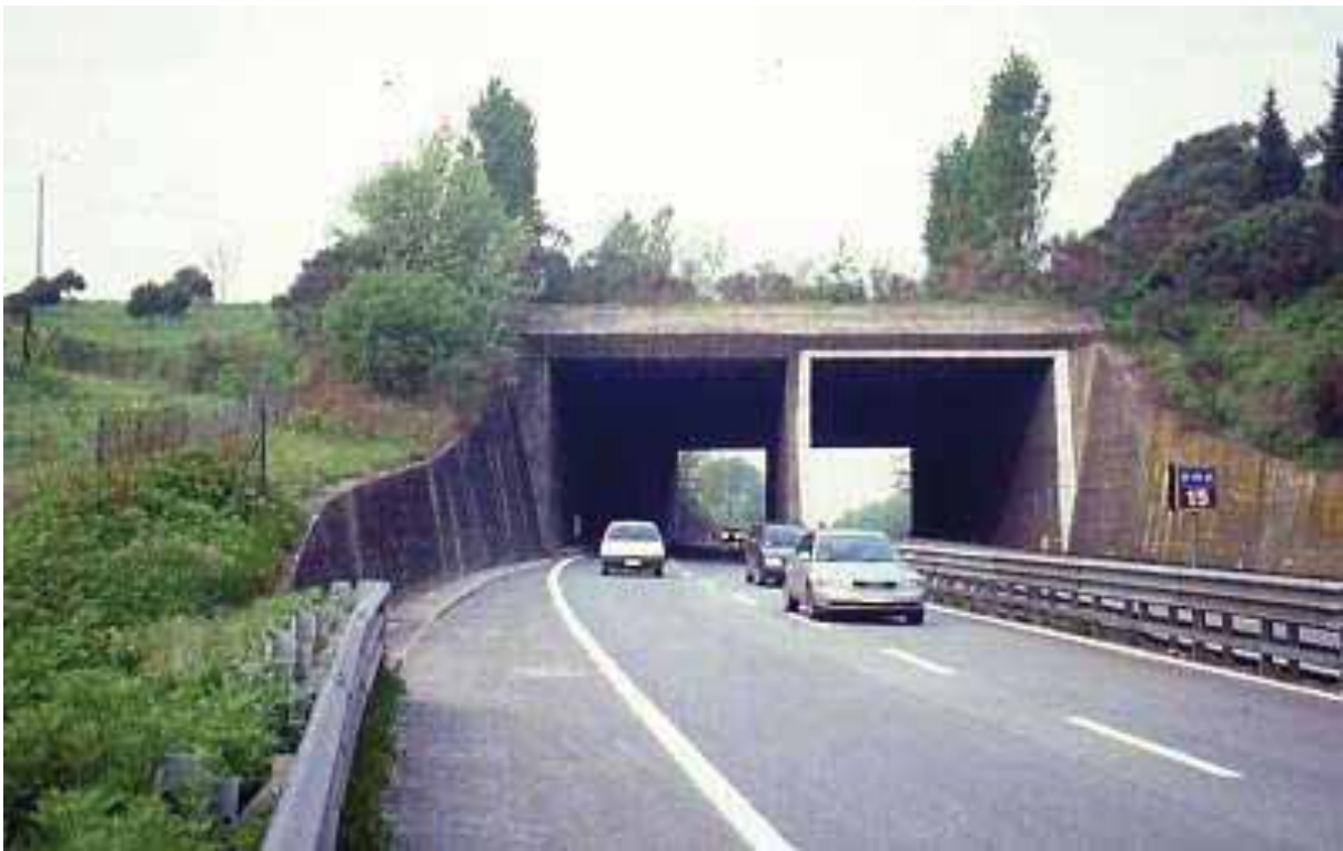
Foto di un ponte faunistico sulla Strada di Grande Comunicazione FI-PI-LI (M. Dinetti)
