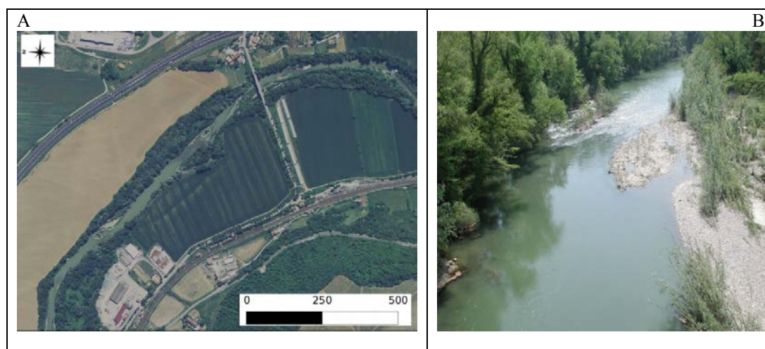
Figura 5.7 – Fiume Tevere presso la confluenza con il F. Paglia ( IQM = 0.66 ; Classe = Moderato ). (A): Foto aerea di una porzione del tratto; (B): particolare del tratto.
