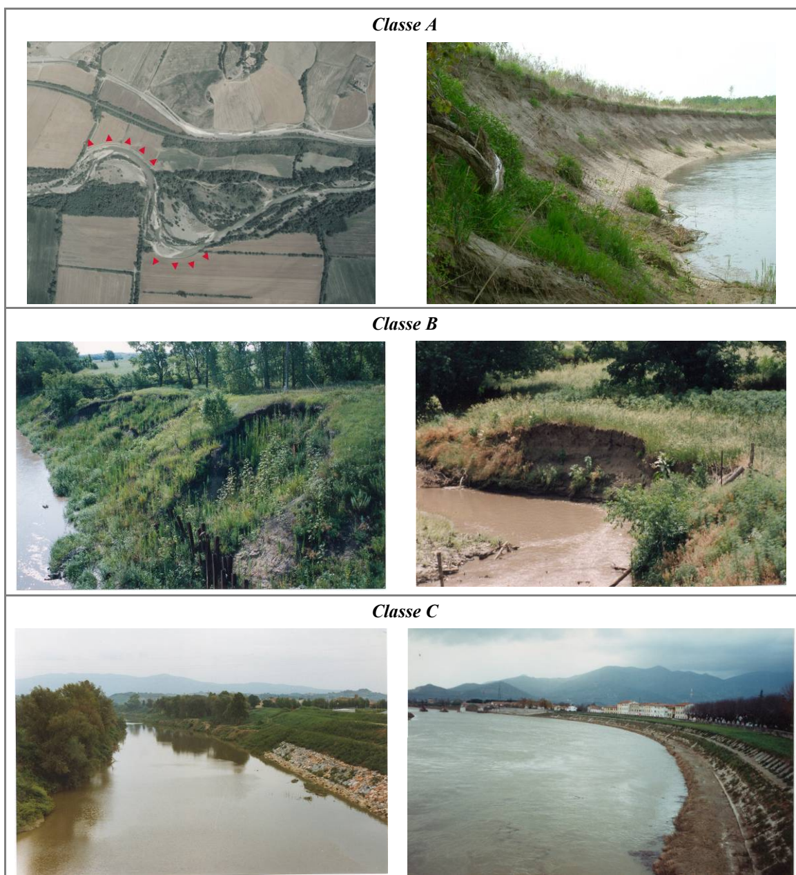
Figura 32 – Processi di arretramento delle sponde. Classe A : frequenti sponde in arretramento, soprattutto sul lato esterno delle curve ( frecce rosse nella foto a sinistra). Classe B : rientrano in questa classe i tratti con erosioni osservate solo localmente. Classe C : assenza di sponde in erosione per presenza di interventi di protezione e/o dinamica dell'alveo assente.
