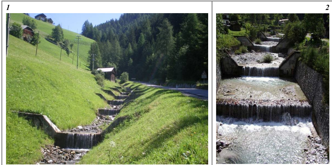
Figura 62 – Casi di densità elevata di opere trasversali (> 1 ogni 100 m per alvei in ambito montano) per i quali si applica una penalità aggiuntiva di 12.
