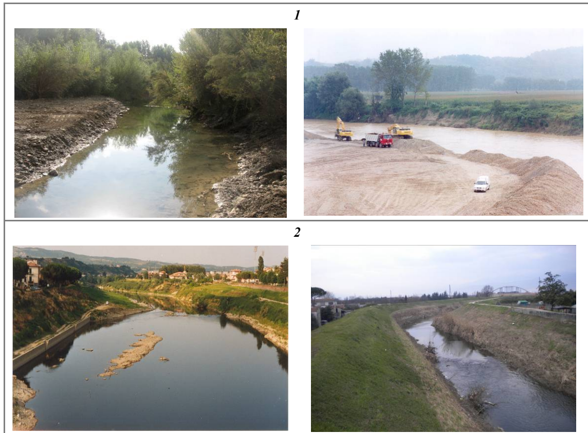
Figura 40 – Alterazioni della variabilità della sezione in alvei semi- non confinati. (1) Casi di parziale o omogeneizzazione della sezione per interventi di riprofilatura; (2) omogeneità della sezione per tratti esposti a causa di eccessiva artificializzazione.
