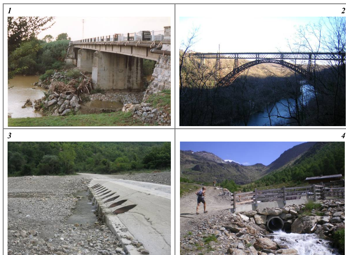
Figura 63 – Opere di attraversamento. (1) Ponte con interferenze sulla dinamica fluviale; (2) opera di attraversamento estranea al corridoio fluviale; (3) guado con tominature; (4) tominatura.
