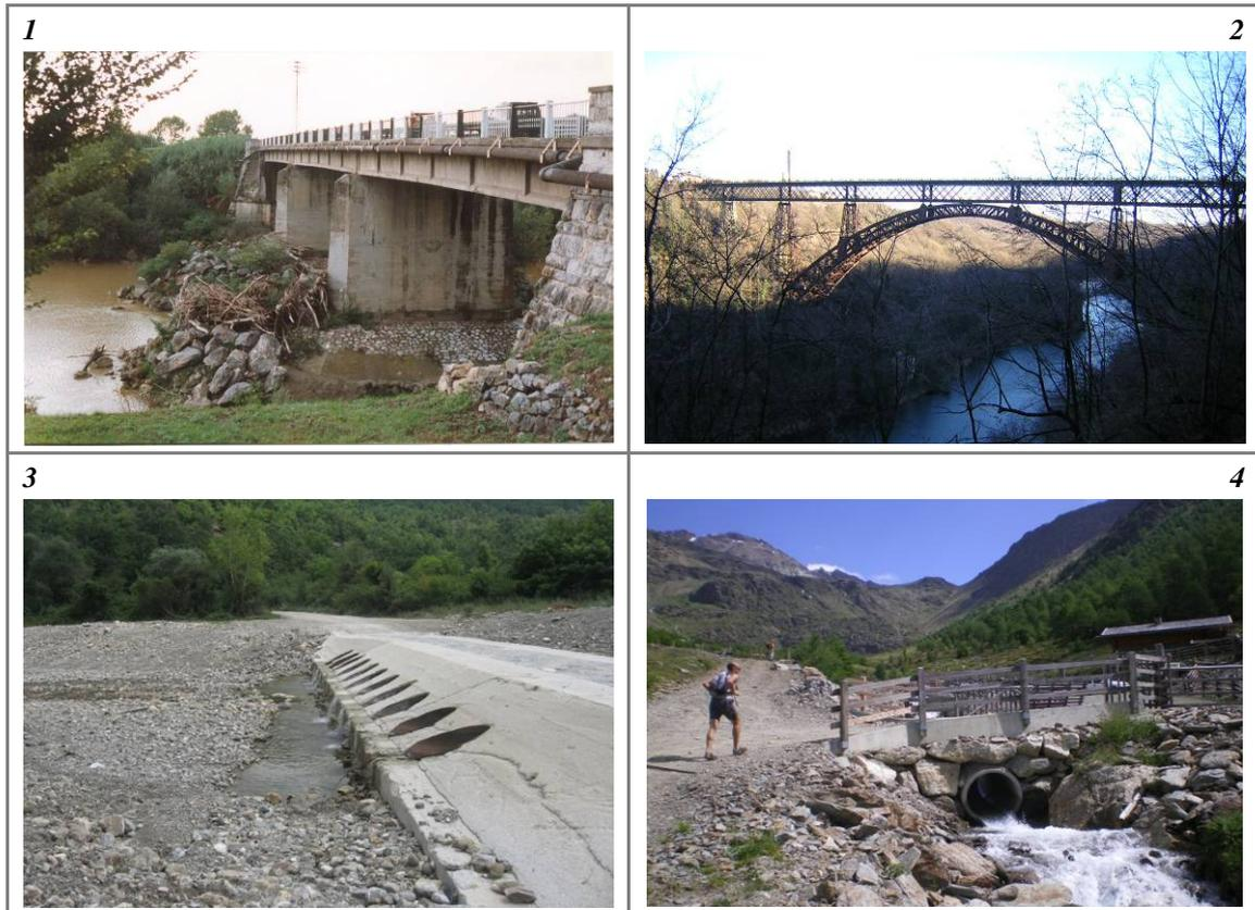
**Figura 63** – Opere di attraversamento. (1) Ponte con interferenze sulla dinamica fluviale; (2) opera di attraversamento estranea al corridoio fluviale; (3) guado con tombinate; (4) tombinatura.
