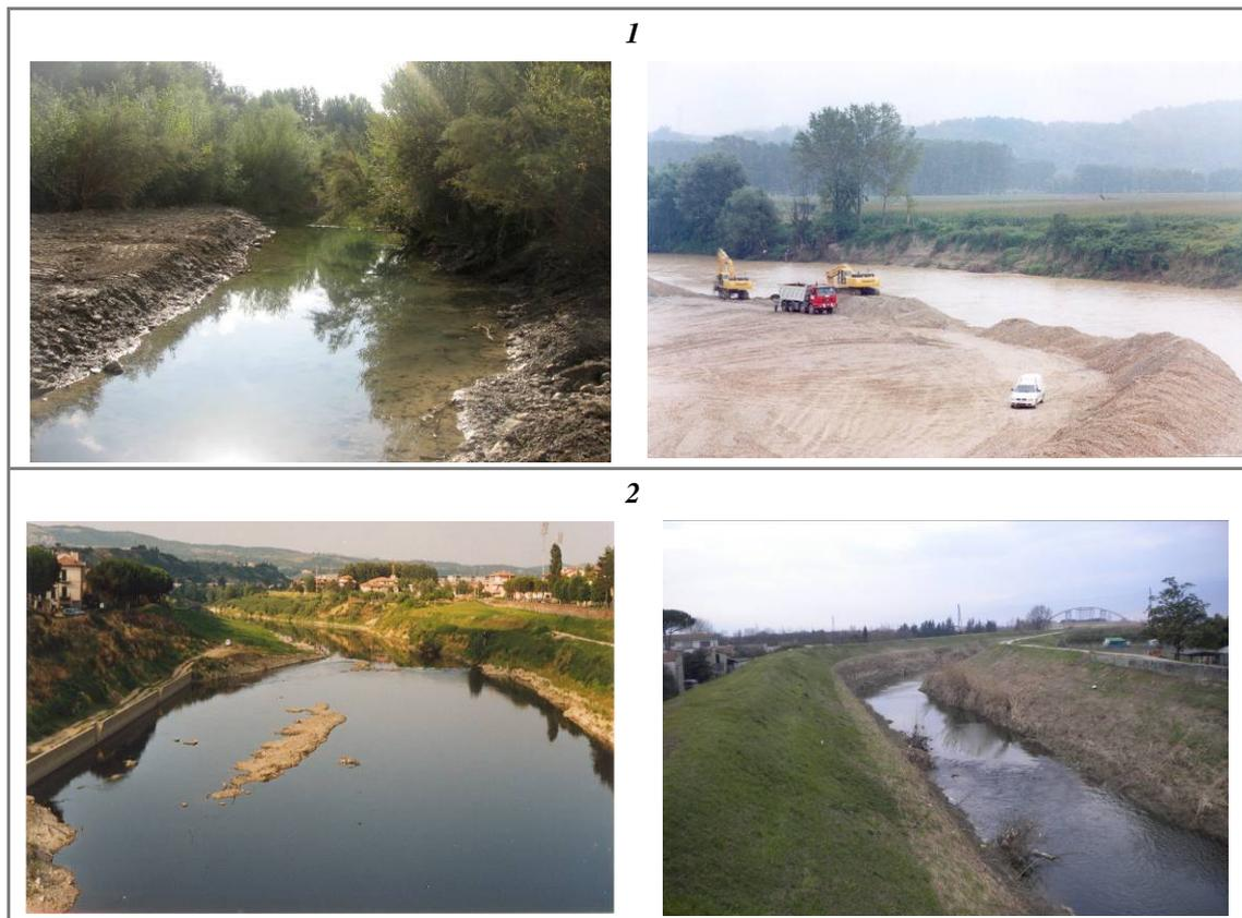
**Figura 40** – Alterazioni della variabilità della sezione in alvei semi- non confinati. (1) Casi di parziale omogeneizzazione della sezione per interventi di riprofilatura; (2) omogeneità della sezione per tratti estesi a causa di eccessiva artificializzazione.
