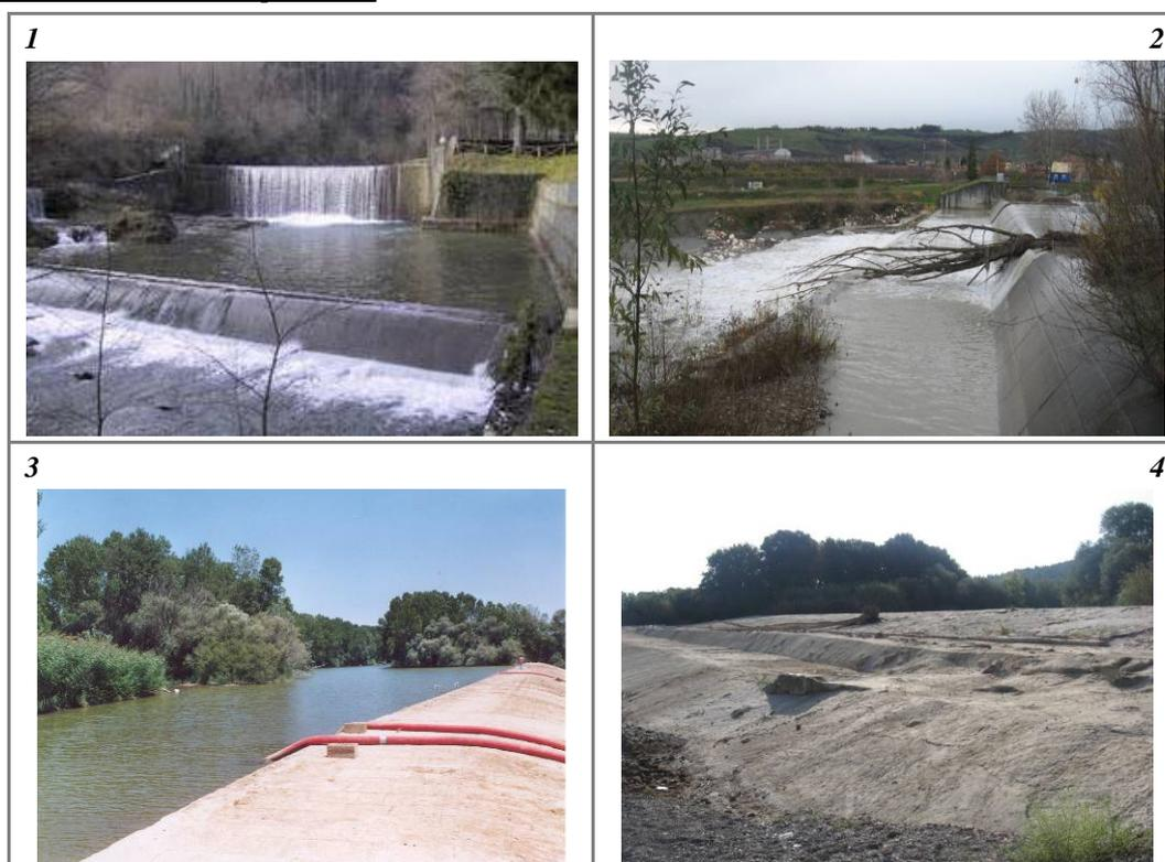
**Figura 56** – Opere trasversali di alterazione delle portate solide in ambito collinare-di pianura. (1) Briglia; (2) traversa; (3) traversa di derivazione non colmata; (4) traversa di derivazione colmata.
