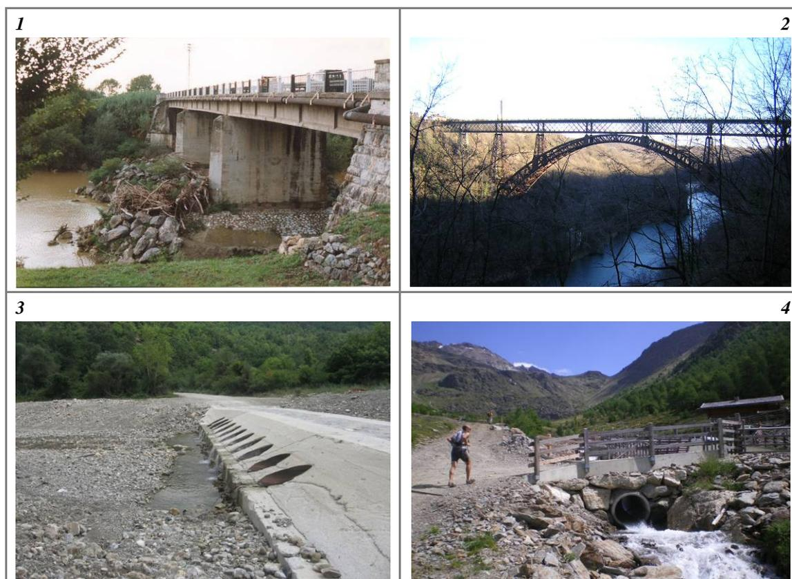
**Figura 63** – Opere di attraversamento. (1) Ponte con interferenze sulla dinamica fluviale; (2) opera di attraversamento estranea al corridoio fluviale; (3) guado con tombinature; (4) tombinatura.
