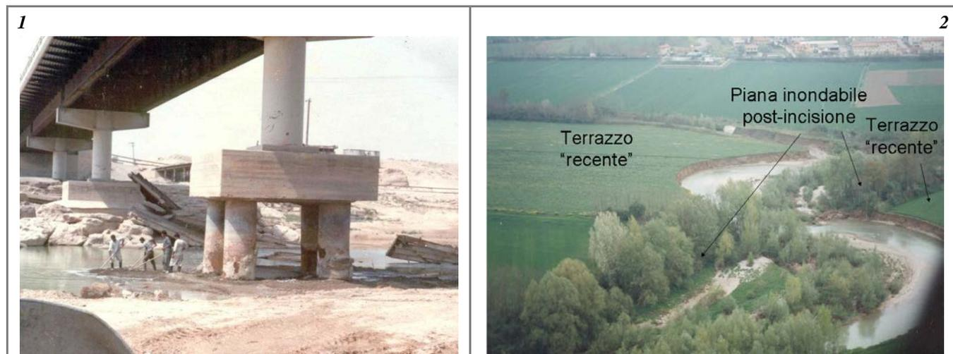
**Figura 81** – Evidenze sul terreno di incisione. (1) Erosione alle pile dei ponti; (2) dislivelli tra piana inondabile post- incisione e terrazzo recente (corrispondente alla piana inondabile pre-incisione).
