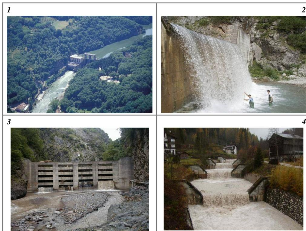
**Figura 55** - Opere trasversali di alterazione delle portate solide in ambito montano. (1) Diga; (2) briglia di trattenuta a corpo pieno; (3) briglia di trattenuta aperta; (4) sequenza di briglie di consolidamento a gradinata.
