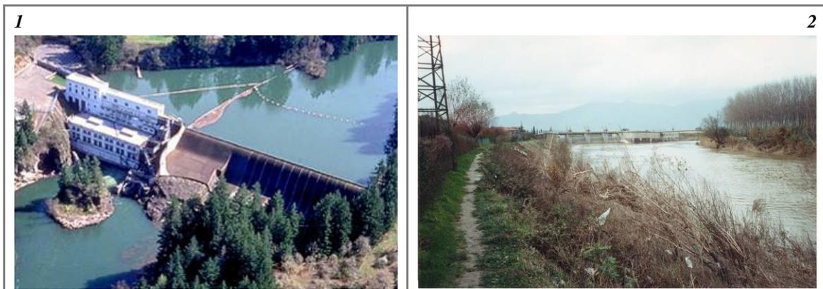
**Figura 52** – Alterazione delle portate liquide. Tipiche opere di alterazione. (1) Diga; (2) scolmatore.
