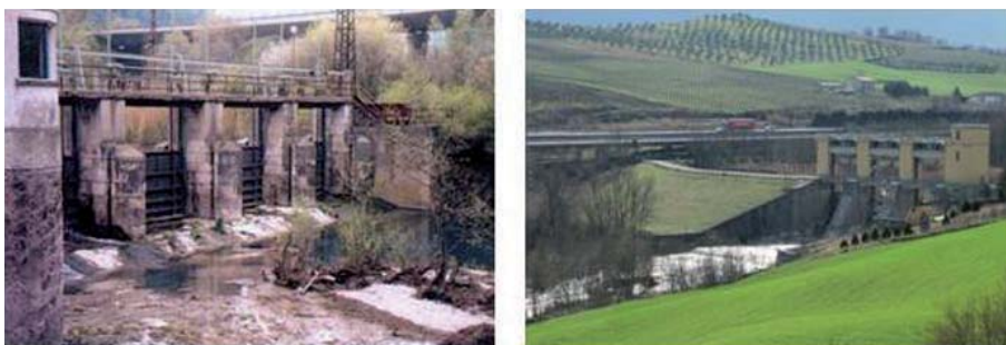
Fig. 17 - A destra: sbarramento ENEL sul fiume Pescara. A sinistra: diga di Alanno sul fiume Pescara
