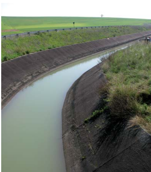
Fig. 10 - La cementificazione degli argini crea un habitat non idoneo alla presenza della lontra per l'assenza di vegetazione sulle rive, l'aumento della velocità del flusso e della torbidità, e per la riduzione della disponibilità trofica. Foto: M. Marrese
