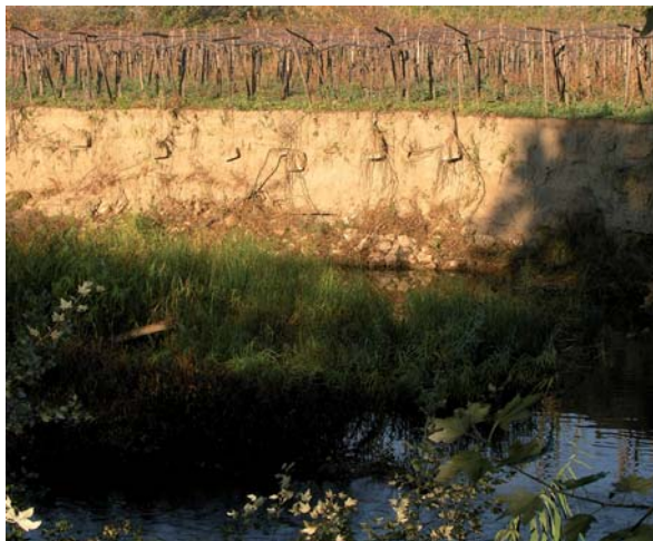
Fig. 13 - Vigneto abusivo sull'argine. Foto: M. Marrese
