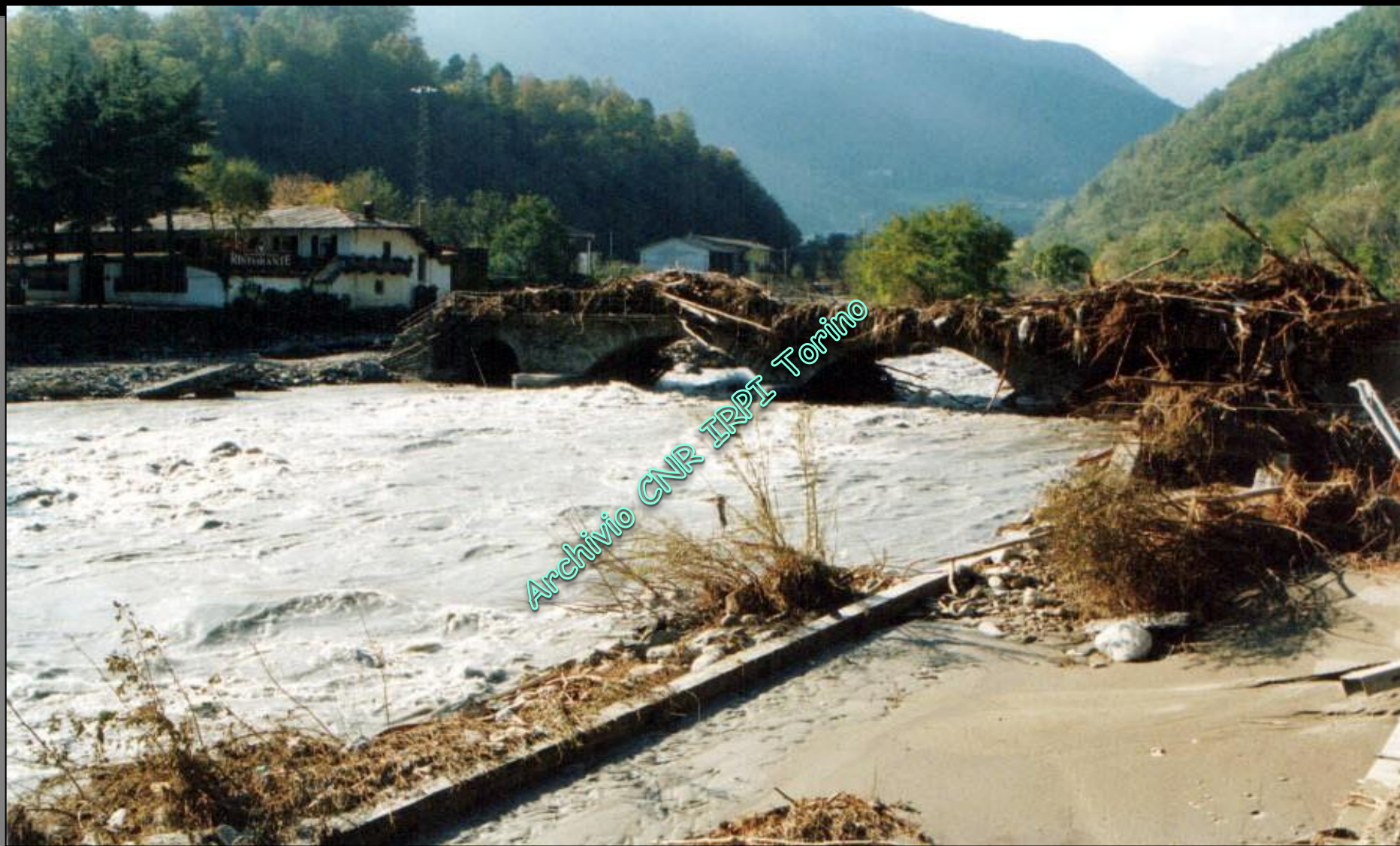
Ponte Palestro sul T. Chisone a Porte (TO)
