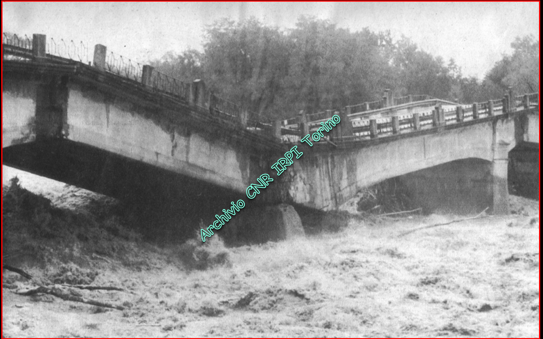
Ponte di Feletto sul T. Orco
