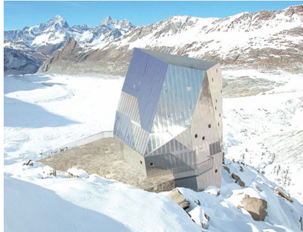
Solare Fotovoltaico: nuovo rifugio Monte Rosa
