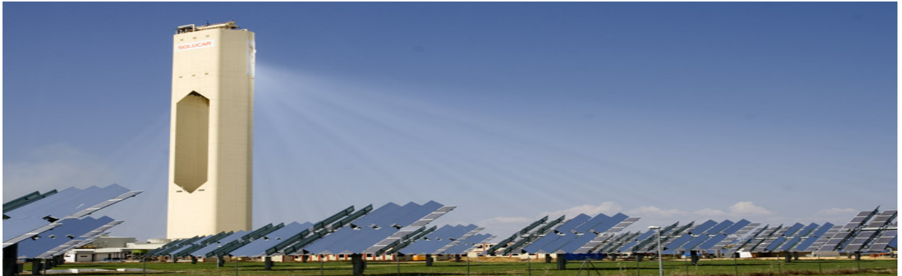
Solar Power Tower – Sanlucàr la Mayor, Seville -Spain
