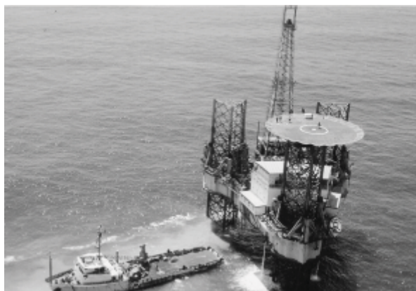
Fig.4 - Piattaforma di perforazione offshore.
