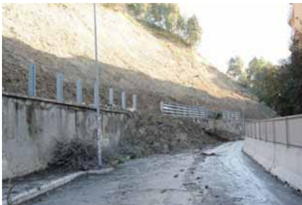
Colata superficiale di detrito a Via Labriola, Monte Mario; Dicembre 2008 (Foto Marco Amanti)
