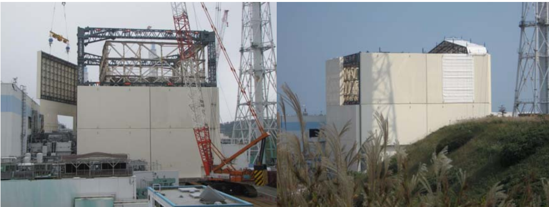
Fig. 3 e 4 Fasi di copertura dell'edificio reattore
