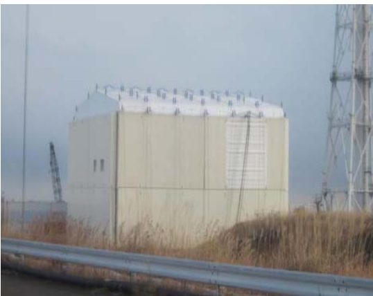
Fig. 5 Copertura ultimata dell'edificio reattore dell'Unità 1.
