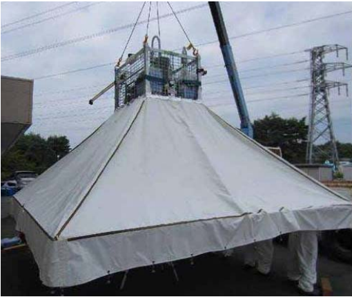
Fig. 2 Sistema usato per campionare posizionato tramite gru
