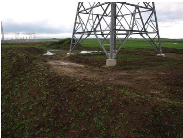
Foto 77 - Base di traliccio e particolare delle zoppicature, SE di S. Severo. (Foto G. Sauli, febbraio 2010)
