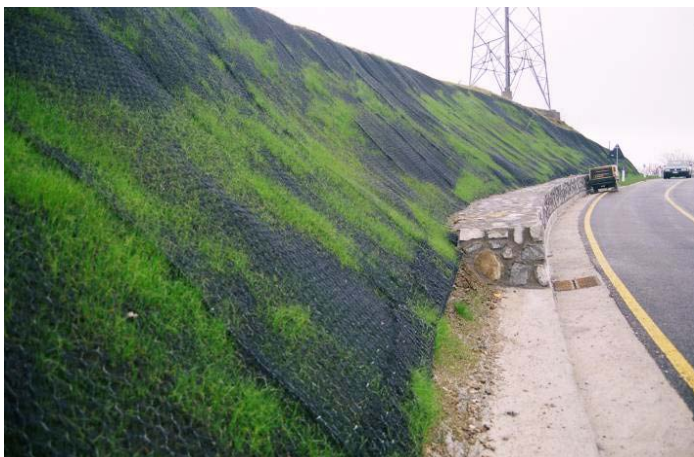
Foto 8 - Rivestimento di scarpate in roccia arenacea con geocomposito in rete metallica e stuoia sintetica tridimensionale. Grande Viabilità Trieste. (Foto G. Sauli, 2007)
