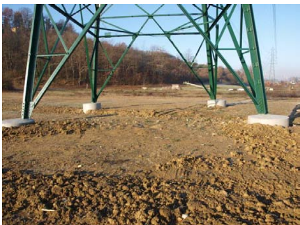
Foto 79 - Zoppicature di altezza differenziata. Traliccio in località S. Barbara (Scandicci, FI). (Foto G. Sauli, gennaio 2010)
