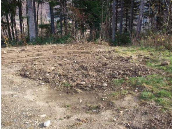
Foto 92 - Base di un traliccio demolito con ricomposizione del suolo; Loc. Omegna (VB). (Foto G. Sauli, dicembre 2009)
