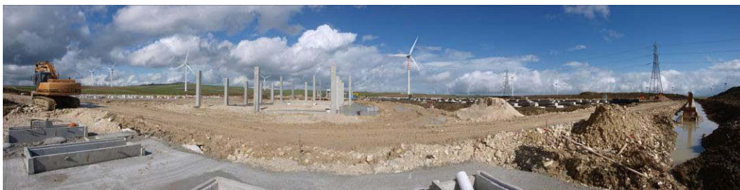
Foto 59 – SE di Bisaccia (AV) in costruzione. Panoramica dell'intera area di cantiere. (Foto G. Sauli, febbraio 2010)
