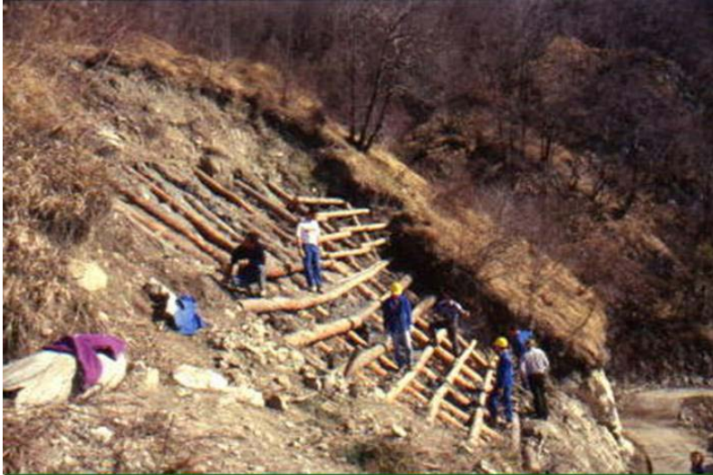
Foto 37 - Realizzazione di grata viva di versante. Montenars (UD). (Foto G. Sauli, ottobre 1999)
