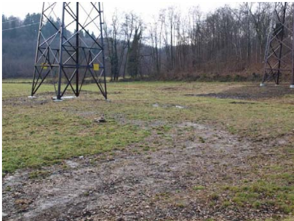
Foto 94 - Demolizioni e nuove costruzioni in parallelo con ricomposizione del suolo; Borgomanero (NO). (Foto G. Sauli, dicembre 2009)
