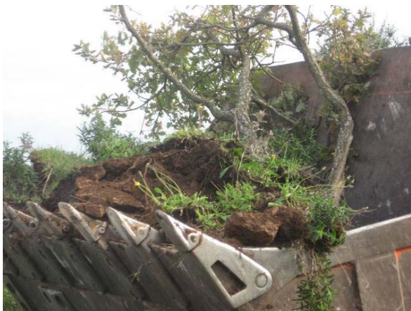
Foto 13 - Espianto con mezzo meccanico. SE di Ittiri (SS). (Foto M. Testone, novembre 2009)
