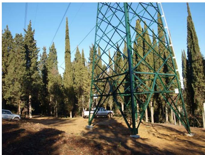
Foto 105 - Altro caso di resinose che interferiscono con le catenarie della linea elettrica. Va applicata la tecnica del taglio raso e non la capitozzatura. S. Barbara, Scandicci ( FI). (Foto G. Sauli, dicembre 2010)
