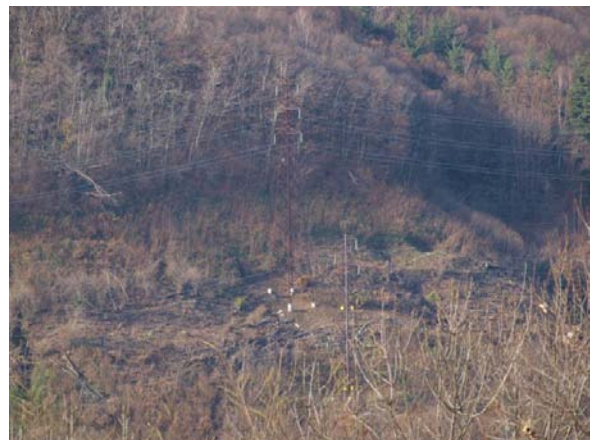
Foto 101 - Fascia di taglio del bosco a mezza costa lungo il tracciato. Valle Ossola loc. Anzola. (Foto G. Sauli, dicembre 2009)
