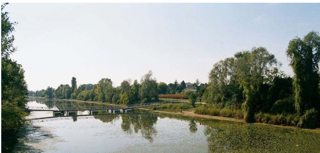
Foto 75 – Area di costruzione di una linea a pali monostelo, stato ante operam . Idrovia Padova-Venezia (Vigonovo -VE). (Foto G. Sauli)
