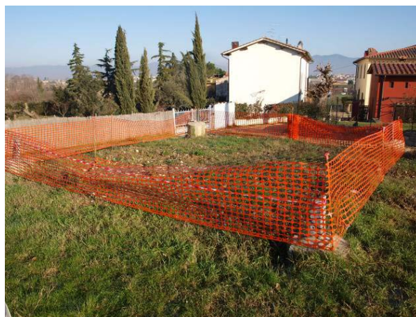
Foto 87 – Minicantiera per la demolizione di un vecchio traliccio; S. Barbara (Scandicci, FI). (Foto G. Sauli, gennaio 2010)
