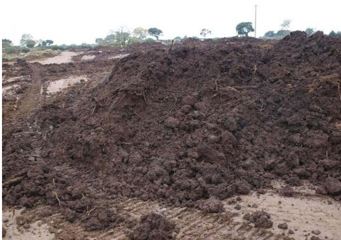
Foto 5 – Le operazioni di scavo e accumulo del suolo vanno sospese con tempo piovoso. Ittiri (SS) dicembre 2009. (G. Sauli)
