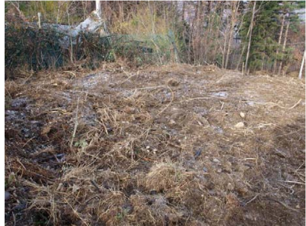
Foto 93 - Base di un traliccio demolito con ricomposizione del suolo; Loc. Omegna (VB). (Foto G. Sauli, dicembre 2009)
