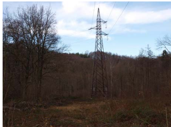
Foto 103 - Taglio raso della boscaglia per il posizionamento dei tralicci della nuova linea (132 kV). Valle Ossola loc. Anzola. (Foto G. Sauli, dicembre 2009)
