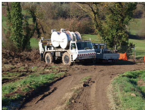
Foto 85 – Postazione di lavoro per tesatura; S. Barbara (Scandicci, FI). (Foto G. Sauli, gennaio 2010)
