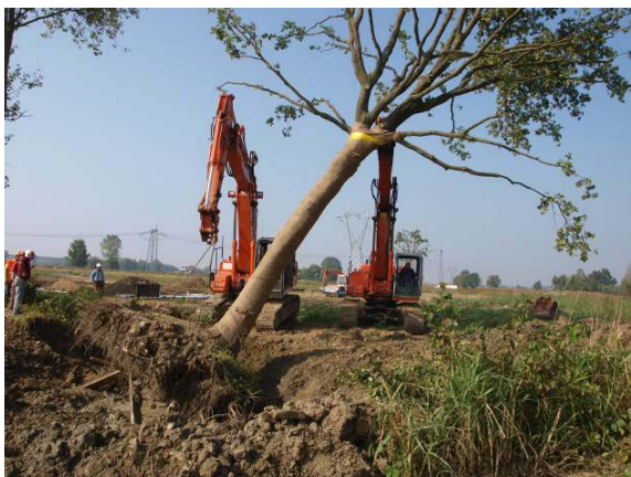
Foto 25 –Operazioni di trapianto di Querce d’alto fusto. SE di Chignolo Po (PV). (Foto G. Sauli, settembre 2010)
