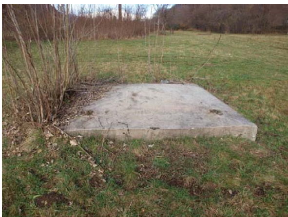
Foto 90 - Operazioni di demolizione di tralicci in area a prato; Borgomanero (NO). (Foto G. Sauli, dicembre 2009)
