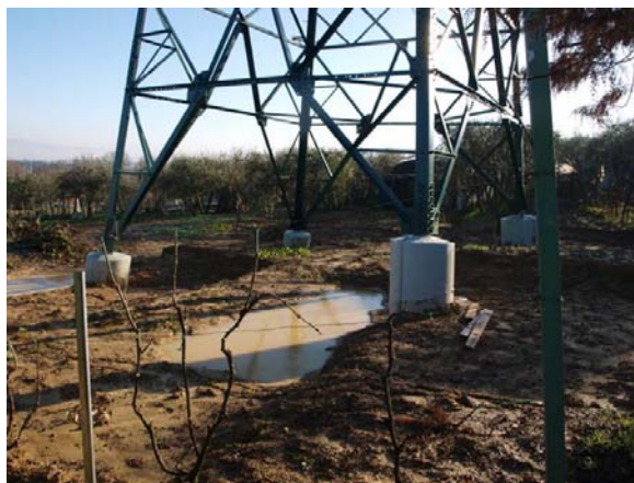
Foto 78 - Zoppicature di altezza differenziata. Traliccio posizionato in un'area collinare ad oliveti in località S. Barbara (Scandicci, FI). (Foto G. Sauli, gennaio 2010)
