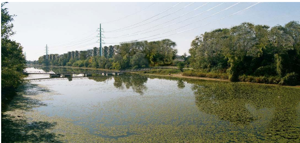
Foto 76 - Linea a pali monostelo con filare associato. Simulazione fotografica stato finale. Idrovia Padova-Venezia (Vigonovo -VE).
