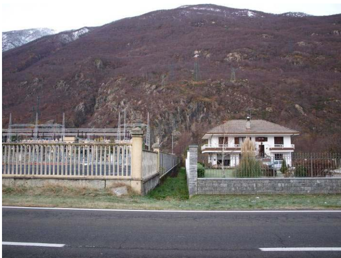
Foto 62 –La costruzione adiacente alla SE non consente di realizzare una fascia verde di mascheramento. SE di Pallanzeno (VB). (Foto G. Sauli, dicembre 2009)
