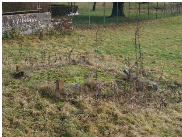
Foto 89 – Operazioni di demolizione di tralicci in area a prato; Borgomanero (NO). (Foto G. Sauli, dicembre 2009)
