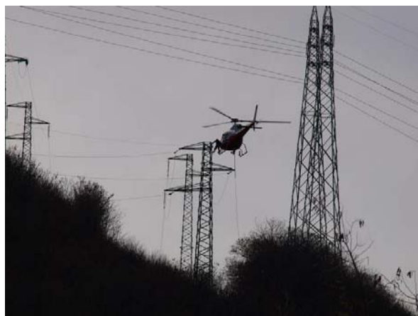
Foto 91 – Lavori di demolizione con uso di elicottero sulla linea Loc. Omegna (VB). (Foto G. Sauli, dicembre 2009)
