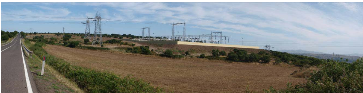
Foto 55 - Panoramica reale della stazione elettrica di Ittiri (SS) costruita. Stato al 24.6.2011 prima degli interventi a verde. (Foto G. Sauli)
