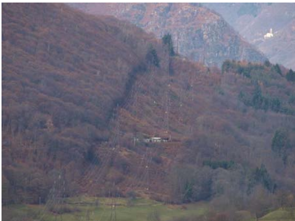
Foto 102 - Fascia di taglio del bosco lungo il tracciato a mezza costa. Valle Ossola loc. Anzola. (Foto G. Sauli, dicembre 2009)
