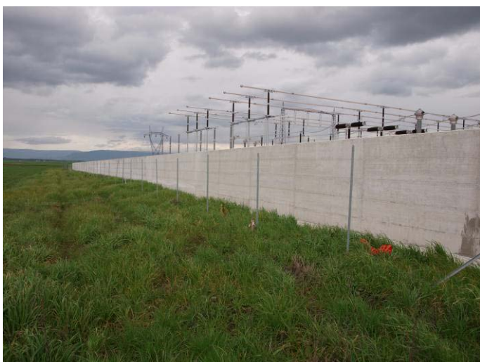
Foto 43 - Muro recinzione in cls, antincendio ed antiintrusione. SE di S. Severo (FG) a servizio della Centrale a turbogas in costruzione. (Foto G. Sauli, febbraio 2010)
