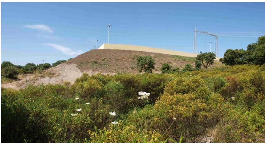
Foto 57 – Stazione elettrica di Ittiri (SS), scarpate prima degli interventi a verde, sughereta e gariga a cisti dell'area circostante. (Foto G. Sauli, giugno 2011)
