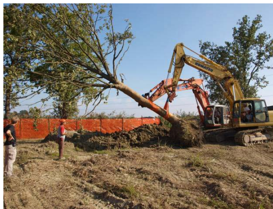
Foto 26 –Operazioni di trapianto di Querce d’alto fusto. SE di Chignolo Po (PV). (Foto G. Sauli, settembre 2010)
