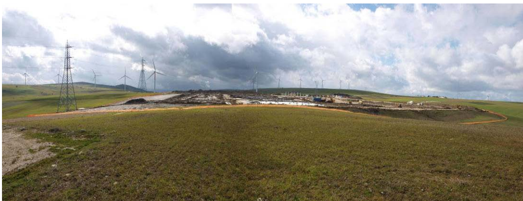
Foto 58- SE di Bisaccia (AV) in costruzione. Panoramica da nord con ampie scarpate in rilevato a valle. (Foto G. Sauli, febbraio 2010)
