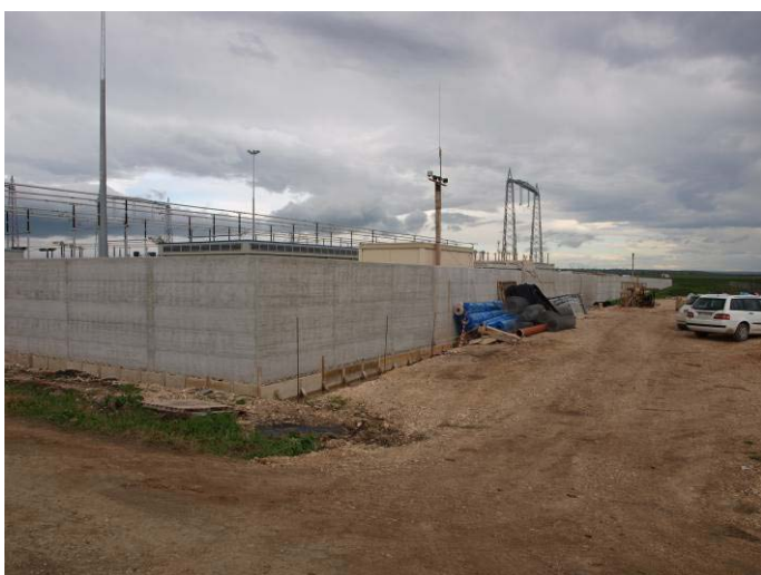
Foto 42 - Vista esterna del muro di recinzione in cls antincendio ed antiintrusione. SE di S. Severo (FG) a servizio della Centrale a turbogas in costruzione. (Foto G. Sauli, febbraio 2010)
