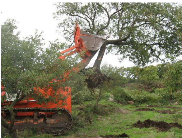
Foto 17- Fasi finali dell'operazione di trapianto. SE di Ittiri (SS). (Foto M. Testone, novembre 2009)
