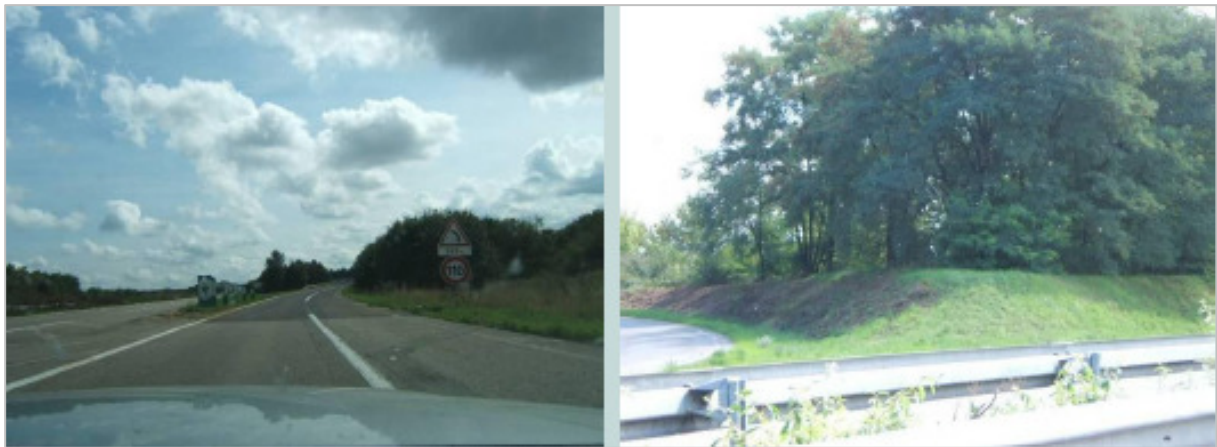
Figura 3.7 – Lo svincolo è evidenziato dalla separazione fisica creata dalla quinta di verde (a sinistra) a sua volta enfatizzata da un rilievo del terreno (a destra). M.Minelli da Manuali e Linee Guida ISPRA 65.5/2010 – pag.78
