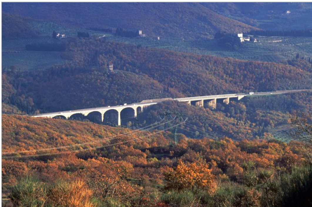
Figura 3.3 - Viadotto dell'Autostrada del Sole A1 in località Calenzano (FI) (M. Bacci). da Rapporto ISPRA 87/2008
