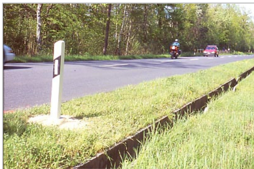
Figura3.10 - Barriera per Anfibi lungo una strada presso Yverdon (Svizzera). M. Dinetti. da Rapporto ISPRA 87/2008
