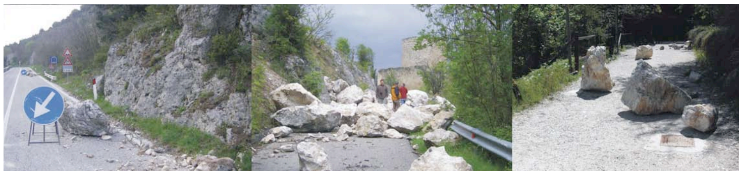
Alcuni dei crolli di massi calcarei indotti dal terremoto abruzzese del 6 Aprile 2009 (dati ISPRA).
