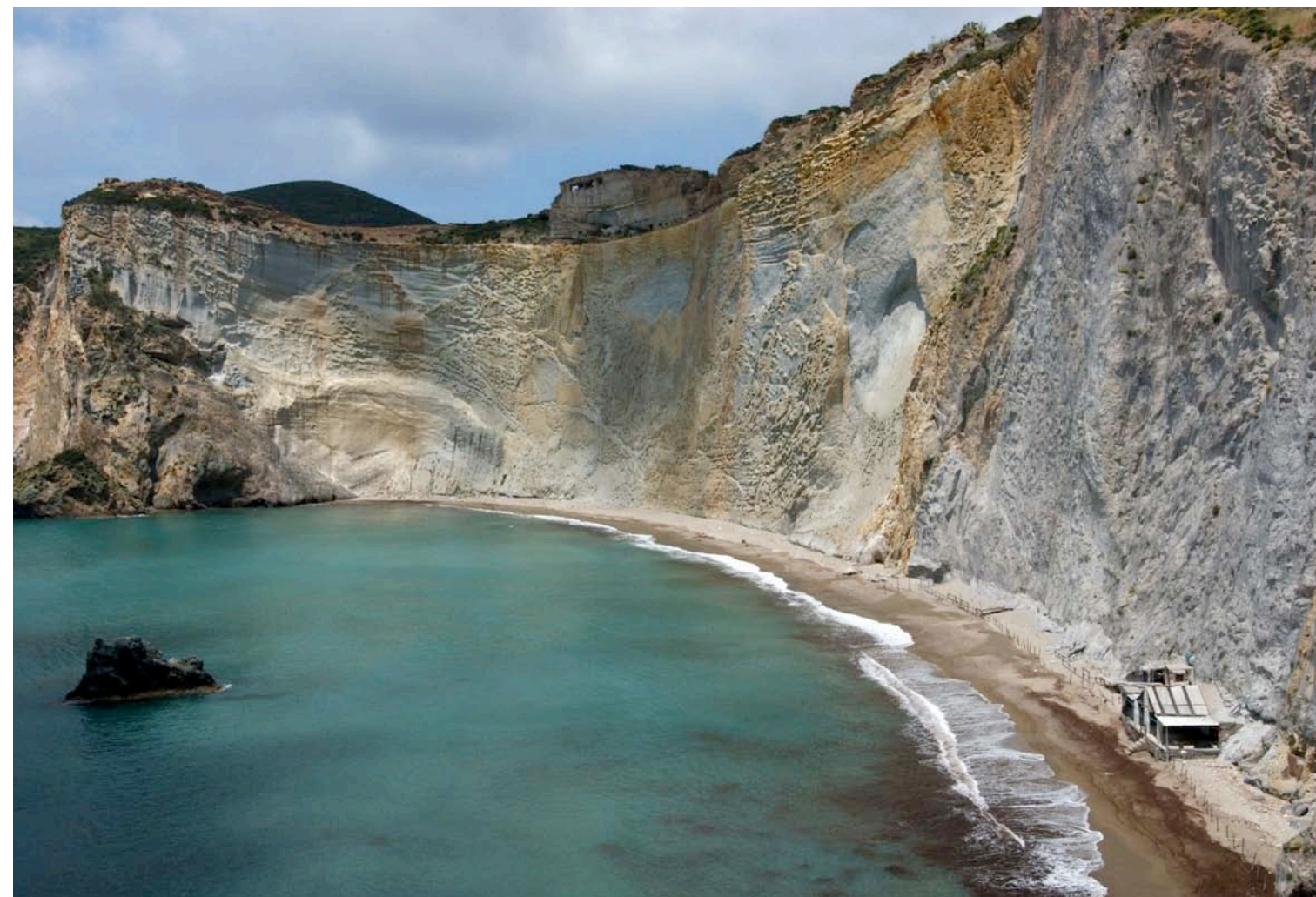
In primo piano la rete di contenimento, a sostegno della parete nord di Chiaia di Luna (Ponza), dichiarata pericolante (Paolo Orlandi/ISPRA)
