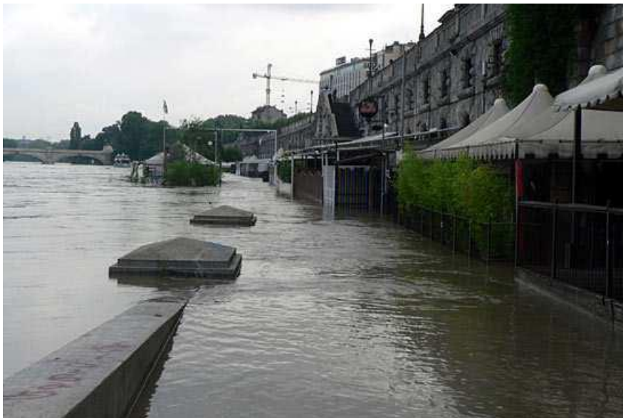
Figura 2.16: Comune di Torino, loc. Murazzi. La piena del Po ha interessato la sponda sinistra, nel tratto compreso tra il ponte di Piazza Vittorio e il Borgo Medievale. Foto: La Stampa (www.lastampa.it).
