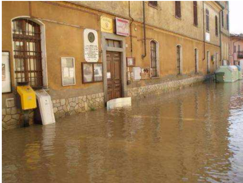
Figura 2.12: Le due foto mostrano la grandinata, e il conseguente allagamento, che ha colpito Villafranca (Piemonte) il 5 maggio 2010 (Fonte: ARPA Piemonte).
