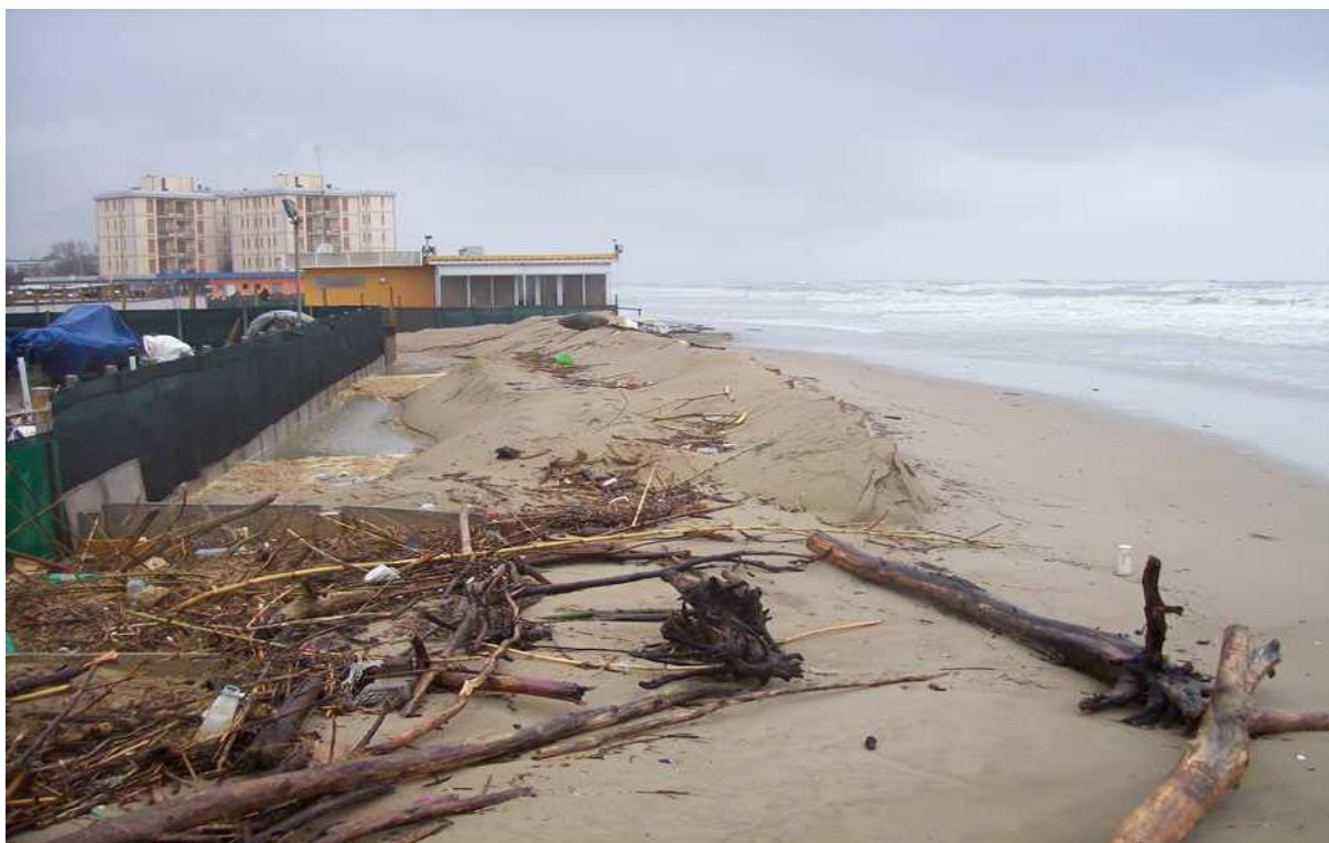
Figura 2.7: Gli effetti della mareggiata del 9-10 marzo 2010 lungo la costa ravennate nella località Lido Adriano. Fonte: ARPA Emilia-Romagna.
