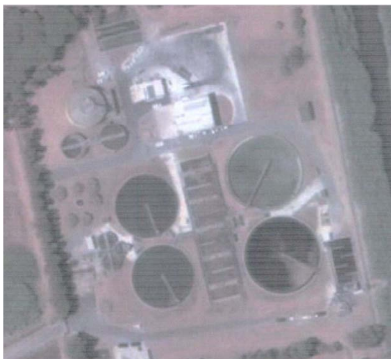
Figura 2. Fotografia aerea dell'impianto di depurazione di Fregene (RM).
