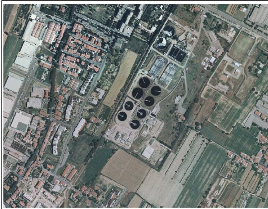
Figura 2. Veduta aerea dell'impianto di depurazione di Baciacavallo (Prato).
