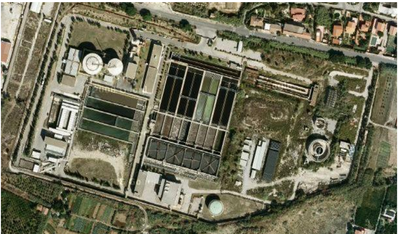
Figura 2. Fotografia aerea dell'impianto di depurazione di Acqua dei Corsari (PA).
