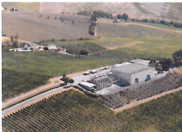
Vista aerea da SudOvest del sito di produzione
