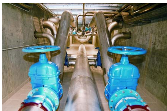
Serbatoio „Monte di Stegona“
