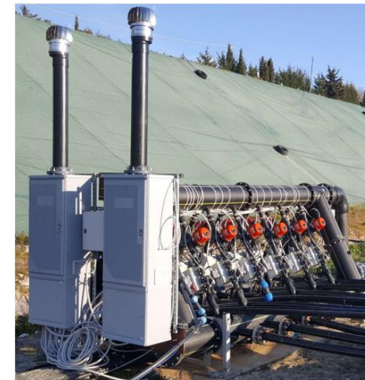
Stazione di regolazione dotata di sistema GAS STABILIZER, installato a Gennaio 2020 e regolarmente funzionante, presso una discarica sita nella Regione Marche
