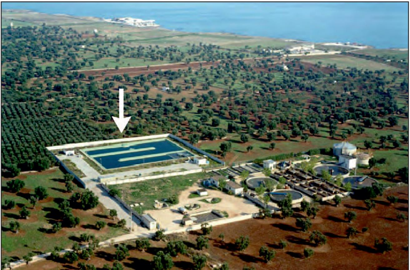
Fig. 24.7 - Impianto di depurazione e contiguo impianto di affinamento (freccia) di Fasano (BR).
