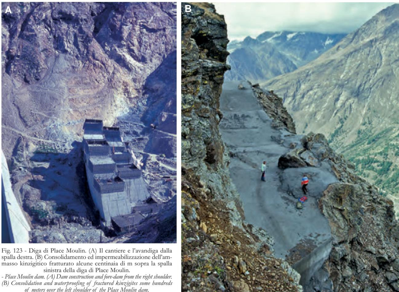
Fig. 123 - Diga di Place Moulin. (A) Il cantiere e l'avandiga dalla spalla destra. (B) Consolidamento ed impermeabilizzazione dell'ammasso kinzigitico fratturato alcune centinaia di m sopra la spalla sinistra della diga di Place Moulin.
