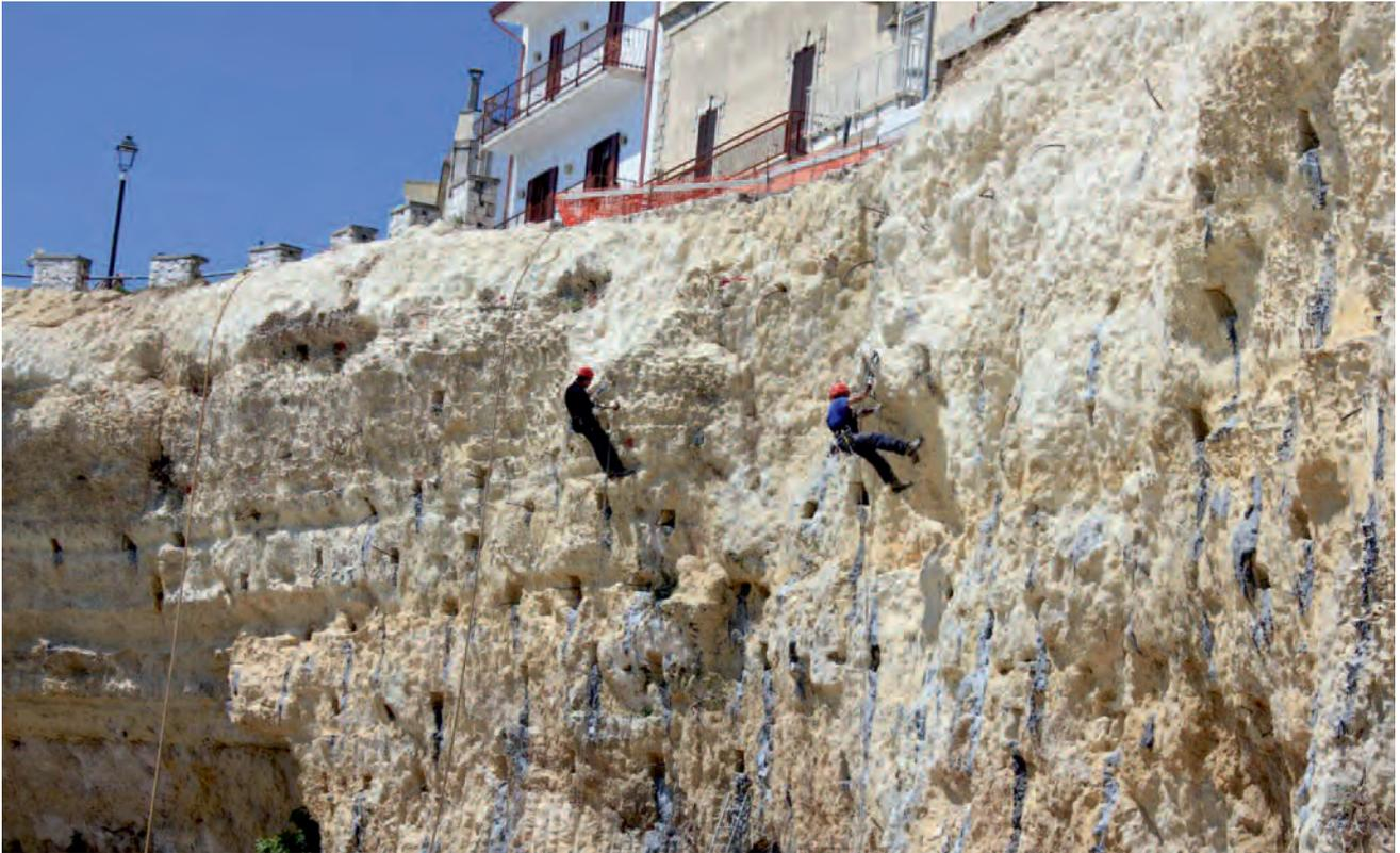
Fig. 18.70 - Formazione calcarenitica di Uggiano La Chiesa. Falesia lungo la spiaggia di Otranto (LE), laddove si notano i placcaggi con barre di acciaio inox eseguiti in acrobatica per la stabilizzazione della formazione fratturata e fortemente degradata.
