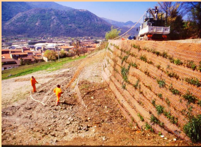
Intervento di idrosemina su terra rinforzata stradale. Atina (FR) 2001 (Foto P. Cornelini).
