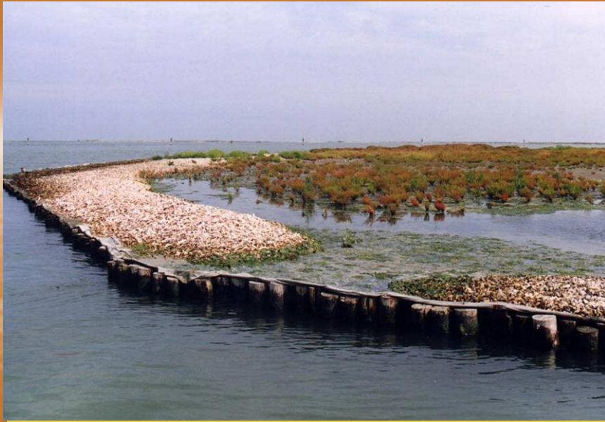
Foto 17 e 18: Ricostruzione di barene con fanghi di dragaggio; contenimento con pali e geotessuti (Località La Vallona – Po di Levante RO)
