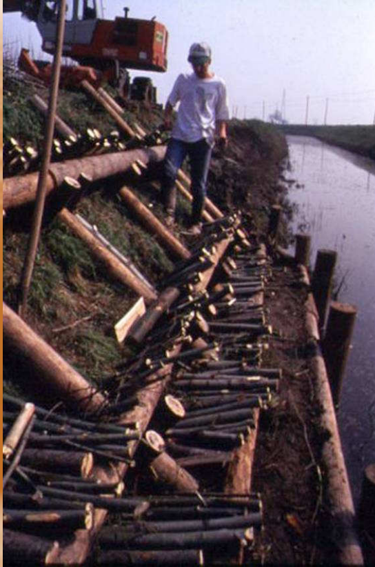
Foto 14: Palificata e grata viva con salici in un canale del delta Po in prov. di Rovigo in fase di realizzazione e
