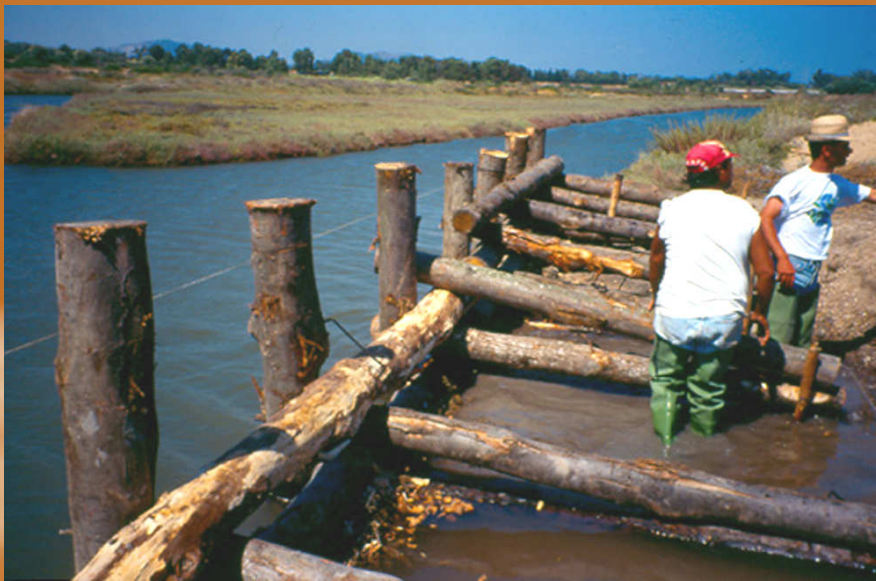
Foto 56: Laguna di Nora (CA), palificata spondale con palo infisso e fascine di tamerici, 1996 - Foto G. Sauli
