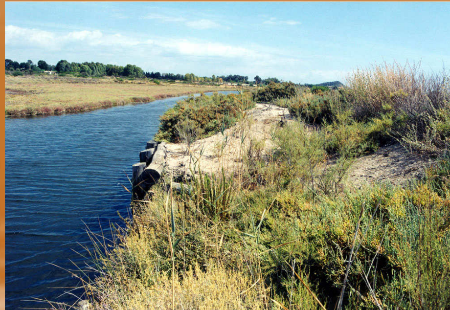
Foto 59: Laguna di Nora (CA), palificata spondale con palo infisso e fascine di tamerici, in primo piano effetti del rullo spondale settembre 2003 - Foto G. Sauli
