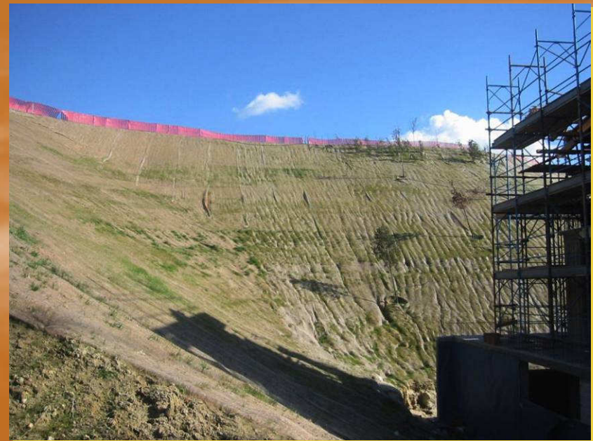
Foto 40 e 41: Scarpate artificiali su terreni sabbiosi con evidenti fenomeni erosivi nonostante l’impiego di biostuoie inerbite, P. Cornellini
