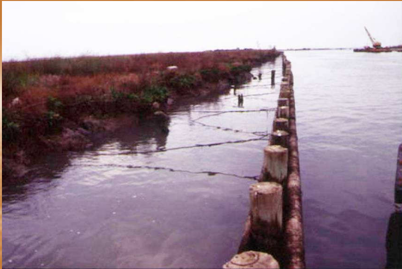
Foto 10 e 11: Prove, scarsamente efficaci, di consolidamento in tronchi e tavole tirantati, con messa a dimora di tamerici per lo stoccaggio di fanghi di drenaggio di canali lagunari ( Laguna di Grado GO e Marano UD ) G. Sauli
