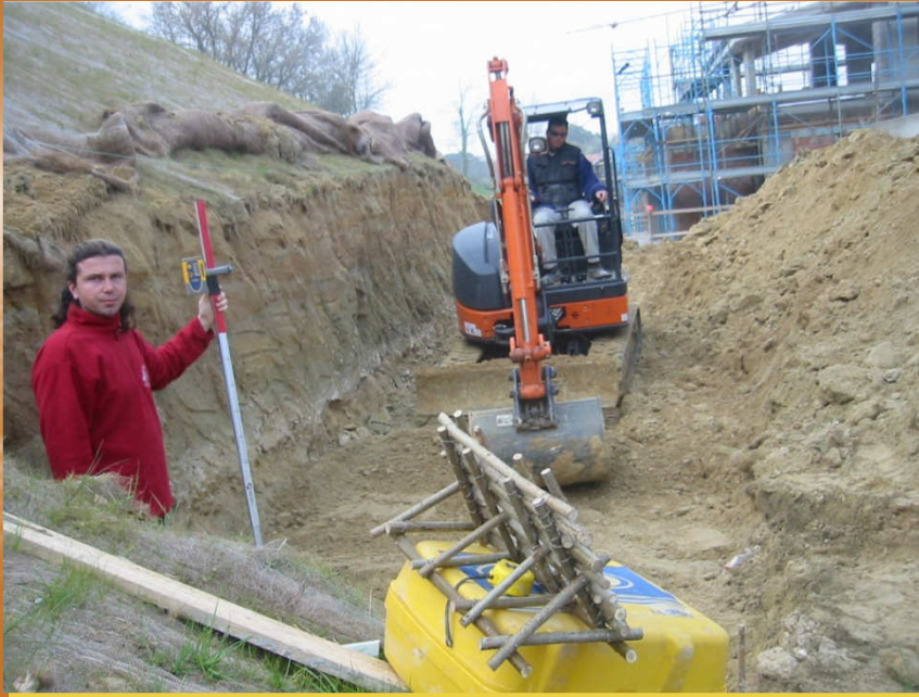
Consolidamento del piede scarpate delle case con palificate vive Roma
