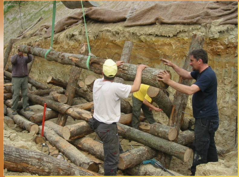
Consolidamento del piede scarpate delle case con palificate vive Roma
