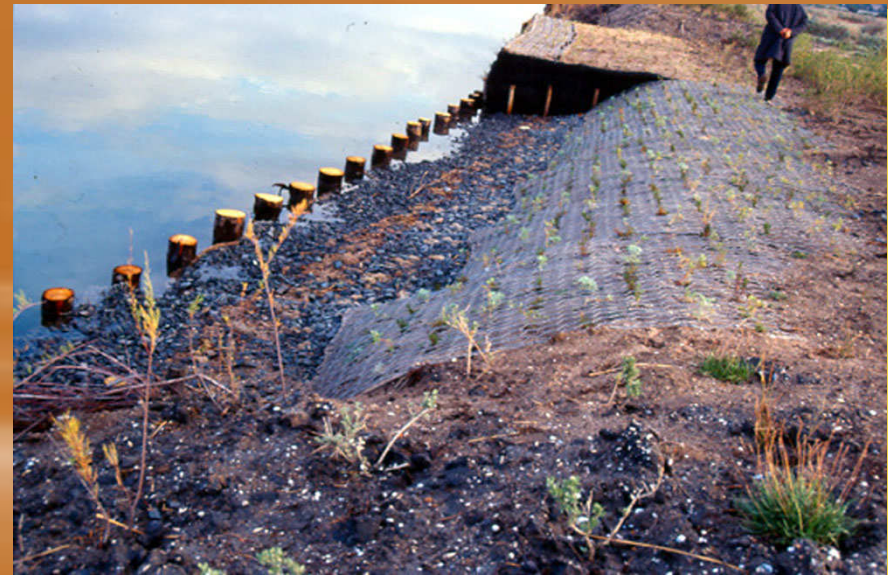
Foto 54: Terra rinforzata verde, materassi verdi spondali. Laguna di Nora (CA) 1996 - Foto G. Sauli
