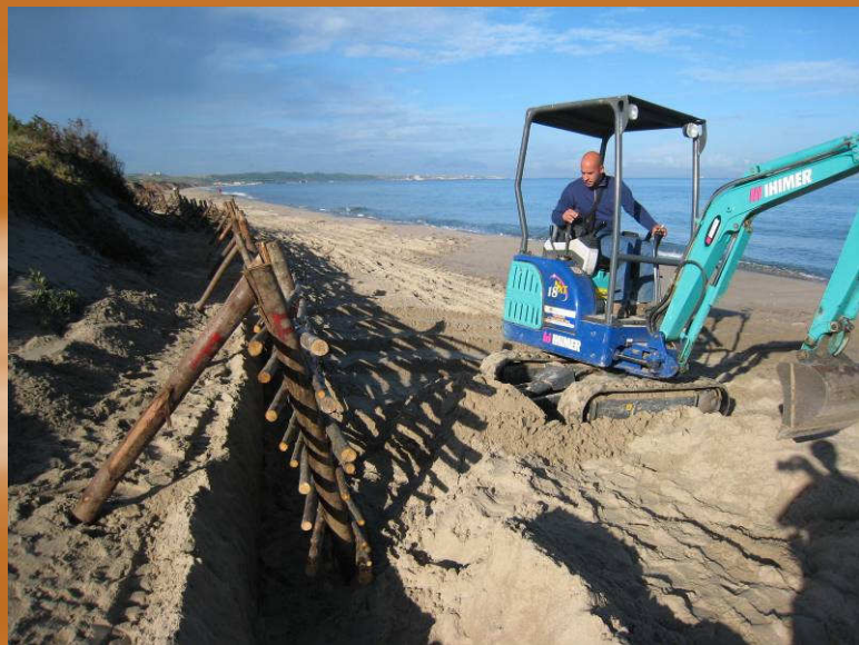
Foto 36: Realizzazione delle graticciate, P. Cornellini
