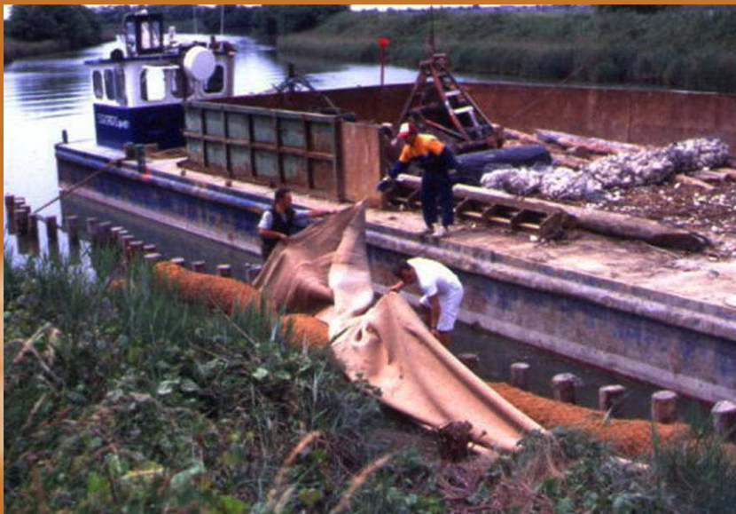
Foto 12: Consolidamento spondale di un canale perilagunare con tronchi, rulli di cocco, geotessuti e fibre miste abbinati a fascine di Tamerice e Foto 13 lo stesso dopo un anno ( fiume Natissa, Laguna di Grado GO ) G. Sauli
