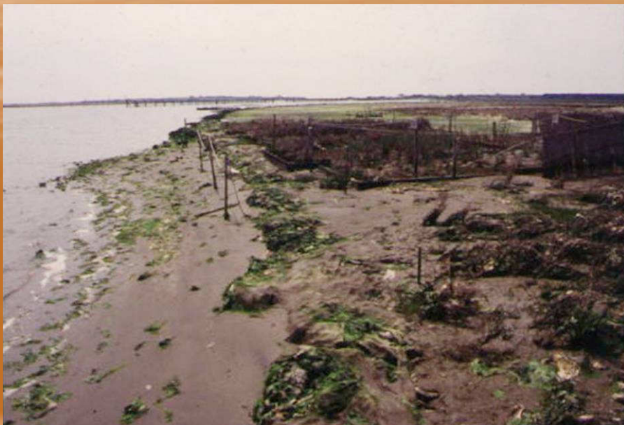
Foto 21 e 22: Ricostruzione di isolotti con dragaggi a matrice sabbiosa con prove di messa a dimora di specie alofile (Laguna di Caleri Po di Levante RO) G. Sauli
