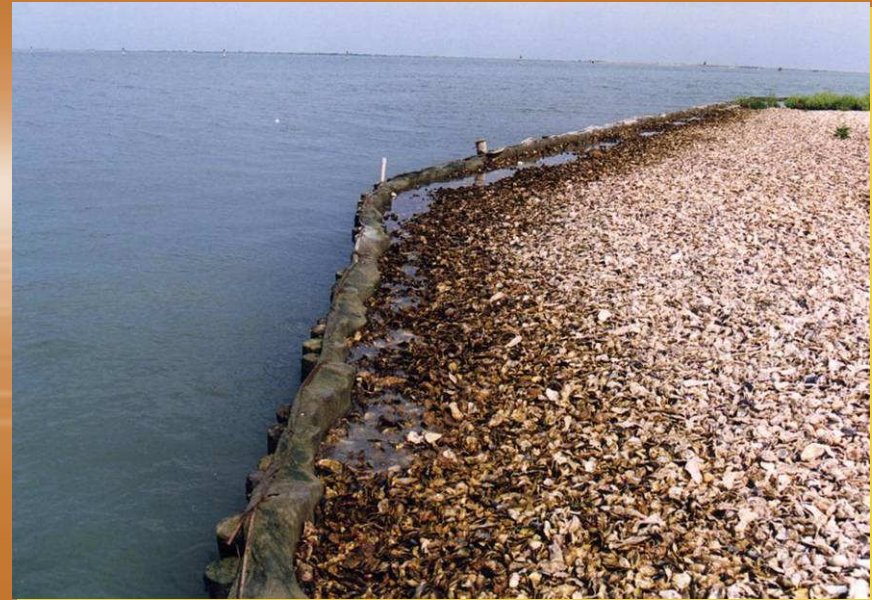
Foto 17 e 18: Ricostruzione di barene con fanghi di dragaggio; contenimento con pali e geotessuti (Località La Vallona – Po di Levante RO)
