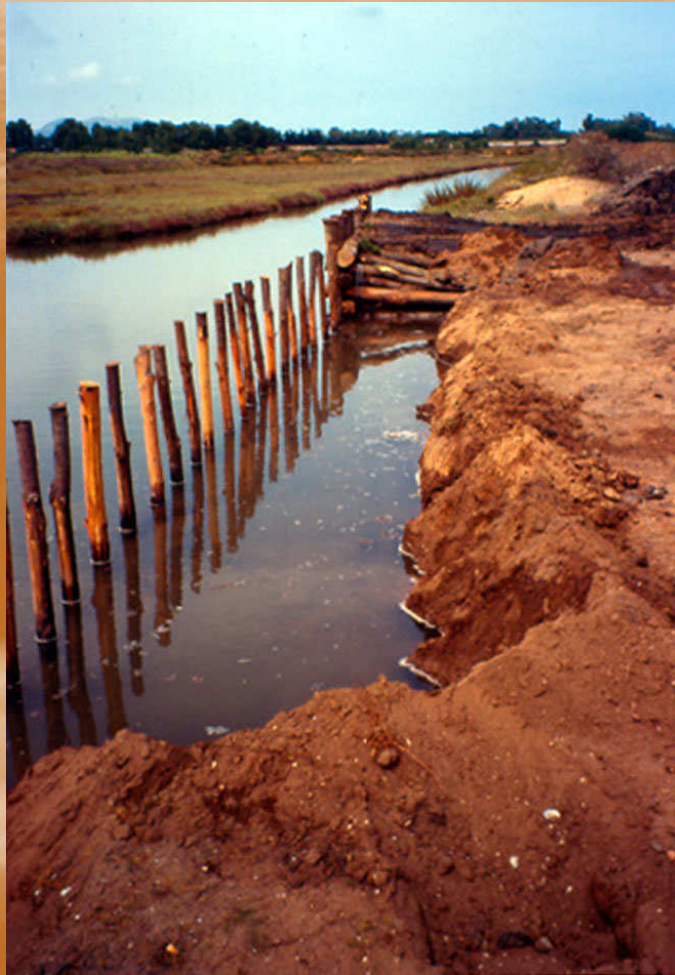
Foto 58: Laguna di Nora (CA), rullo spondale, fase di costruzione 1996 - Foto G. Sauli
