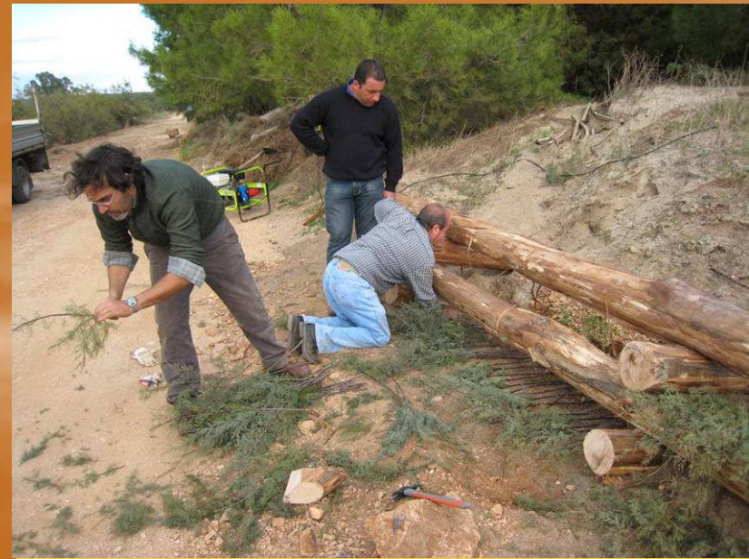
Foto 31: Realizzazione di una palificata viva con inserimento di talee di Tamerice, P. Cornelini
