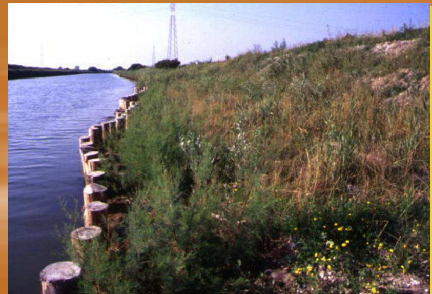
Foto 12: Consolidamento spondale di un canale perilagunare con tronchi, rulli di cocco, geotessuti e fibre miste abbinati a fascine di Tamerice e Foto 13 lo stesso dopo un anno ( fiume Natissa, Laguna di Grado GO ) G. Sauli
