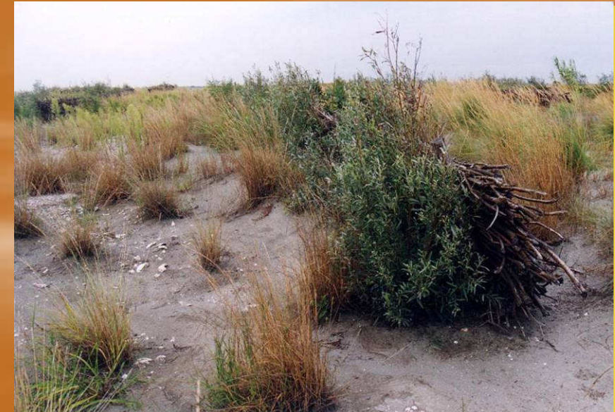
Foto 19 e 20: Stabilizzazione di cordoni dunali mediante graticciate e trapianti di cespi di Ammophila arenaria e graticci con legno morto e vivo ( Salix alba ) (Località La Vallona – Po di Levante RO) G. Sauli
