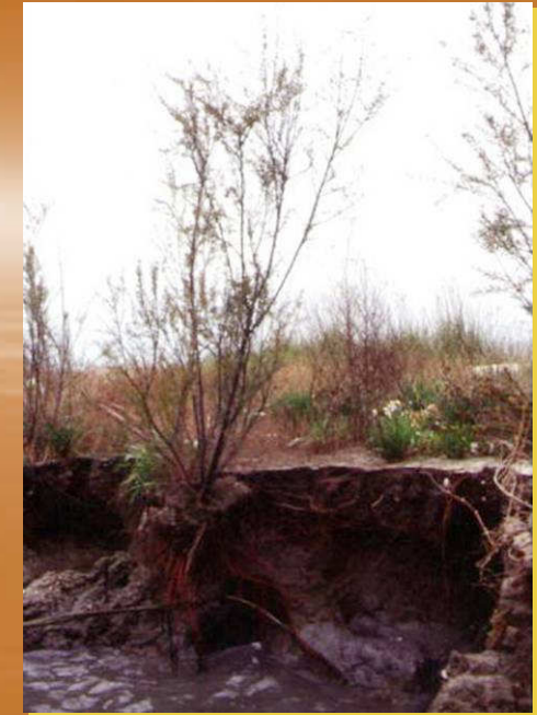
Foto 10 e 11: Prove, scarsamente efficaci, di consolidamento in tronchi e tavole tirantati, con messa a dimora di tamerici per lo stoccaggio di fanghi di drenaggio di canali lagunari ( Laguna di Grado GO e Marano UD ) G. Sauli
