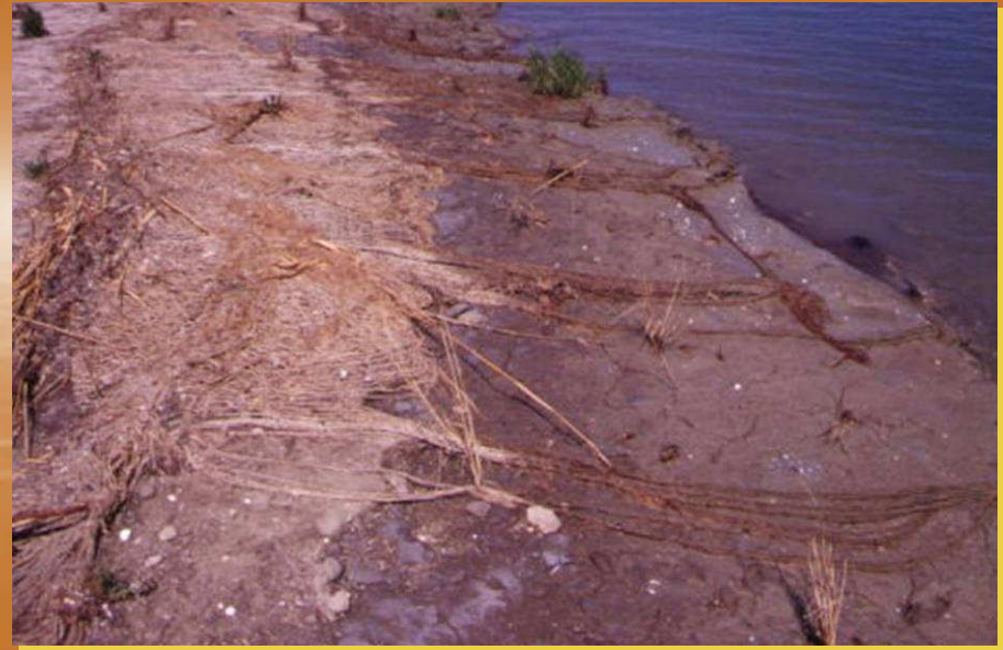
Foto 4: Totale inefficacia dell'impiego di stuoie di juta quale antierosivo spondale, G. Sauli
