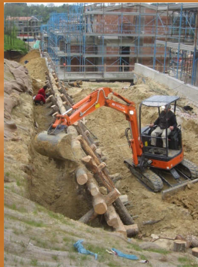
Consolidamento del piede scarpate delle case con palificate vive Roma
