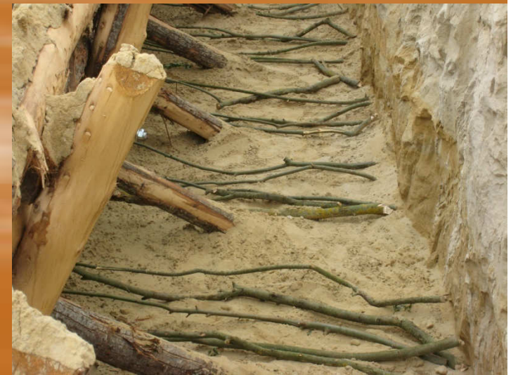
Consolidamento del piede scarpate delle case con palificate vive Roma
