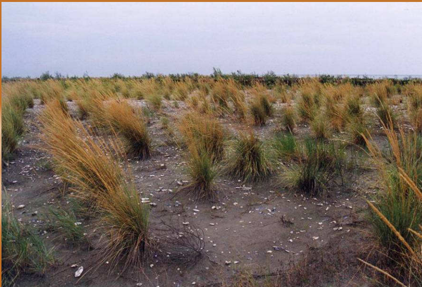
Foto 19 e 20: Stabilizzazione di cordoni dunali mediante graticciate e trapianti di cespi di Ammophila arenaria e graticci con legno morto e vivo ( Salix alba ) (Località La Vallona – Po di Levante RO) G. Sauli
