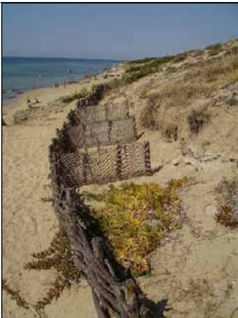
Schermi frangivento a protezione della vegetazione di nuovo impianto (Foto Luciano Onori – ISPRA - 2008)
