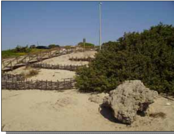
Viminate basali e chiudenda in legno a protezione delle dune (Foto Luciano Onori – ISPRA - 2008)
