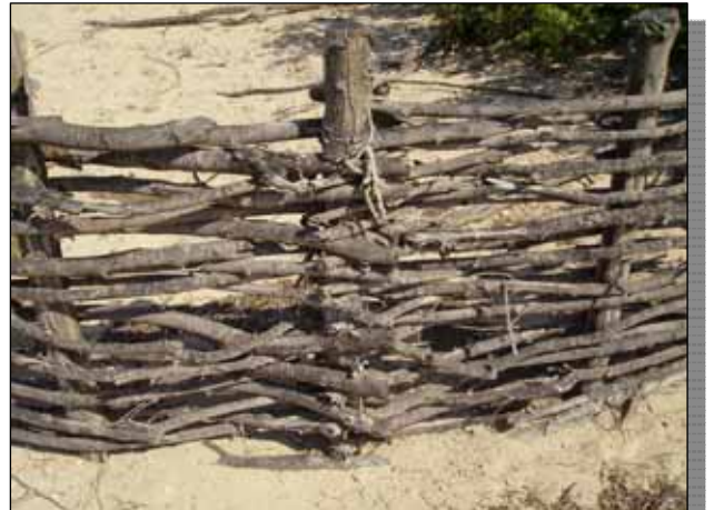
Viminate basali e chiudenda in legno a protezione delle dune (Foto Luciano Onori – ISPRA - 2008)
