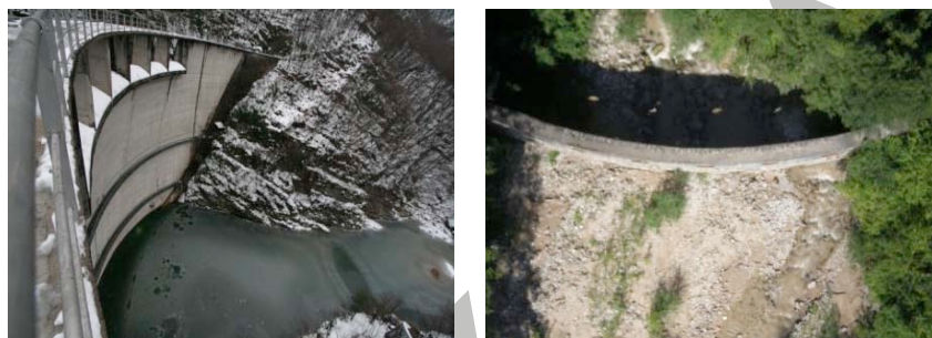
Figura 6 – Esempi di opere trasversali che possono determinare per i corpi idrici immediatamente a valle di esse le condizioni di cui al caso 4 previsto in Tabella 1. A sinistra diga, a destra briglia di trattenuta non colmata.
