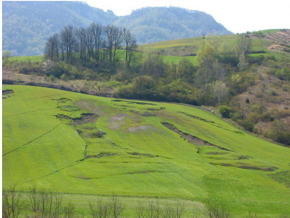
Frane superficiali, Montesegele (PV)
