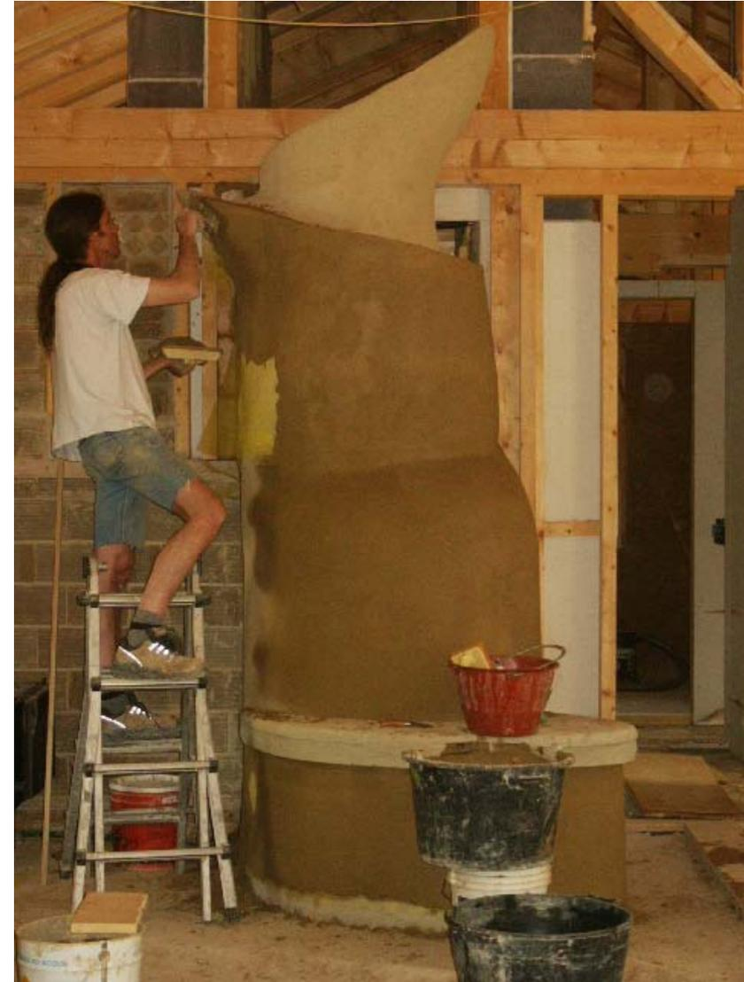
La stufa ad accumulo, per il rilascio graduale del calore, è la soluzione ideale per chi vuole scaldare a biomasse un edificio dal basso fabbisogno energetico
