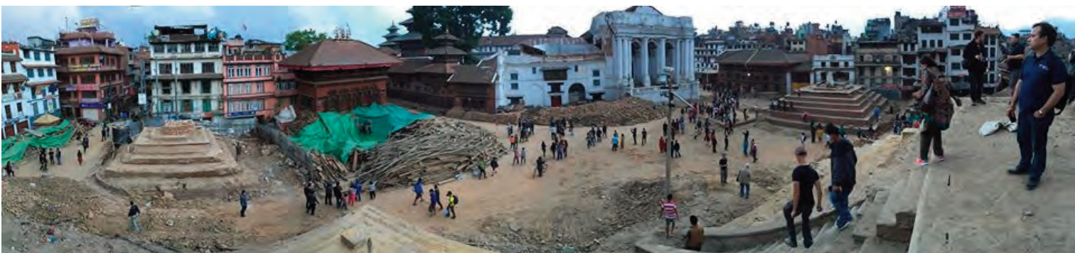
Fig. 2: Danni provocati dal sisma nella valle di Katmandu
